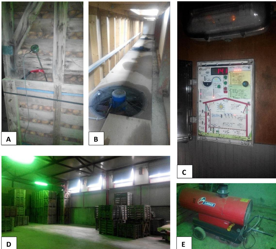
**Figura 3. Equipos reguladores de la temperatura. A:** Sondas de temperatura. **B:** Ventiladores y ventanales de entrada de aire. **C:** Autómata. **D:** Ventanales laterales de salida de aire e iluminación verde. **E:** Equipo calefactor.
