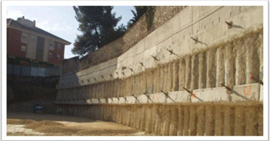
*Figura 7. Anclaje de pilotes junto a edificio contiguo. Fuente:*
