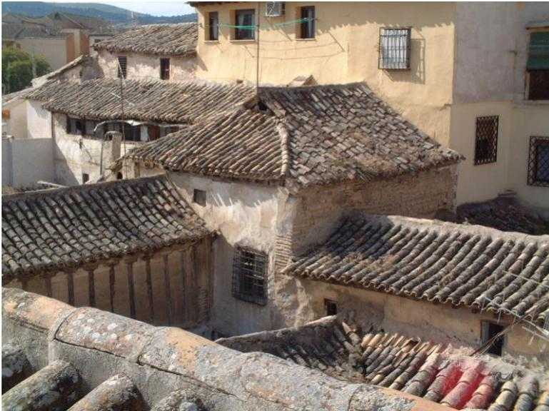
*Figura 11. Detalle de asentamiento de faldones en cubierta de madera. Fuente: <https://consorcioletoledo.files.wordpress.com>*
