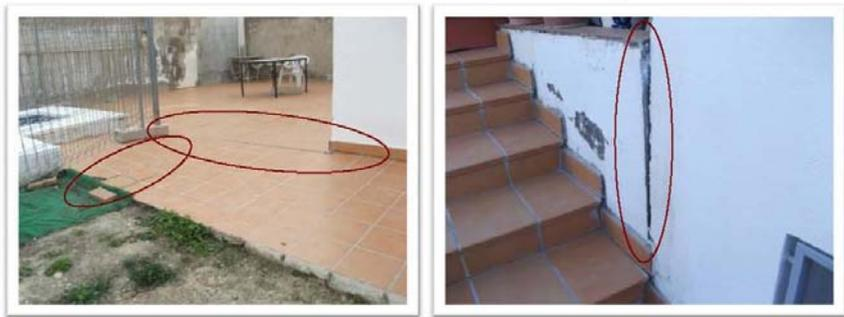
*Figura 5. Rotura de solado por asentamiento de edificio. Fuente: <https://elblogdeperytas.files.wordpress.com>*
