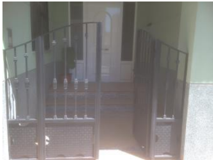
Figura 51: Protección entrada principal. Año 2015. Fuente propia.
