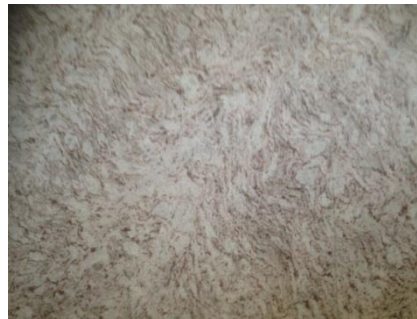
Figura 36: Granito escalera y hall de la vivienda. Año 2015. Fuente propia.
