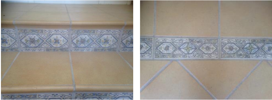
Figura 35: Cenefa peldañeado y pavimento. Año 2015. Fuente propia.
