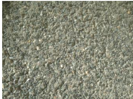
Figura 44: Monocapa fachada principal. Año 2015. Fuente propia.
