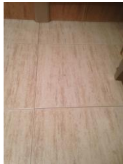
Figura 40: Solado cuarto de aseo. Año 2015. Fuente propia.
