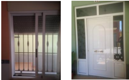
Figura 47: Carpintería exterior PVC, puerta acceso principal. Año 2015. Fuente propia.
