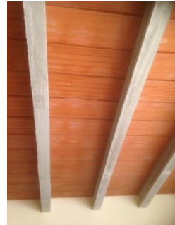
Figura 34: Parte inferior cubierta. Año 2015. Fuente propia.
