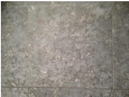
Figura 37: Gres colocado en salón-comedor de la planta baja. Año 2015. Fuente propia.
