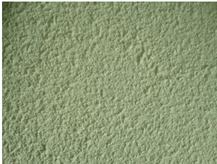
Figura 44: Monocapa fachada principal. Año 2015. Fuente propia.
