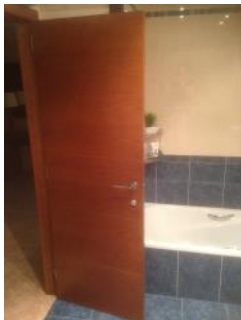
Figura 39: Solado cuarto de baño. Año 2015. Fuente propia.
