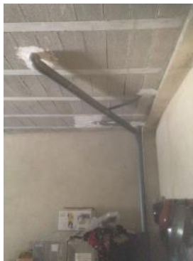
Figura 31: Tuberías saneamiento planta baja. Año 2015.Fuente propia.
