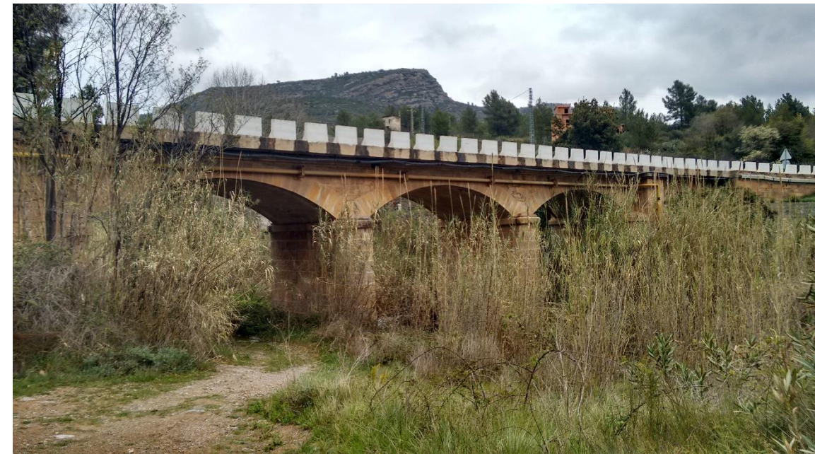
Fig. 18 Puente de acceso a Figueroles por el oeste (Fuente: Fotografía propia)
