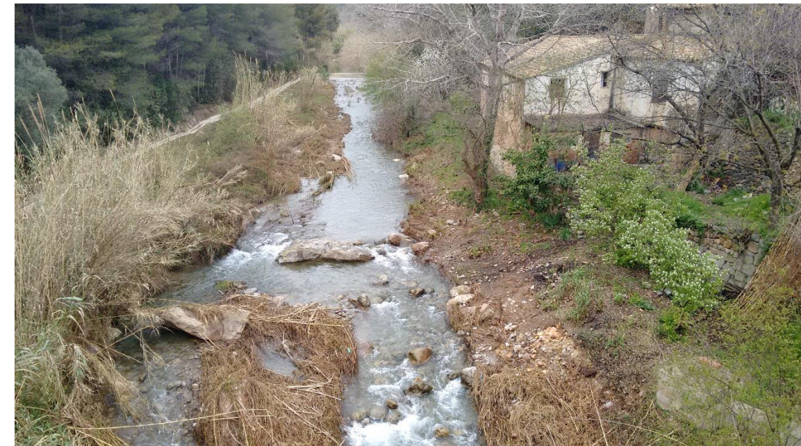
Fig. 6 Aguas arriba desde el puente existente (Fuente: Fotografía propia)
