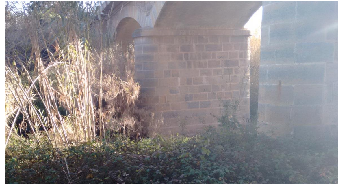
Fig. 30 Pila del puente (Fuente: Fotografía propia)
