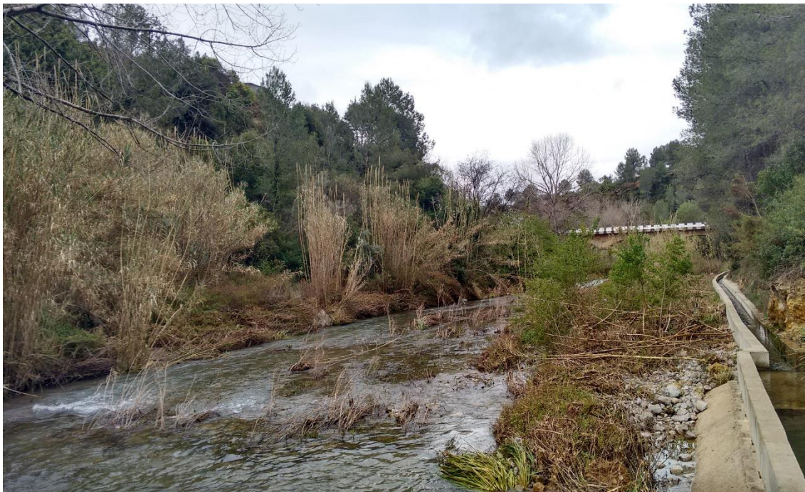
Fig. 21 Acequia de derivación (Fuente: Fotografía propia)
