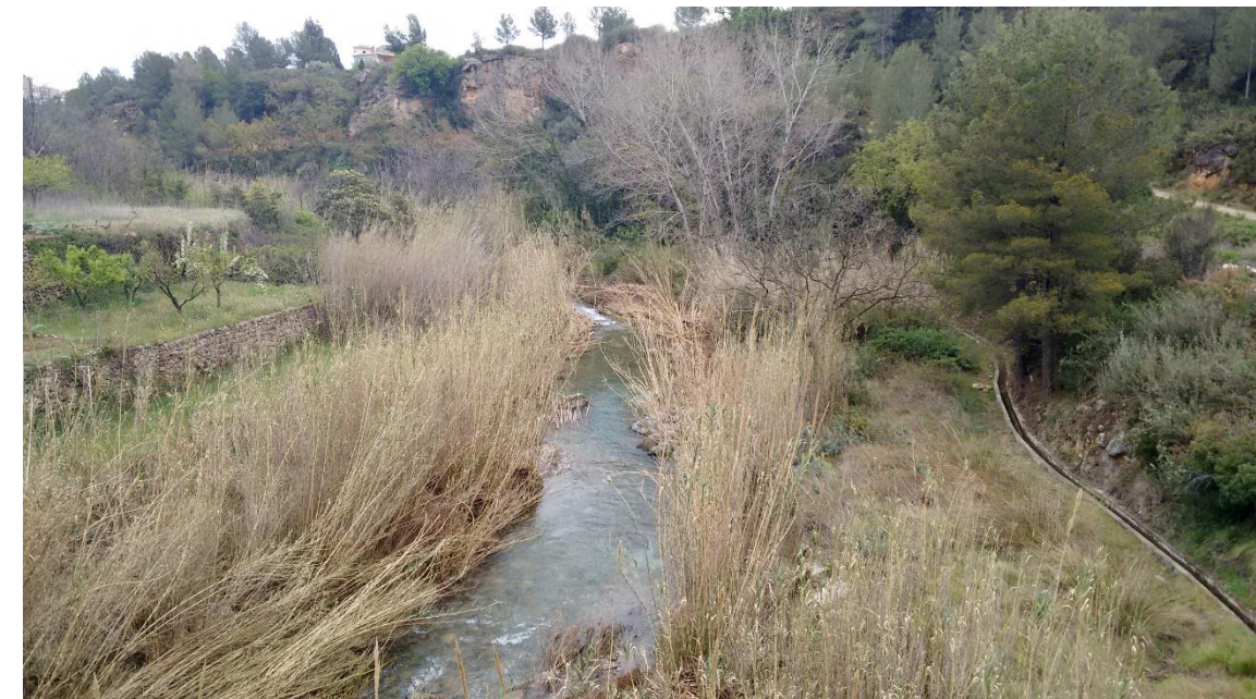
Fig. 7 Aguas abajo desde el puente existente (Fuente: Fotografía propia)
