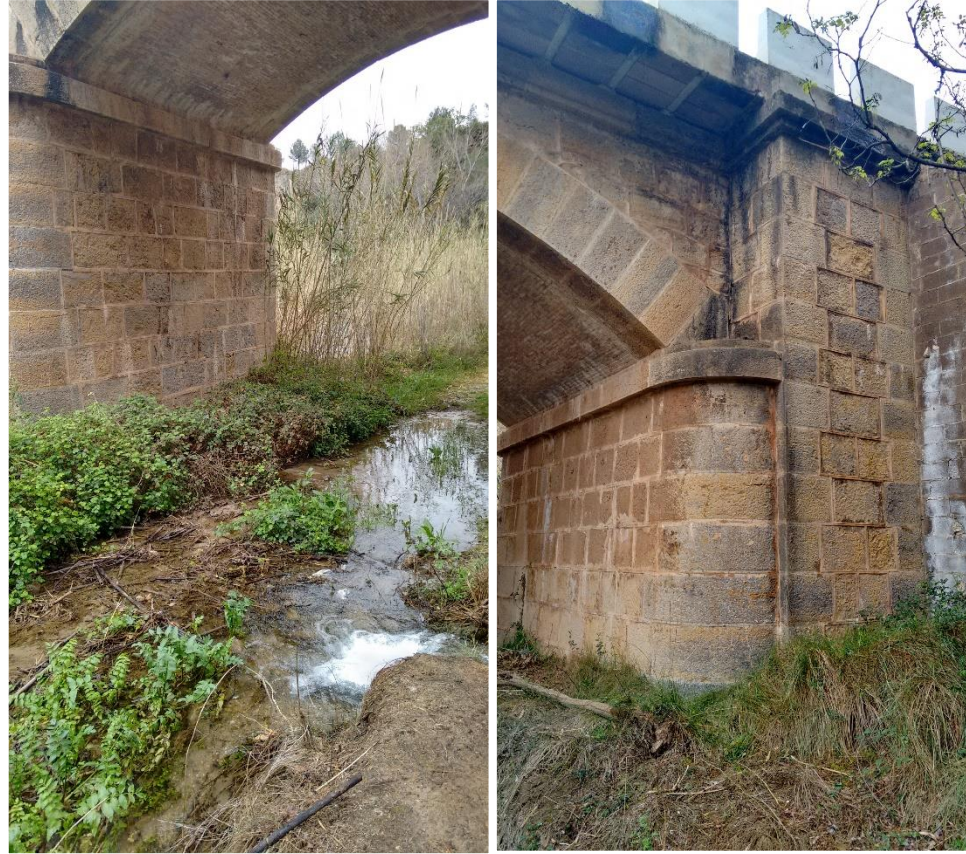
Fig. 8 Pila del puente existente (Fuente: Fotografía propia)
