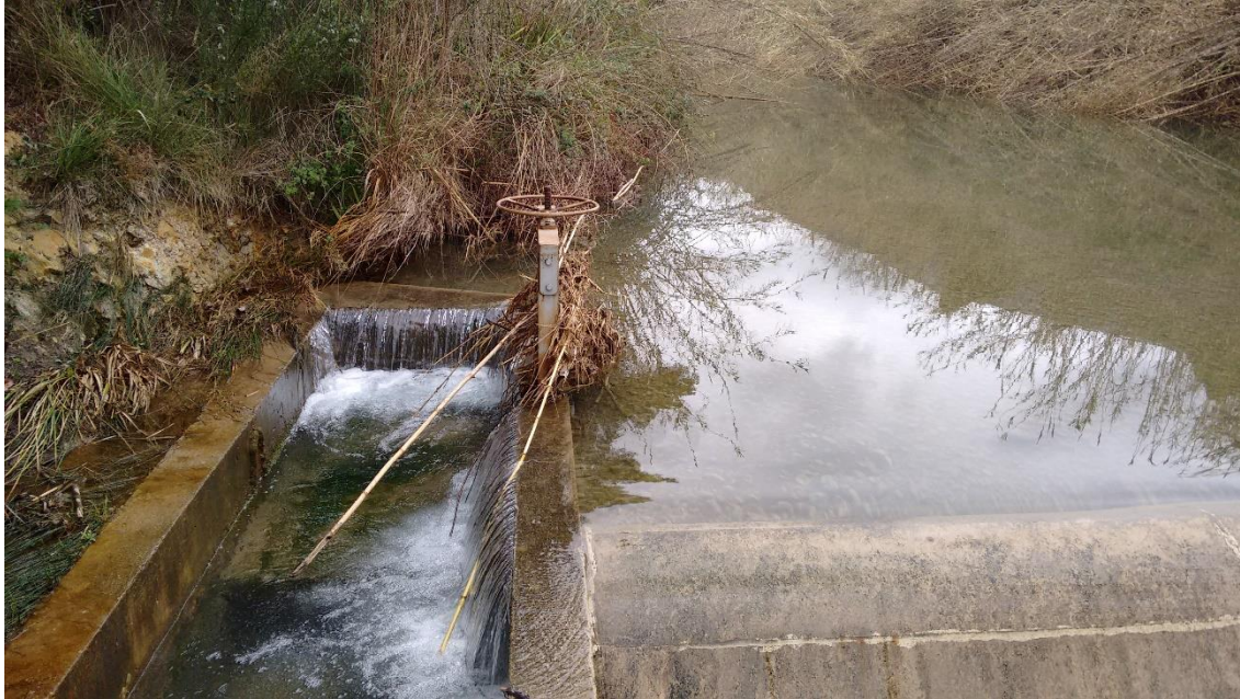
Fig. 20 Inicio de la acequia de derivación (Fuente: Fotografía propia)
