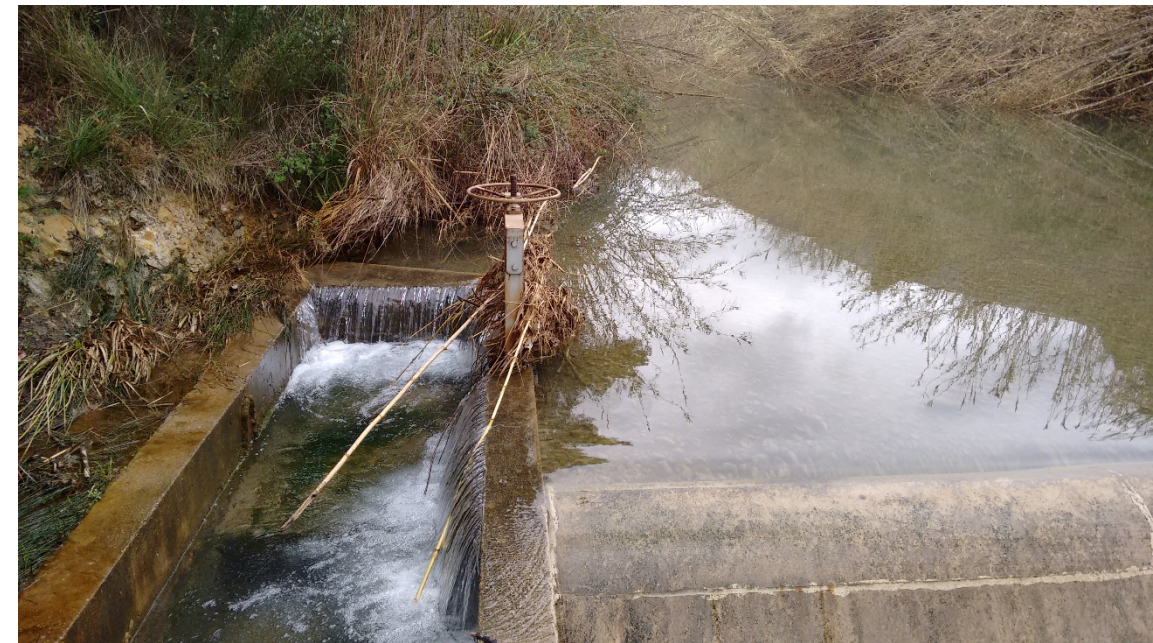
Fig. 22 Inicio de la acequia de derivación (Fuente: propia)
