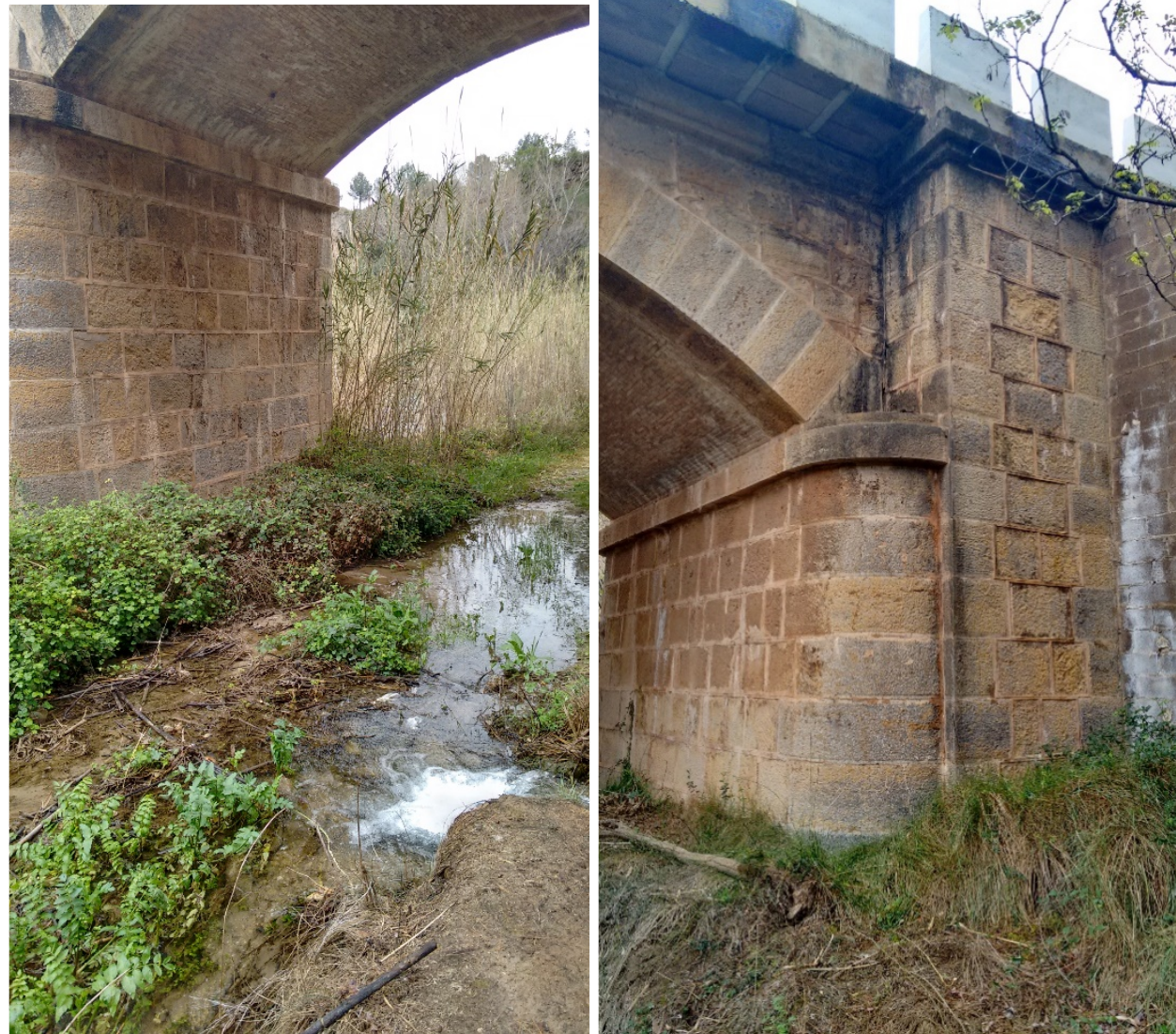
Fig. 7 Pila del puente existente (Fuente: foto propia)
