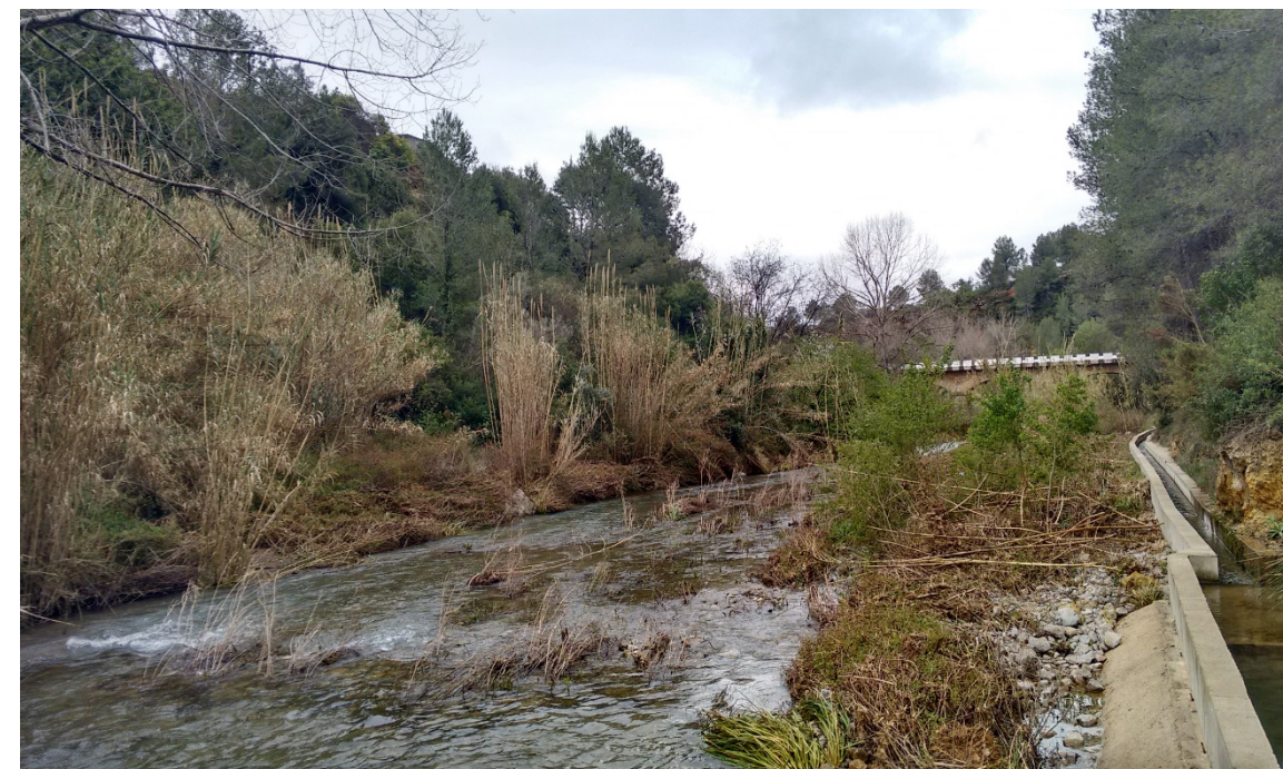
Fig. 23 Acequia de derivación (Fuente: propia)
