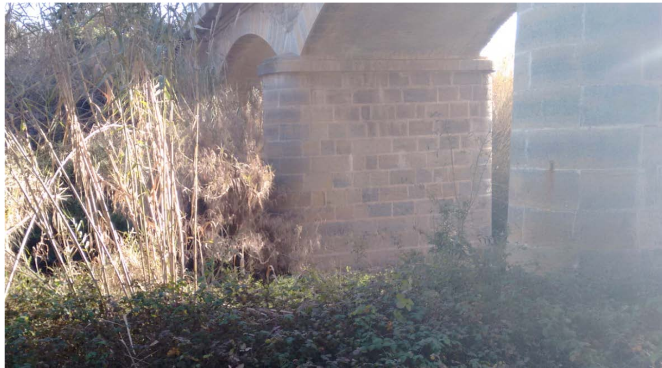
Fig. 32 Pila del puente (Fuente: propia)
