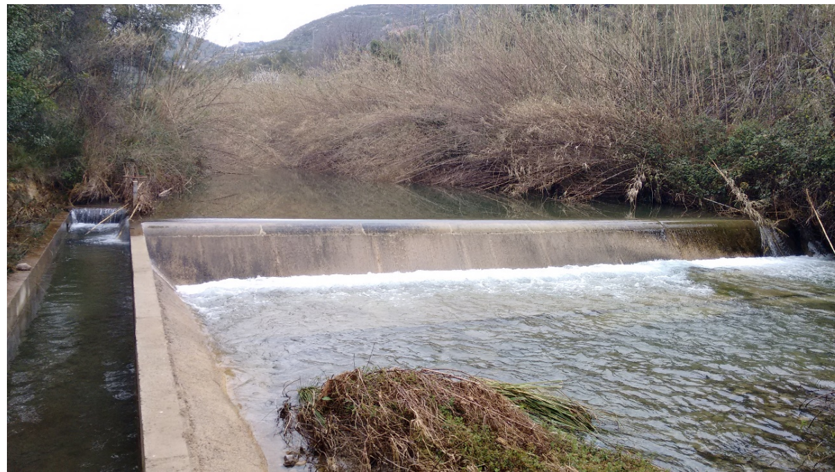
Fig. 21 Pequeño azud aguas arriba del puente de acceso a Figueroles (Fuente: propia)
