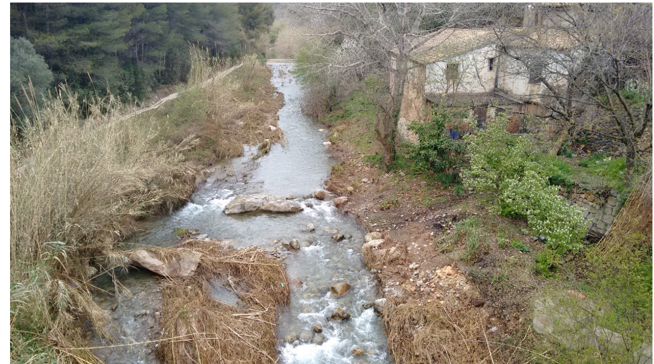
Fig. 5 Aguas arriba desde el puente existente (Fuente: foto propia)
