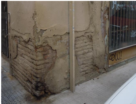
Ilustración 5. Fotografía composición de la fachada.2015.
