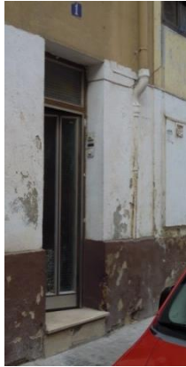
Ilustración 10. Fotografía puerta de acceso al zaguán.2015.
