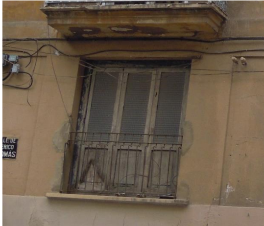
Ilustración 44. Ejemplo anclaje de barandilla en edificio de estudio. Abril 2015.
