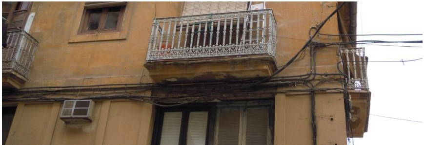
Ilustración 7. Fotografía cornisa de decoración.2015.
