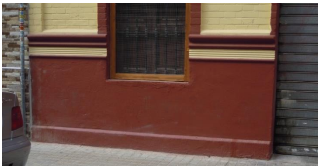
Ilustración 36. Zócalo de arranque de fachada desde cimentación en edificio de estudio. Abril 2015.
