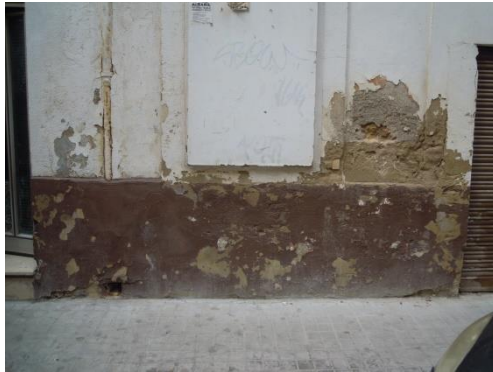
Ilustración 35. Zócalo en edificio de estudio. Abril 2015.
