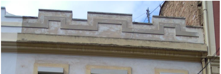
Ilustración 46. Ejemplo de cornisa en edificio de estudio. Abril 2015.
