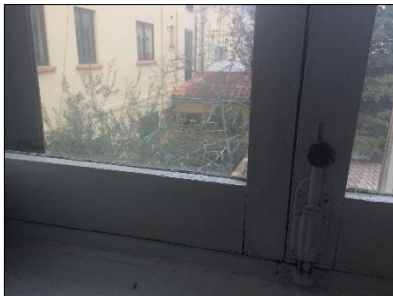
Imagen 26 Carpintería de madera (2015) Fuente propia
