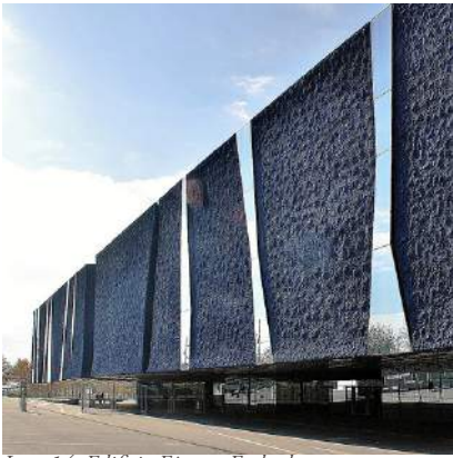
Img. 14: Edificio Fórum. Fachada norte.
