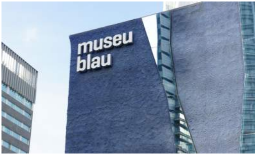
Img. 38. Detalle nuevo cartel. Esquina noroeste.
