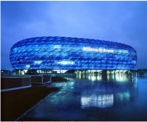
Img. 9: Allianz Arena, en Múnich, Alemania (2005)
