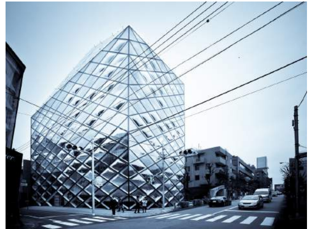
Img 6: Edificio Prada Aoyama en Tokyo, Japón (2003)
