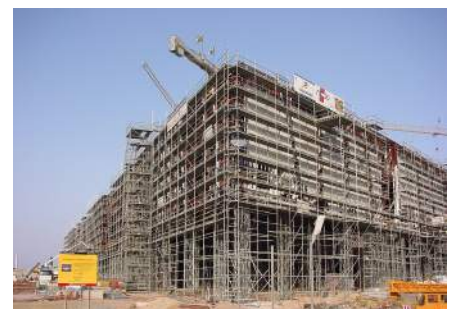
Img. 35: Proceso de construcción. Andamiaje para la construcción de fachadas.
