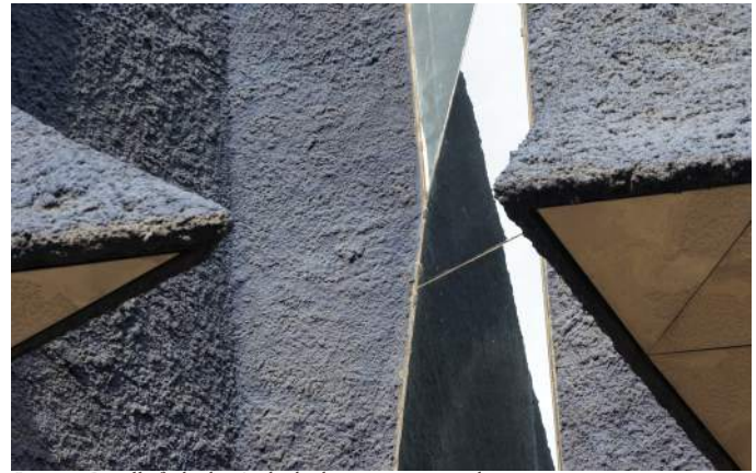
Img. 28: Detalle fachada. Acabado de cemento gunitado.
