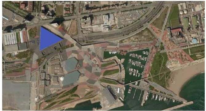
Img. 6: Imgpiano aéreo. Estado actual conjunto. Edificio Fórum.
