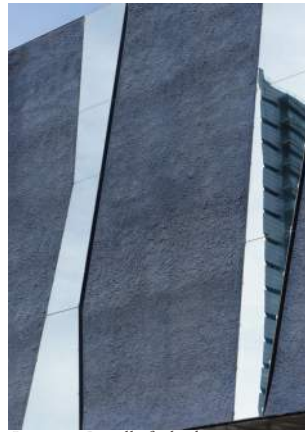
Img. 27: Detalle fachada.
