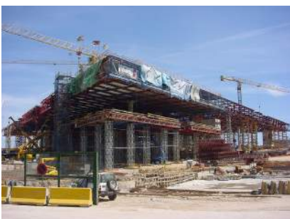
Img. 33: Proceso de construcción. Montaje emparrillado de celosías. I
