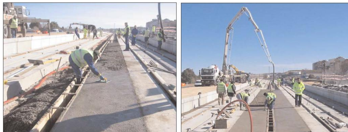
Figura 13. Fotografías del Hormigonado de canaletas de recogida de aguas.
