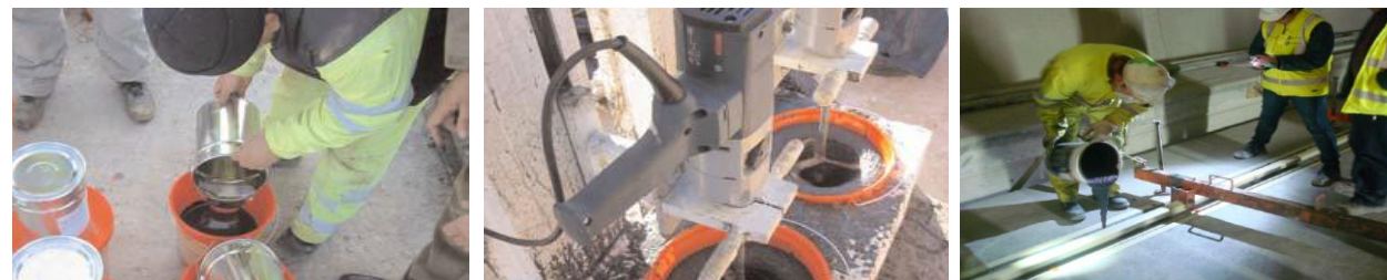
Figura 12. Fotografías del mezclado, batido y vertido del corkelast VA-60 una vez aprobada la geometría de la vía en los huecos entre la acanaladura y el carril.
