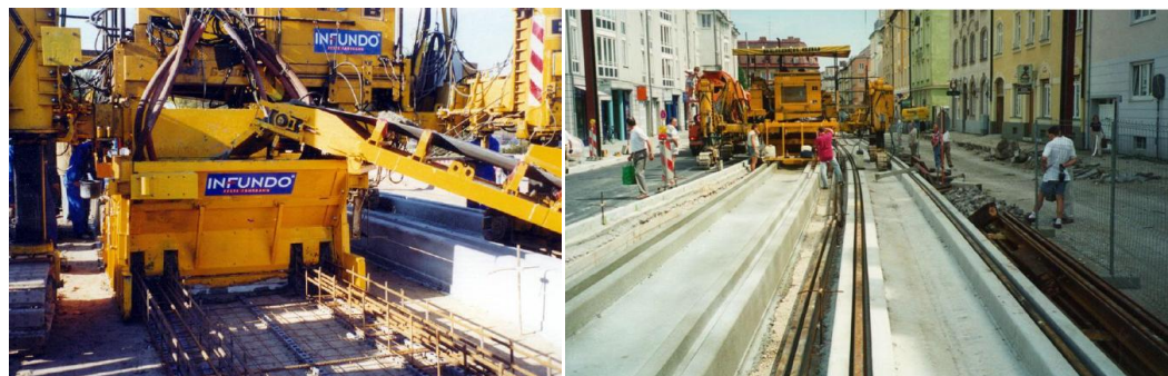
Figura 10. Hormigonado de la placa principal mediante bomba.
