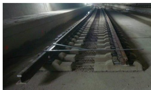
Figura 14. Fotografía de la disposición de traviesas B-355 y carril sobre la placa base.
