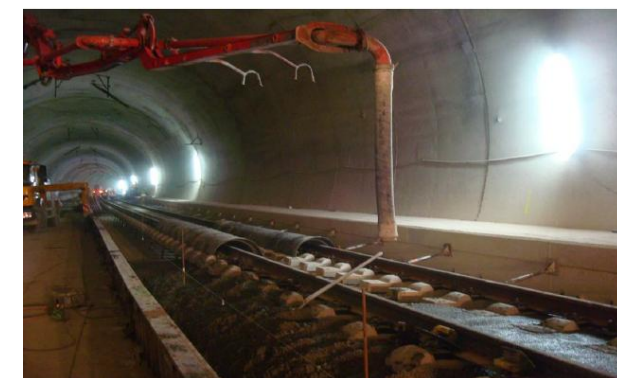
Figura 17. Fotografía del hormigonado de la vía 1 mediante bomba. Protección del carril y sujeciones.
