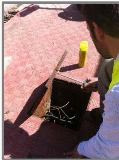
Ilustración N°22: Observación del sentido de las tuberías antes de pasar el georradar
