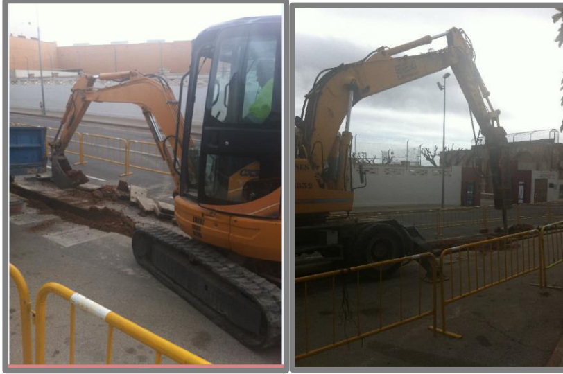
Ilustración N°55: Labores realización del hincado con retro-mixta
