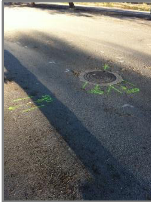
Ilustración N°23: Marcaje de los servicios; destacando la dirección que lleva, profundidad, diámetro
