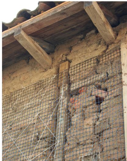
Contención de muro mixto y pilar embebido con geomalla. (Obras de Rehabilitación en Curepto a cargo de la Pontificia Universidad Católica)
