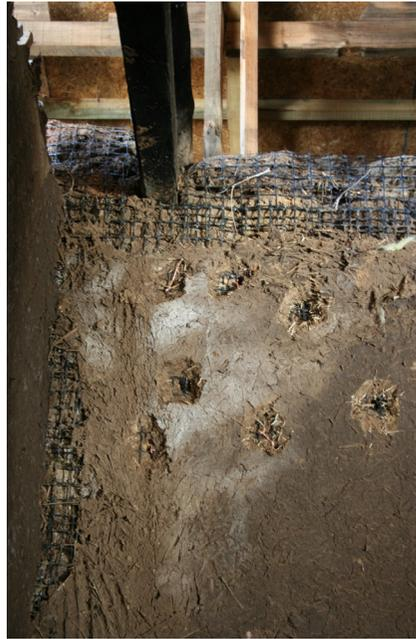
Refuerzo de muro con geomalla en corona. (Obras de Rehabilitación en Curepto a cargo de la Pontificia Universidad Católica)
