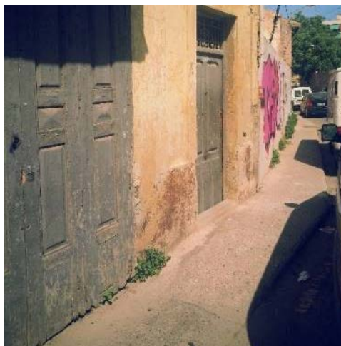
Ilustración 55. Vegetación en el arranque de fachada de C/Moncada, 11. 2015. Fuente: Guillem Aparicio.
