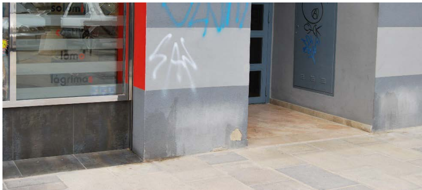
Ilustración 54. Lesión por nitratos ocasionados por animales en C/Bilbao, 17. 2015. Fuente propia.
