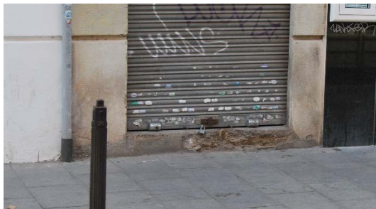
Ilustración 51. Erosión mecánica en C/Fray Pedro Vives, 6. 2015. Fuente propia.
