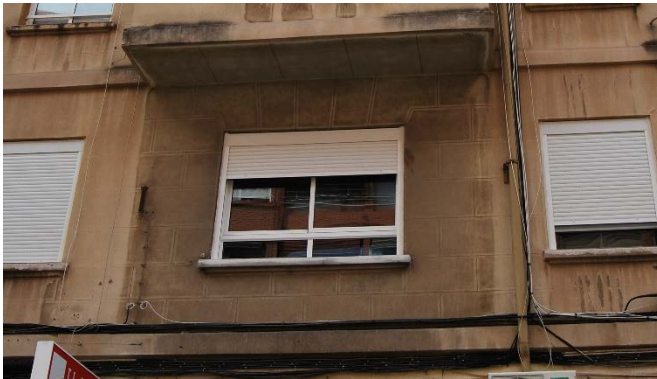
Ilustración 42. Suciedad por deposición en C/Fray Pedro Vives, 8. 2015. Fuente propia.
