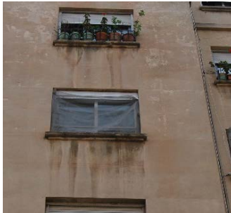
Ilustración 19. Suciedad por escorrentía. 2015. Fuente propia.
