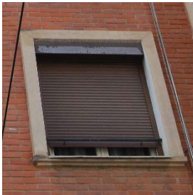
Ilustración 17. Encuentro de fachada caravista con carpintería. 2015. Fuente propia
