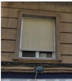
Ilustración 18. Encuentro de fachada para revestir con carpintería. 2015. Fuente propia.
