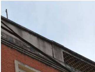
Ilustración 16. Detalle de antepecho y su coronación. 2015. Fuente propia.
