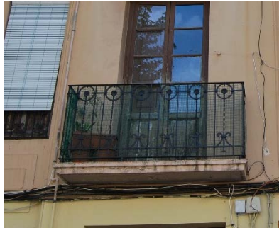
Ilustración 35. Anclaje metálico de barandilla a fachada de C/Actor Mora, 25. 2015. Fuente propia.
