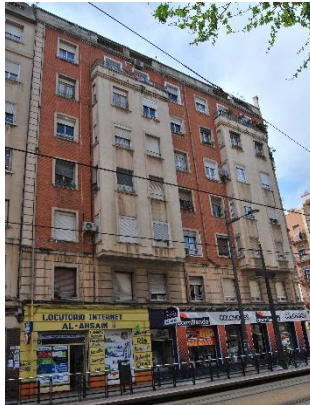
Ilustración 5. Fachada Sagunto 112 de la zona de C/Fray Pedro Vives. 2015. Fuente propia.
