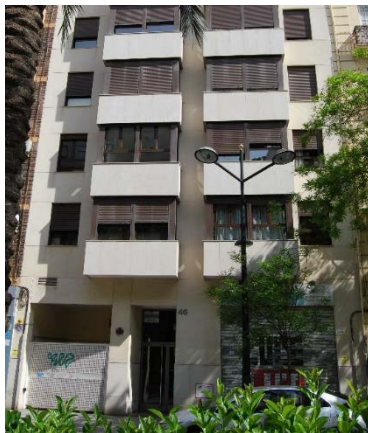
Ilustración 28. Fachada de C/Ruaya, 46 con un revestimiento de mortero monocapa. 2015. Fuente propia.
