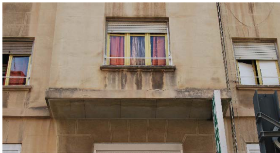
Ilustración 30. Encuentro de fachada con forjado en C/Fray Pedro Vives, 6. 2015. Fuente propia.
