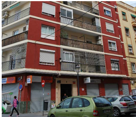
Ilustración 27. Fachada de C/Bilbao, 9 con un revestido de enfoscado acabado con pintura. 2015. Fuente propia.
