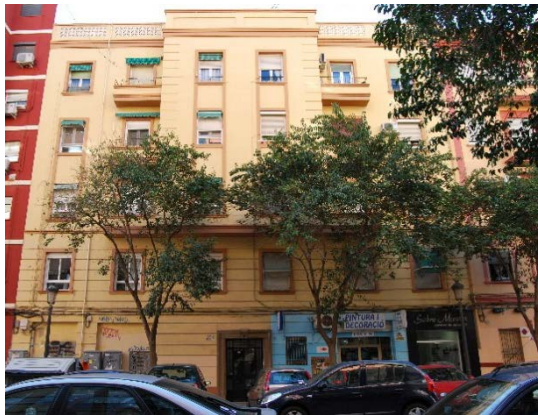
Ilustración 26. Fachada de C/Bilbao, 13 con acabado de revoco liso y almohadillado. 2015. Fuente propia.
