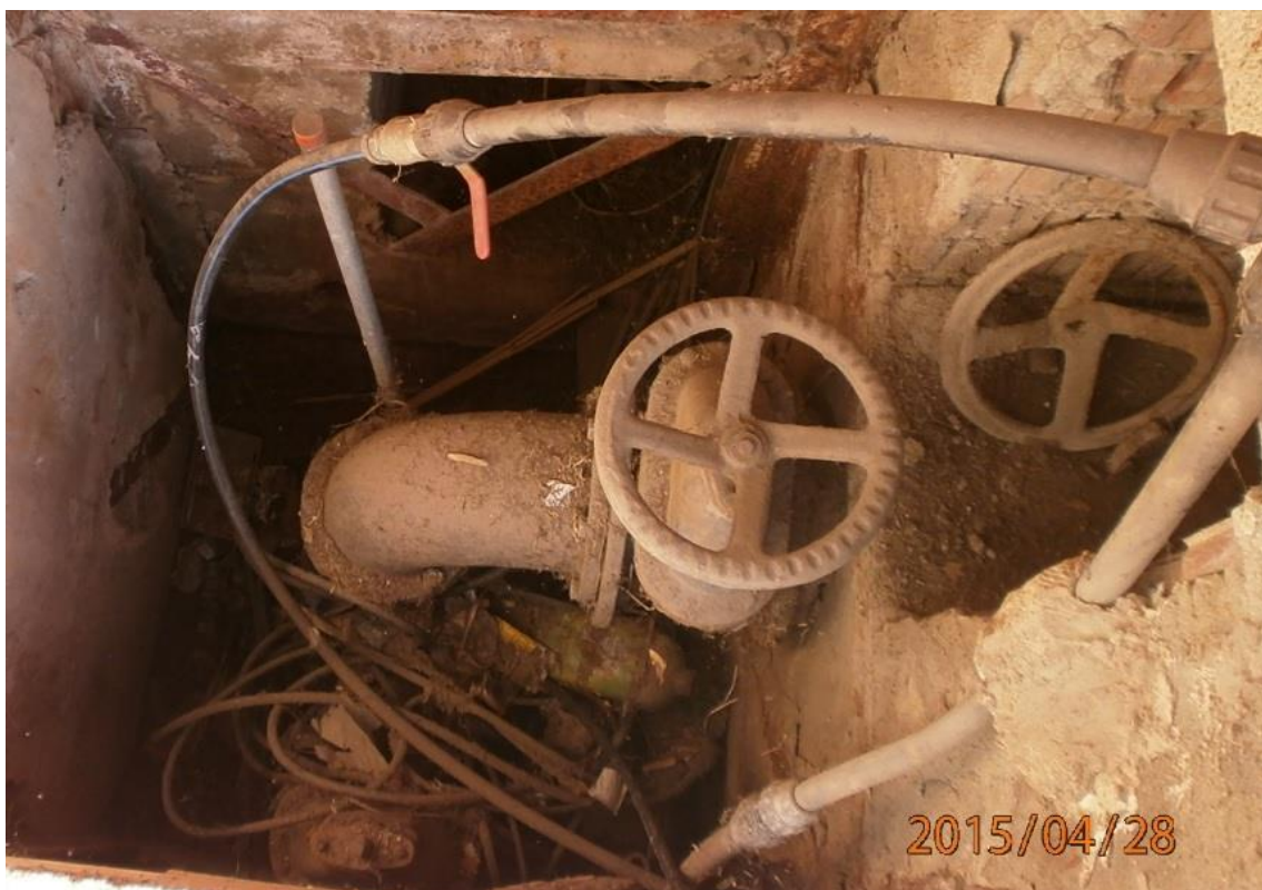
Fotografía 1. Pozo con fecha de instalación desconocida
