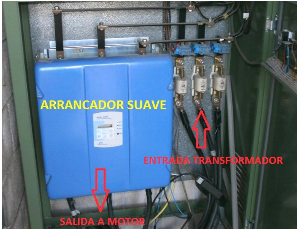
Fotografía 7. Posición de los conductores para medir tensión entre las líneas U-V. C.G.D. 2
