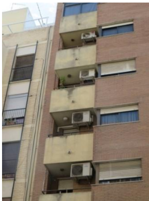
Ilustración 53. Ensuciamiento por deposición.
