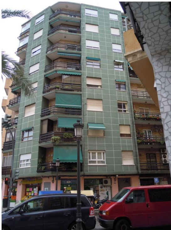
Ilustración 35. Fotografía fachada revestida con mortero monocapa.
