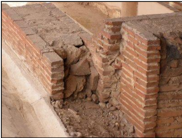
Ilustración 27. Fachada portante. Abril 2015.
