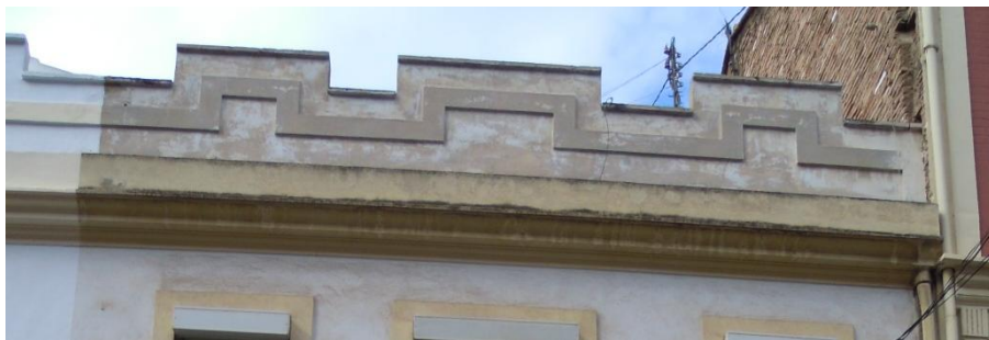
Ilustración 46. Ejemplo de cornisa en edificio de estudio. Abril 2015.
