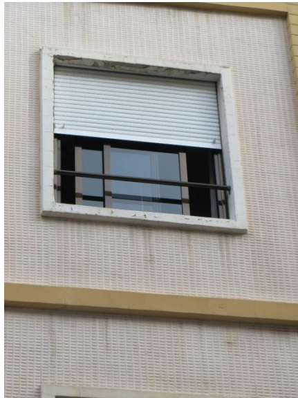
Ilustración 55. Suciedad por lavado diferencial.
