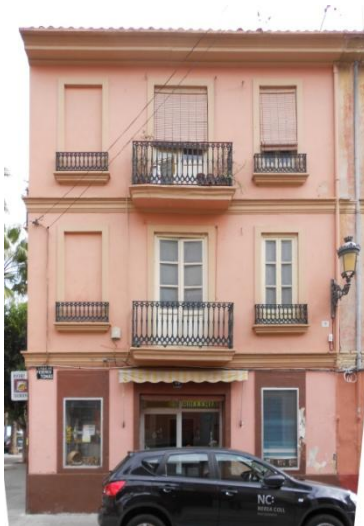
Ilustración 40. Voladizo en edificio de estudio. Abril 2015.
