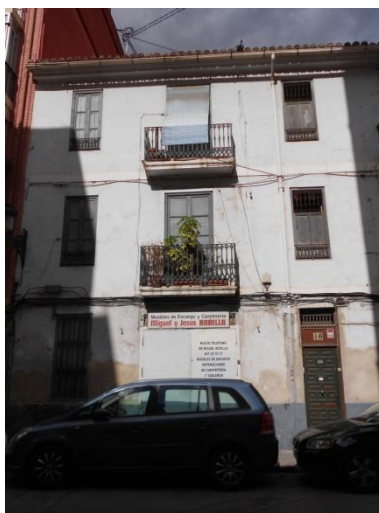
Ilustración 33. Fotografía fachada con revoco de edificio objeto de estudio.
