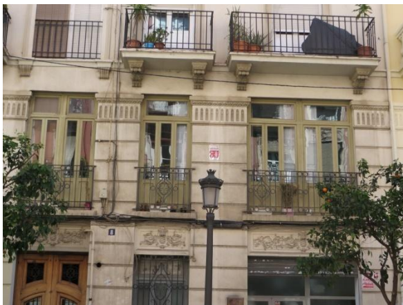
Ilustración 44. Ejemplo anclaje de barandilla en edificio de estudio. Abril 2015.
