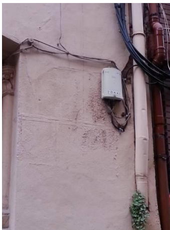
Ilustración 69. Lesión por nitratos, ocasionada por animales.
