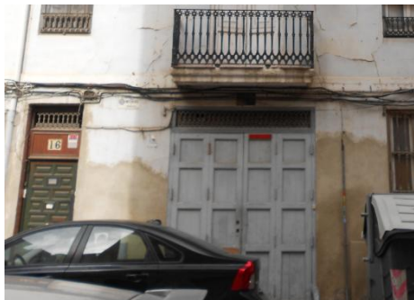
Ilustración 15. Fotografía carpintería de madera y cerrajería de forja.2015.
