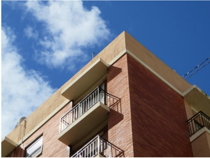
Ilustración 48. Ejemplo de antepecho en cubierta plana en edificio de estudio. Abril 2015.
