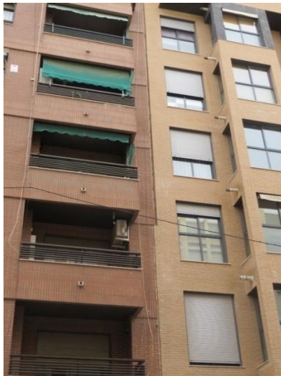
Ilustración 39. Junta de dilatación entre 2 edificios objeto de estudio. Abril 2015.
