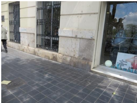
Ilustración 68. Lesión por nitratos, ocasionada por animales.
