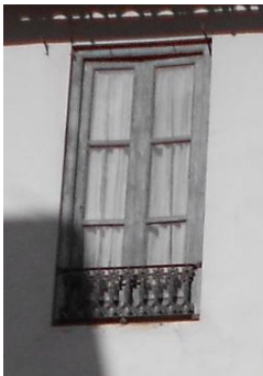
Ilustración 14. Fotografía carpintería de madera y cerrajería de forja.2015.
