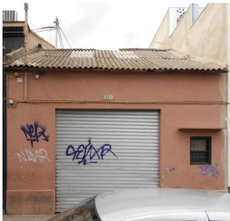
Ilustración 34. Fotografía fachada revestida de enfoscado en edificio objeto de estudio.
