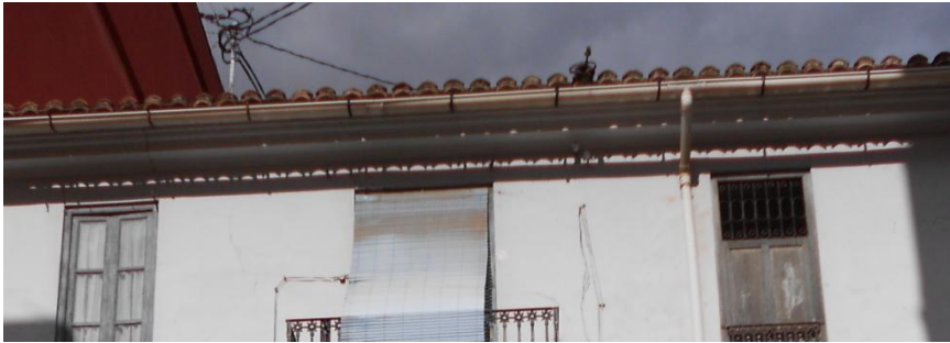
Ilustración 11. Fotografía cubierta inclinada.2015.
