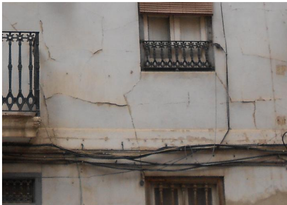
Ilustración 22.Grietas y fisuras.2015.
