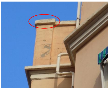
Ilustración 63. Erosión mecánica causada por la acción del viento.
