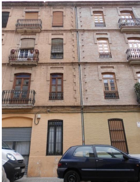
Ilustración 28. Ejemplo fachada portante de edificio de estudio. Marzo 2015.
