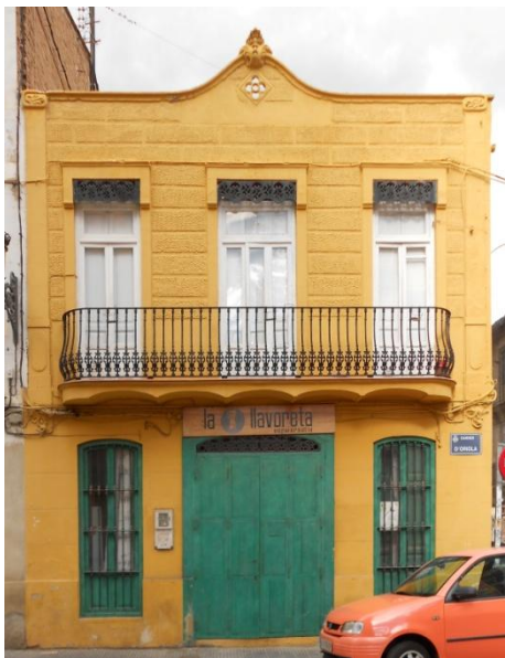
Ilustración 42. Balcón con barandilla perimetral en edificio de estudio. Abril 2015.
