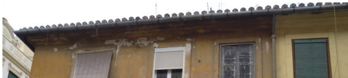
Ilustración 45. Ejemplo de cornisa con canalón en edificio de estudio. Abril 2015.
