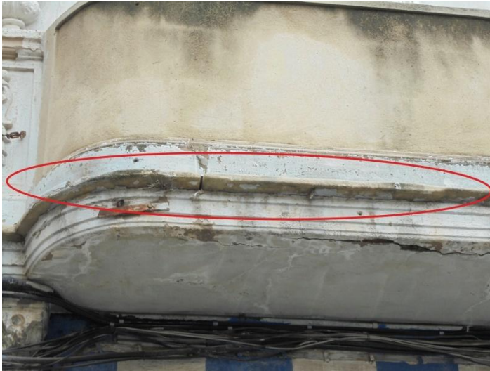
Ilustración 56. Erosión atmosférica.
