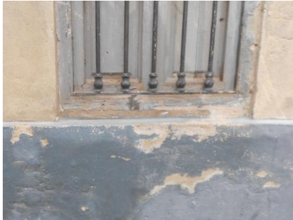
Ilustración 27. Humectación de la carpintería 2015. Fuente: Elaboración propia
