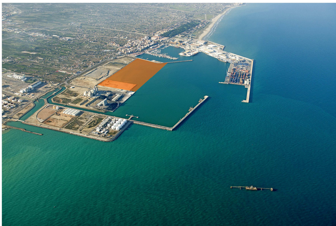
Figura 3: Foto aérea de la Dársena Sur con la ubicación de la nueva terminal de contenedores
