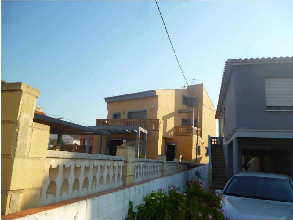
Figura 31. Fachada edificio detectado donde se observan tres plantas y un pilar. Fuente propia.
