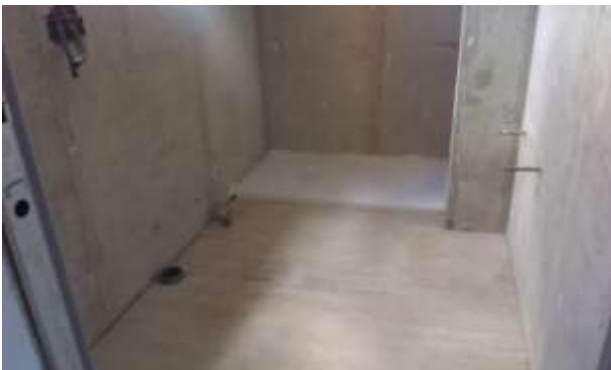
FOTO.70-Pavimento realizado con mármol travertino y colocación de plato de ducha en Baño P.1.
