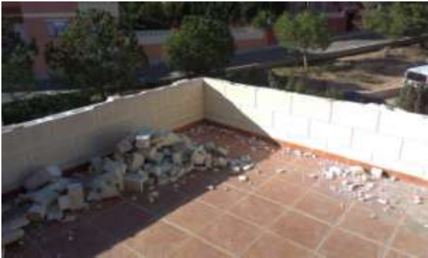
FOTO.19-Demolición resto antepecho cubierta P.2.
