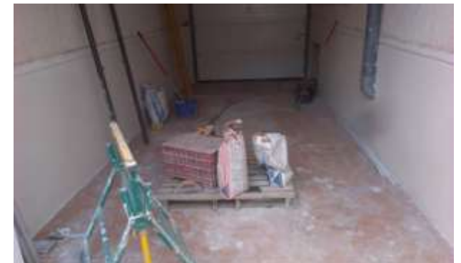
FOTO.90- Revestimiento vertical con mortero impermeabilizante con mallatex en aparcamiento.
