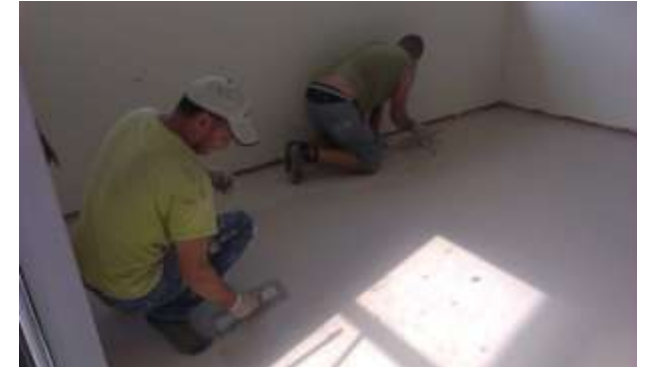
FOTO.111-Revestimiento horizontal con microcemento en el suelo del comedor.
