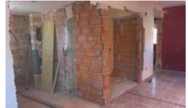
FOTO.27-Tabique de separación estancias P.1 y dintel en hueco acceso a estudio.
