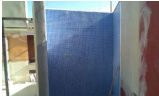
FOTO.107-Revestimiento vertical con gresite en ducha exterior.
