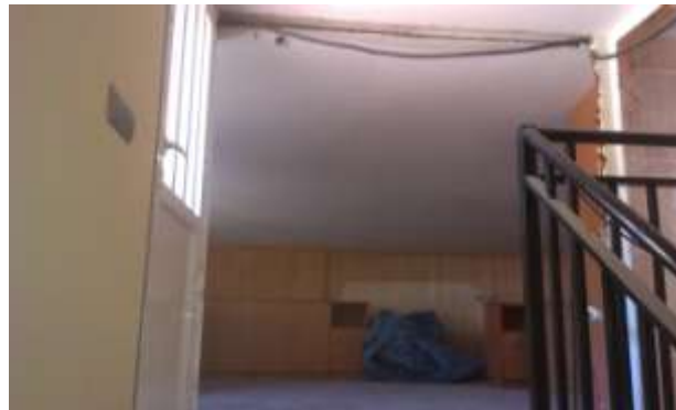
FOTO.26-Apertura de hueco en estancia P.2.
