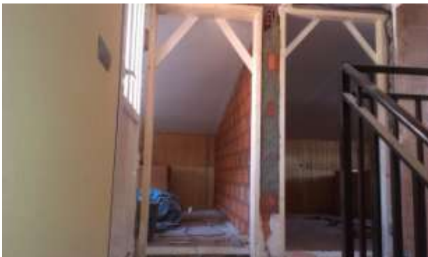
FOTO.40-Tabique de separación dormitorios P.2.
