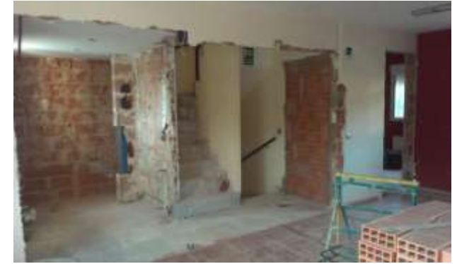
FOTO.9-Ejecución de cerramiento gimnasio.
