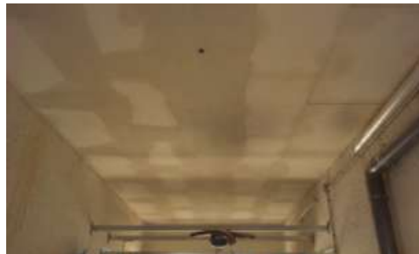
FOTO.71 Revestimiento horizontal con placas de escayola en aparcamiento.
