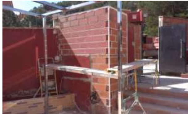
FOTO.92- Colocación de cantoneras prefabricadas en ducha exterior.
