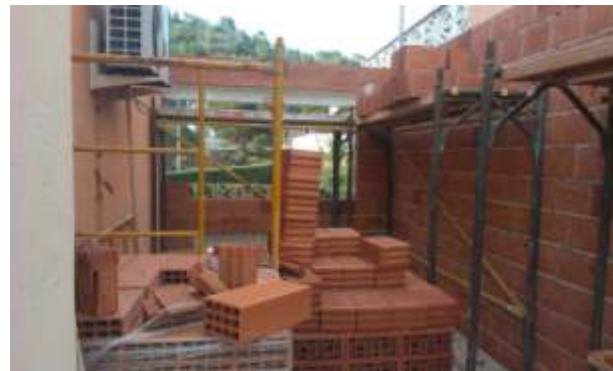
FOTO.11-Ejecución de cerramiento gimnasio.
