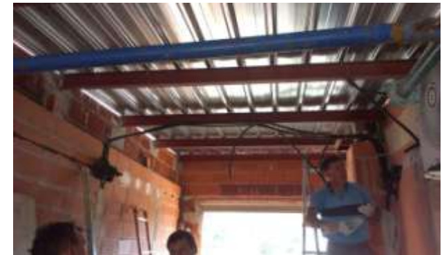
FOTO.51-Colocación de tubos y cajas de derivación en gimnasio.
