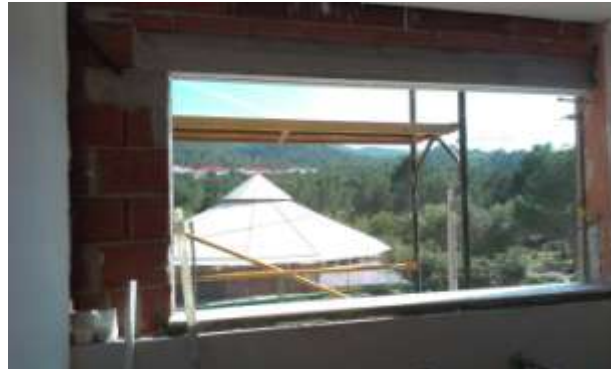
FOTO.86- Colocación de vierteaguas en gimnasio.
