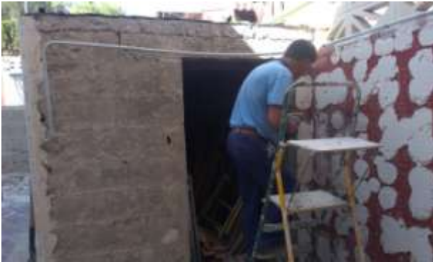
FOTO.67-Levantados en paredes del cuarto de instalaciones piscina.
