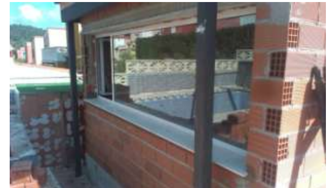
FOTO.57-Colocación de vierteaguas de piedra artificial en ventana del comedor.
