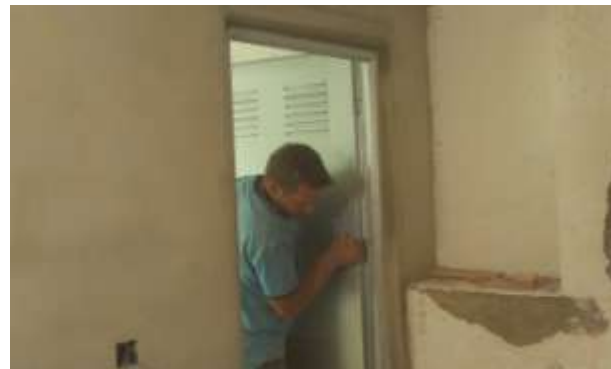
FOTO.101- Colocación de puerta en cuarto de instalaciones de P.Sótano.
