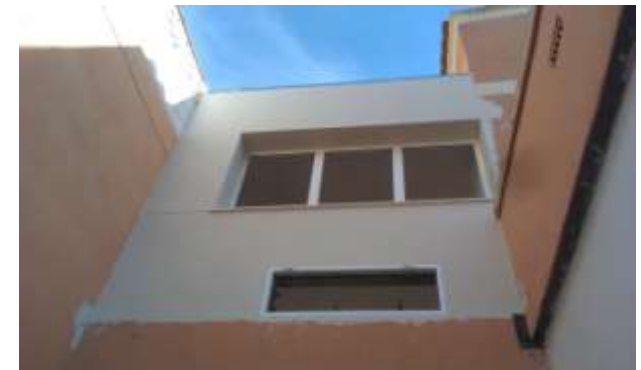
FOTO.72-Revestimientos exteriores con mortero impermeable en fachada comedor y gimnasio.
