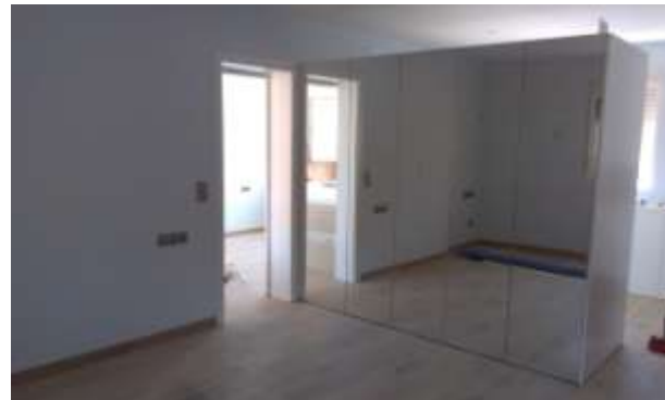
FOTO.128- Frentes de armario en vestidor del dormitorio principal.
