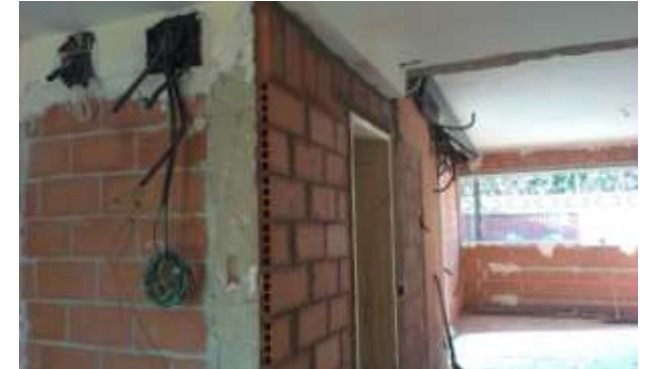
FOTO.39-Recrecido de desnivel entre paredes comedor e instalaciones comedor.
