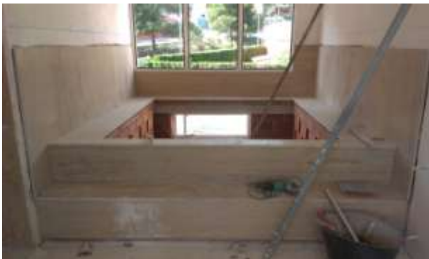
FOTO.88- Revestimiento con mármol travertino en encajonado jacuzzi.
