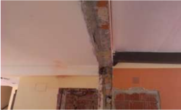
FOTO.25-Demolición cerramiento comedor
