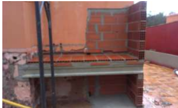
FOTO.44-Realización de bancada de paellero.
