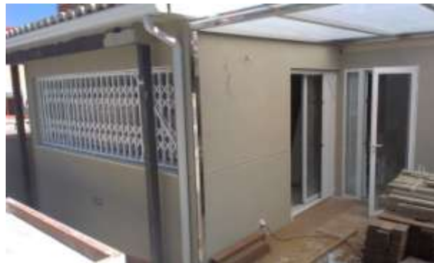
FOTO.125- Colocación de cerrajerías plegables.
