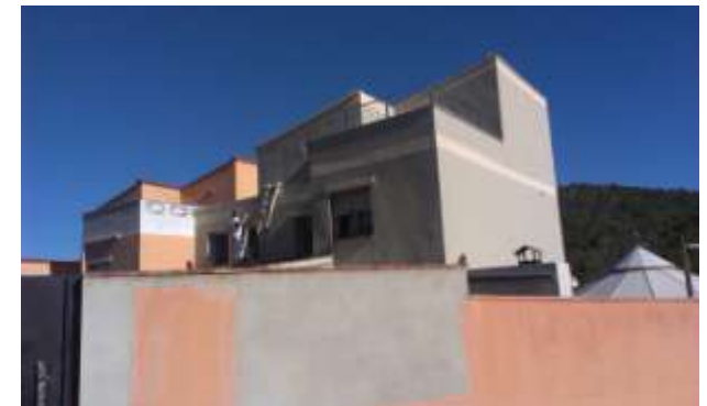
FOTO.108-Revestimientos con pinturas en fachadas Norte y Oeste.
