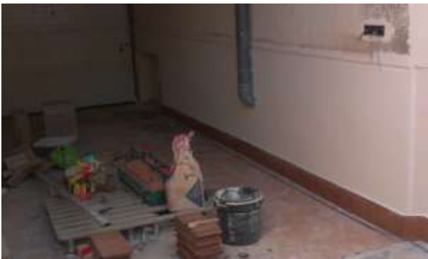
FOTO.100- Realización del rodapié en aparcamiento.
