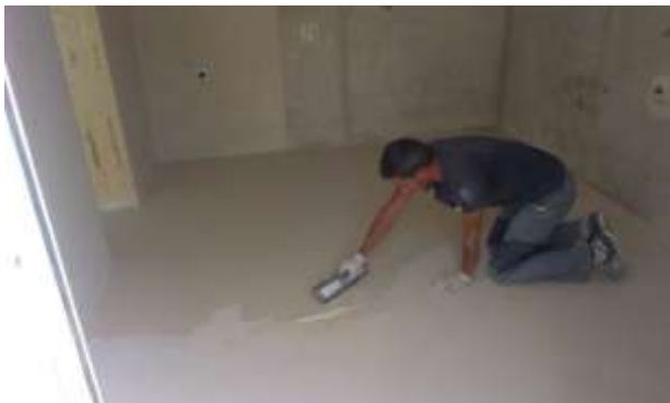
FOTO.112- Revestimiento horizontal con microcemento en el suelo de la cocina.
