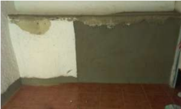
FOTO.115- Picado y enfocado de paredes en cuartos de instalaciones en P.Sótano.
