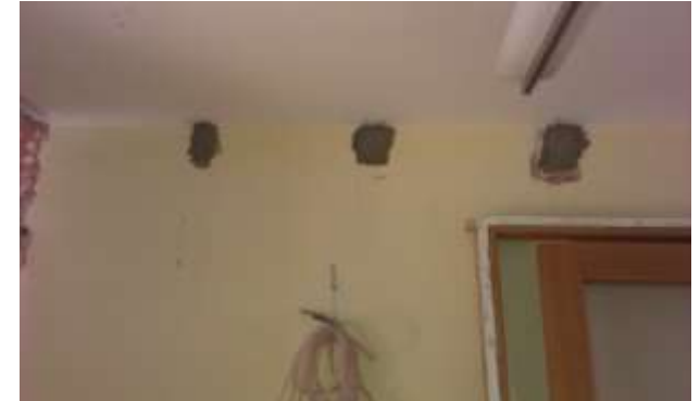
FOTO.21-Sellado con mortero perforaciones.
