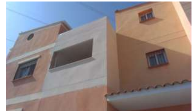
FOTO.96- Revestimiento vertical con mortero impermeabilizante con mallatex en fachada Sur del gimnasio.
