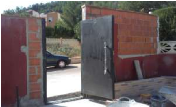
FOTO.91- Demolición de celosía y realización de nuevo muro con la colocación de puerta metálica de acceso.
