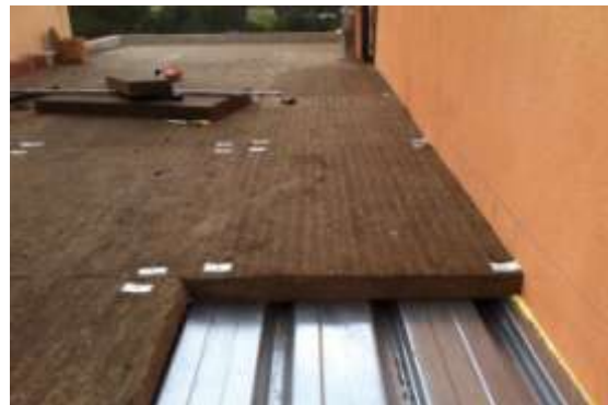
FOTO.59-Colocación de lana de roca en cubierta del gimnasio.
