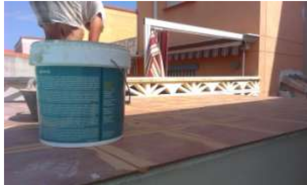
FOTO.110-Cobertura del cuarto de instalaciones piscina con baldosas cerámicas.
