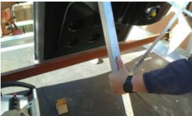
FOTO.76- Colocación de colector colar con ayuda de camión grúa en cubierta gimnasio.
