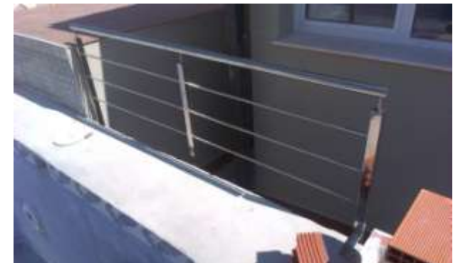
FOTO.120- Colocación de barandilla de separación entre piscina y distribuidor.
