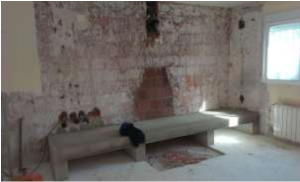
FOTO.49-Solado de microcemento, bancada chimenea y picado recuadro microcemento en comedor.
