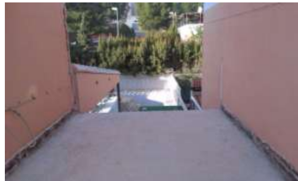
FOTO.5- Demolición cubierta y antepecho P.B.
