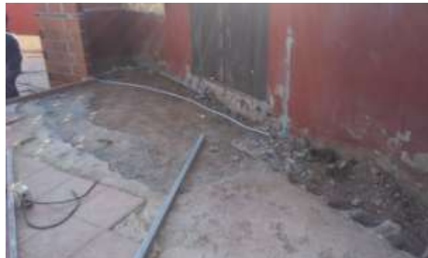
FOTO.38-Picado de pavimento ducha exterior.
