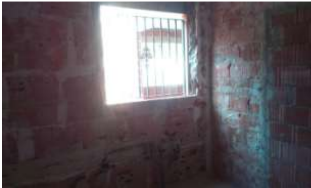
FOTO.7-Levantado carpintería y cierre de hueco
