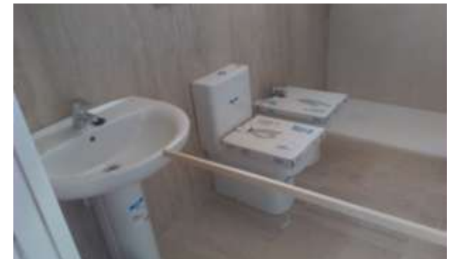
FOTO.126- Instalación de sanitarios en Baño P.1.
