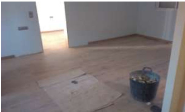
FOTO.106-Revestimiento horizontal con parquet y rodapié.
