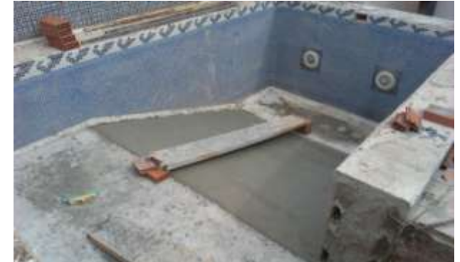
FOTO.81- Modificación de niveles en piscina con mortero con fibras.
