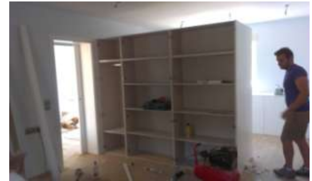
FOTO.123- Realización de vestidor en dormitorio principal.
