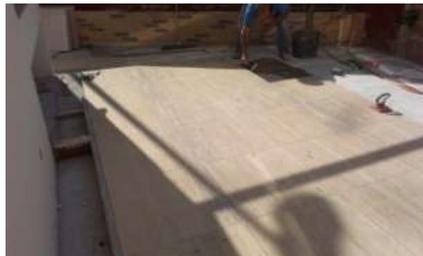
FOTO.89 Revestimiento horizontal con mármol travertino en terraza exterior.
