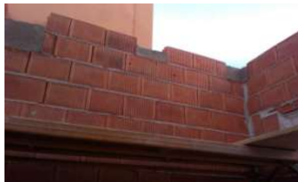
FOTO.23-Apoyos de correas de cubierta.
