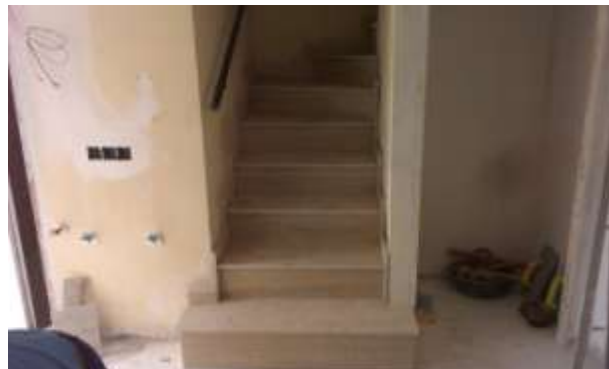
FOTO.83 Revestimiento horizontal con mármol travertino en escalera de P.B y rellano P.1.
