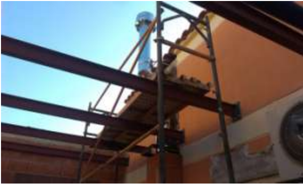
FOTO.37-Demolición chimenea y realización de la nueva de acero inoxidable.
