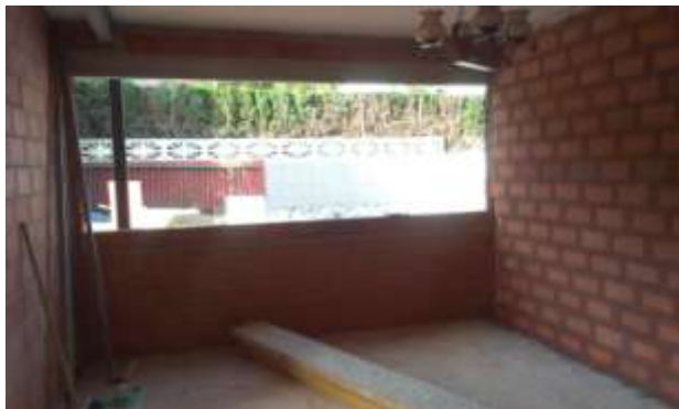
FOTO.10-Ejecución de cerramiento comedor.
