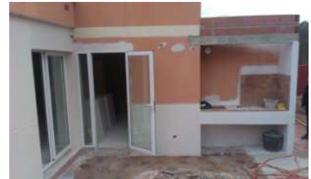
FOTO.66-Revestimientos exteriores con mortero impermeable en fachada comedor y paellero.
