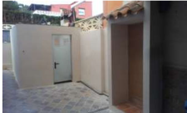
FOTO.74- Realización de leñero. Revestimiento de paredes y colocación de puerta en cuarto de instalaciones piscina.
