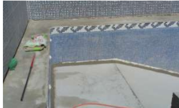
FOTO.98- Rejuntado curvo y coronación piscina con mortero de cemento.
