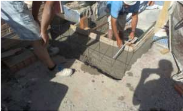
FOTO.85- Levantado de pavimento y colocación del nuevo en aparcamiento. También colocación de canaleta de recogida.
