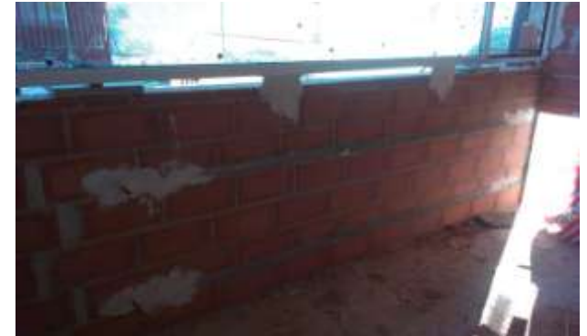
FOTO.33-Instalaciones calefacción en ampliación del comedor y colocación ventana comedor.
