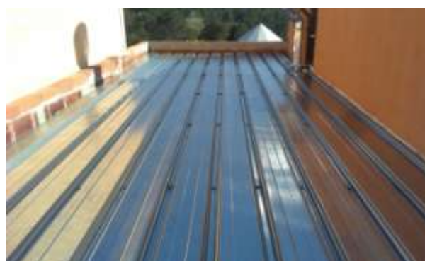
FOTO.53-Colocación chapa grecada en cubierta del gimnasio.
