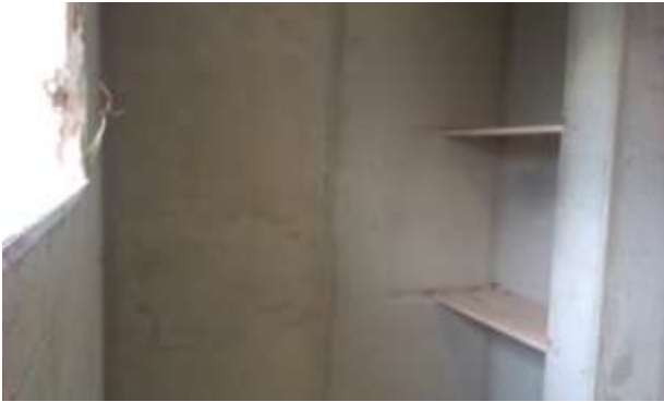
FOTO.61-Realización de baldas en Baño P.1.
