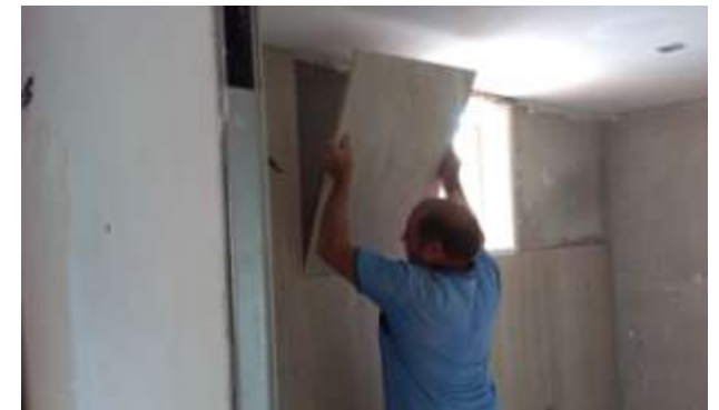
FOTO.84- Revestimiento vertical con mármol travertino en pared del Baño P.1.
