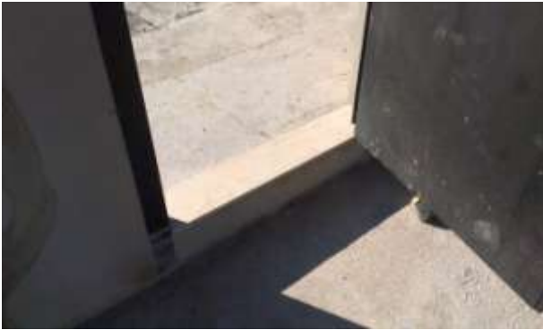
FOTO.103-Colocación de vierteaguas en muro de cerca.
