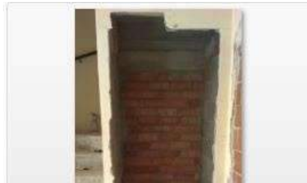
FOTO.17-Refuerzo con ladrillo perforado escalera.
