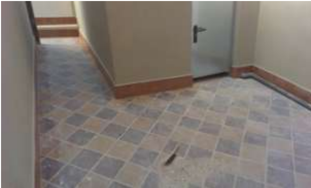
FOTO.109-Colocación rodapié pendiente en cuarto de instalaciones piscina.
