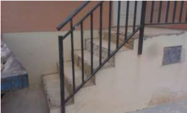
FOTO.73- Levantados de pavimento en escalera de entrada a vivienda.
