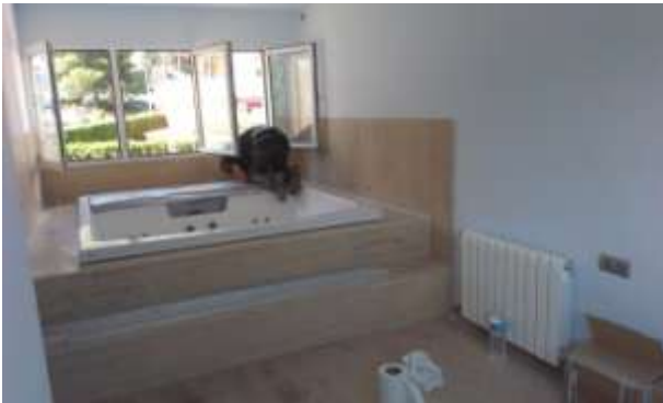
FOTO.127- Instalación del jacuzzi en el gimnasio
