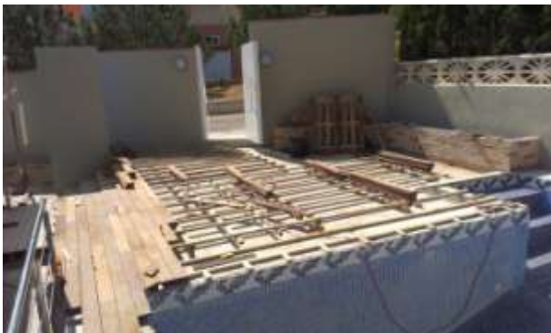
FOTO.130- Instalación de luminarias. Revestimientos con pintura en muro de cerca y puerta. Tarima flotante de Ipé terraza exterior.
