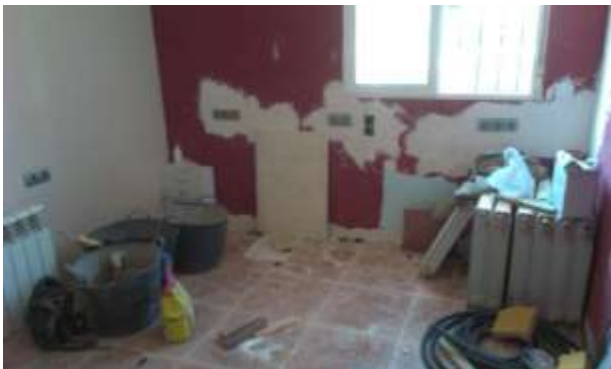
FOTO.94- Colocación de mecanismos eléctricos en estudio.
