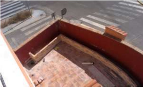
FOTO.97- Picado y colocación de sumidero en terraza exterior.
