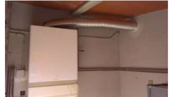
FOTO.93- Realización de nueva extracción de campana cocina a través del cuarto de calderas.
