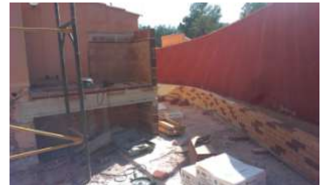
FOTO.54-Aplacado decorativo en jardinera exterior y ladrillo refractario en bancada y paredes paellero exterior.
