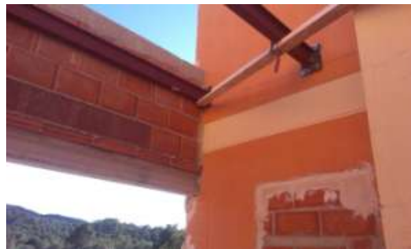
FOTO.29-Perfiles IPN-110 soldados a placas de anclaje atornilladas a termoarcilla.
