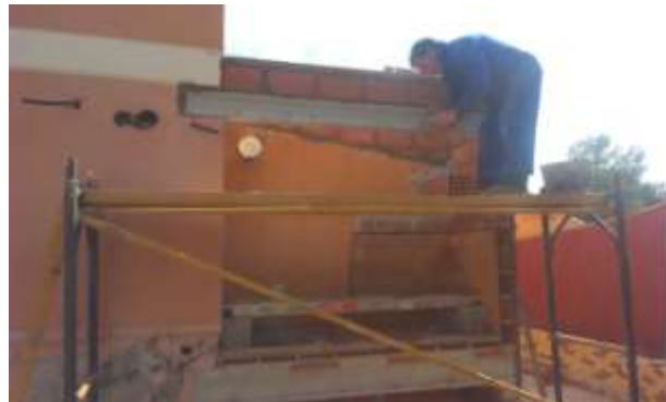
FOTO.56-Ejecución de dintel y realización de coronación en paellero.
