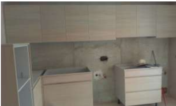
FOTO.118- Montaje de muebles bajos y altos en cocina.
