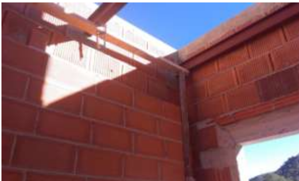
FOTO.28-Hoja interior cerramiento y perfiles embebidos en termoarcilla en gimnasio.
