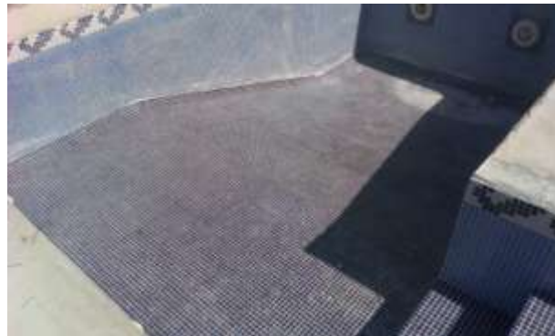
FOTO.119- Revestimiento con gresite del suelo de la piscina.
