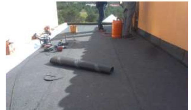
FOTO.60-Lámina impermeable autoprotegida en cubierta del gimnasio.
