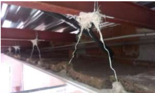
FOTO.64-Aislamiento con lana de roca sobre placas de escayola en techo del gimnasio.
