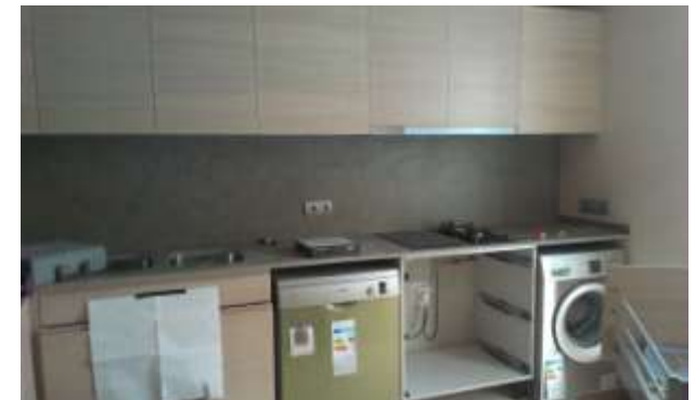
FOTO.132- Instalación de electrodomésticos, colocación de encimera, mecanismos y luminarias en cocina.
