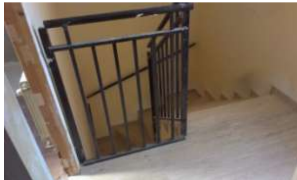
FOTO.77 Revestimiento horizontal con mármol travertino en escalera de P.1 y rellano P.2.
