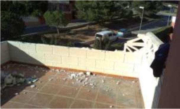
FOTO.13-Demolición antepecho de cubierta P.2.
