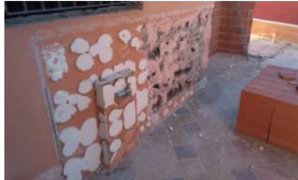
FOTO.14-Levantado de chapado fachada cocina.
