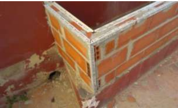
FOTO.16-Colocación de cantoneras jardinera.
