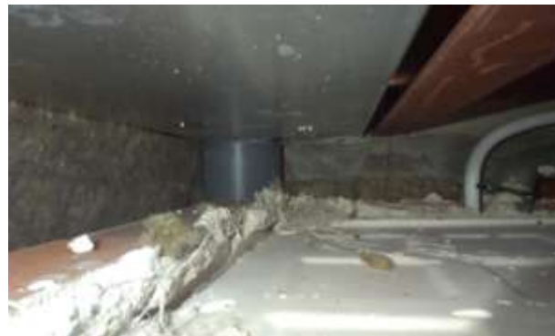
FOTO.65-Conexión de bajante de PVC en canalón oculto cubierta gimnasio.
