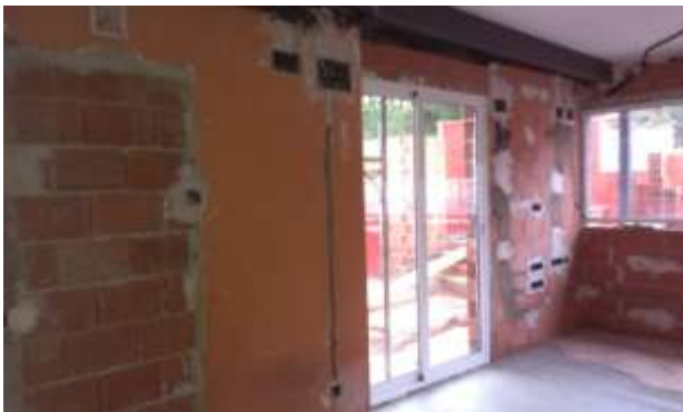
FOTO.46-Tapado de instalaciones con mortero.
