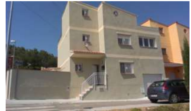
FOTO.129- Revestimientos con pintura en fachada Sur, barandilla escalera de entrada, cerrajerías y muro de cerca.
