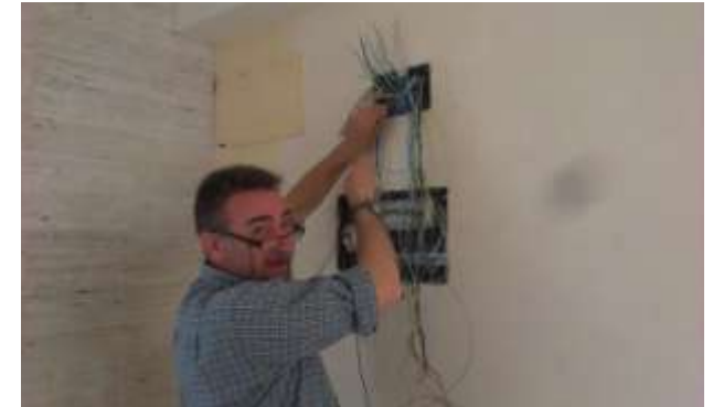
FOTO.87- Instalación de cables eléctricos en estancias vivienda.
