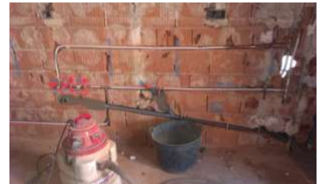
FOTO.30-Modificaciones instalaciones en cocina.
