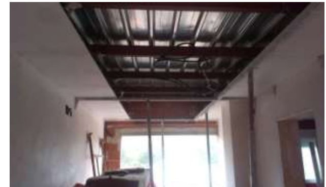
FOTO.63-Revestimiento horizontal con placas de escayola en gimnasio.
