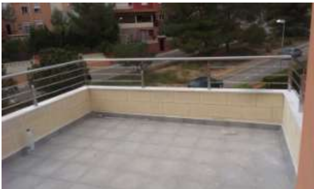
FOTO.82- Colocación de barandilla en terraza P.2.
