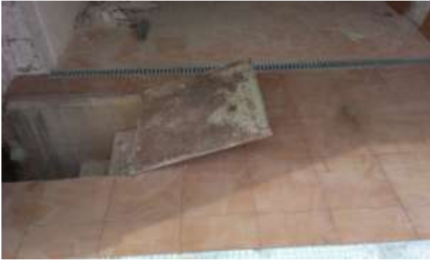
FOTO.79- Levantado de pavimento y colocación del nuevo en aparcamiento. También colocación de canaleta de recogida.
