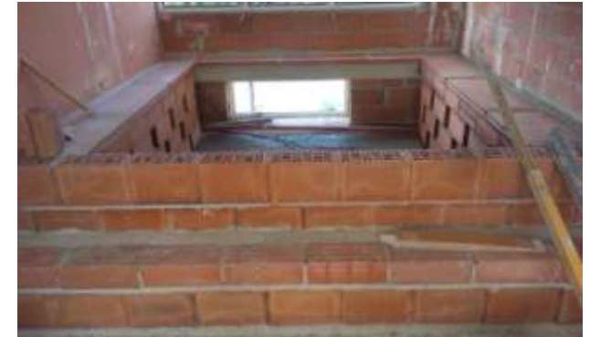
FOTO.75- Encajonado para jacuzzi con ladrillos cerámicos.
