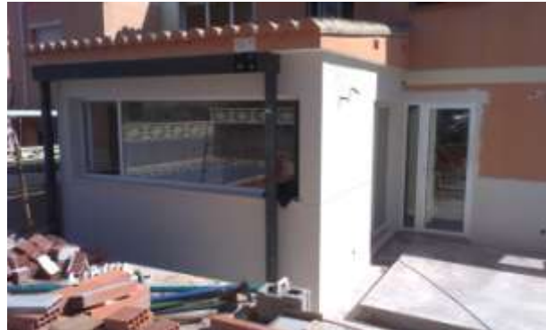
FOTO.68- Recrecido con hormigón en terraza y revestimientos exteriores con mortero impermeable en fachada comedor.
