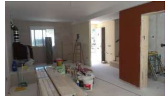
FOTO.102- Revestimientos con pinturas y colocación de chimenea en comedor.
