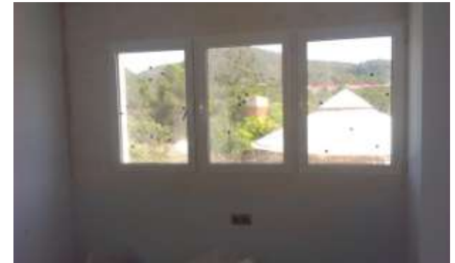
FOTO.117- Colocación de ventana en gimnasio.
