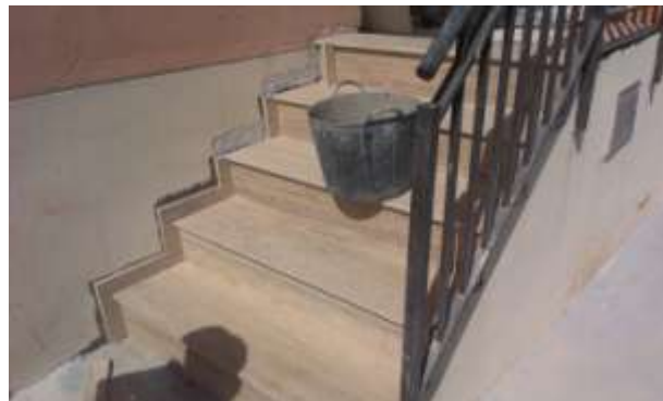
FOTO.95 Revestimiento con mármol travertino en escalera exterior en entrada principal.
