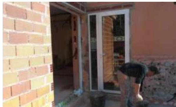
FOTO.41-Colocación de carpinterías en comedor y cocina.
