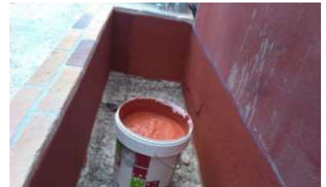
FOTO.78- Revestimiento con pintura impermeabilizante en paredes de jardinera exterior.
