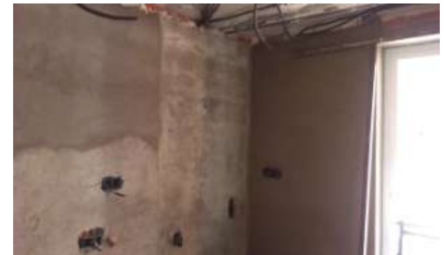
FOTO.42-Enfocado de paredes en cocina
