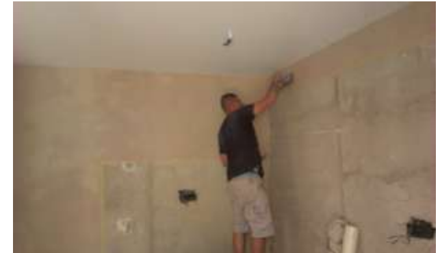
FOTO.105-Revestimiento vertical con microcemento en paredes de cocina.
