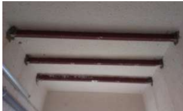
FOTO.20-Colocación de perfiles IPN-100.
