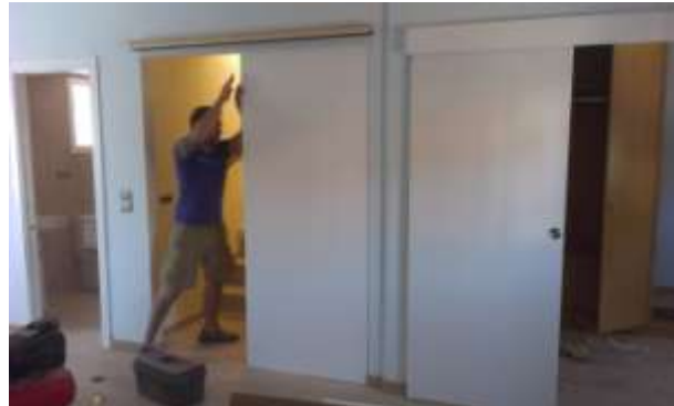
FOTO.122- Colocación de puertas correderas en Estudio, Dormitorio principal y Baño P.1.
