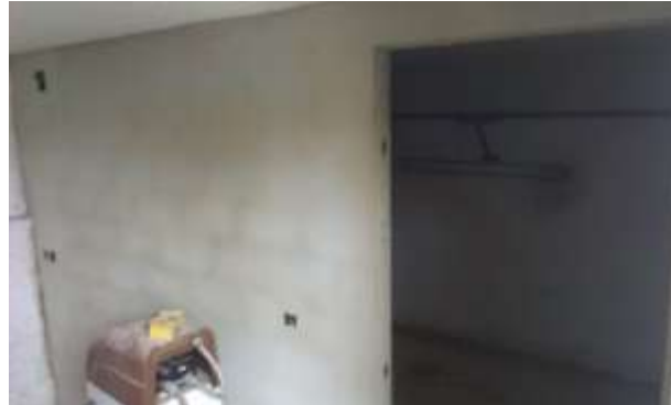
FOTO.80- Realización tabique de separación en P.Sótano.
