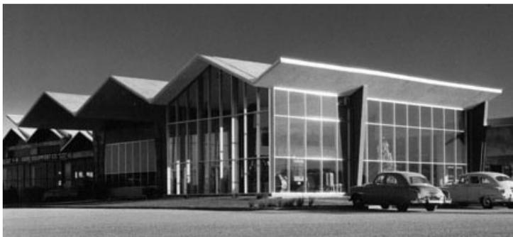
FIG. 3.14. LOSA PLEGADA H.W.MOORE EQUIPMENT CO, EEUU
