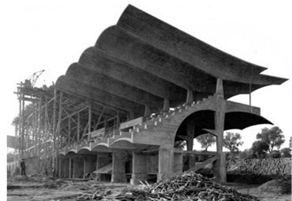
FIG. 2.36. PROCESO CONSTRUCTIVO
