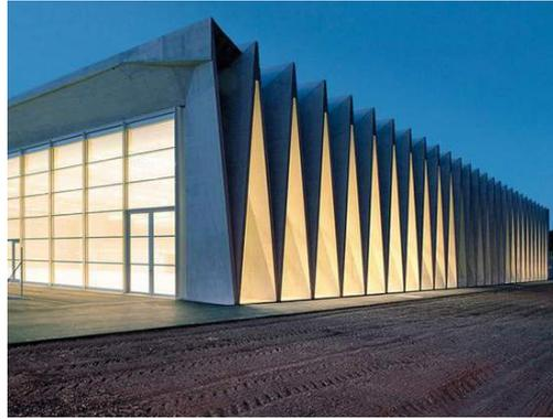
FIG. 3.30. FACHADA CON LÁMINAS COMO SOPORTE
