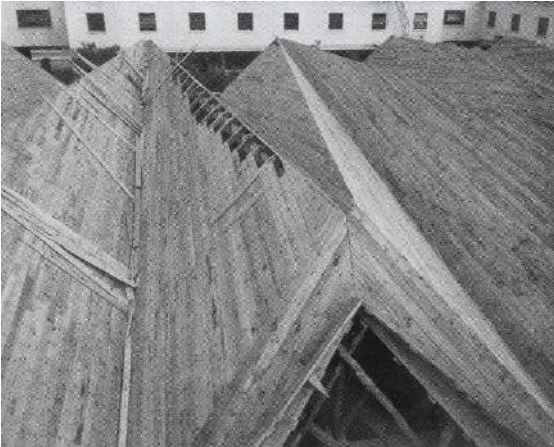
FIG. 4.70. FINAL PROCESO DE EJECUCIÓN
