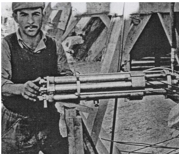
FIG. 4.69. TESADO DE LOS TENDONES
