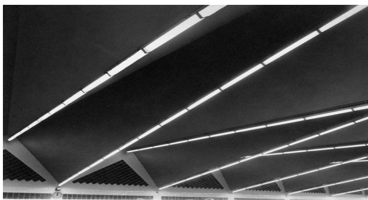
FIG. 4.19. VISTA INTERIOR CUBIERTA
