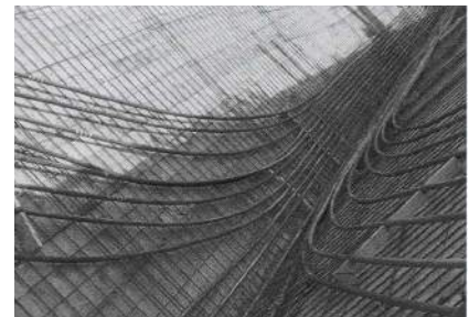
FIG. 5.6. CABLES DE POSTESADO
