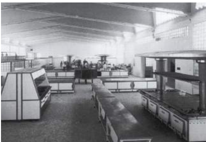
FIG. 5.4. INTERIOR DEL PABELLÓN
