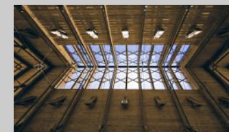
Fig 55. Vista lucernario interior.
