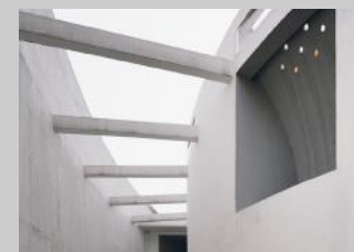
Fig 196. Vista exterior. Detalle vano
