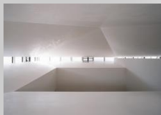
Fig 193. Vista interior detalle cubierta
