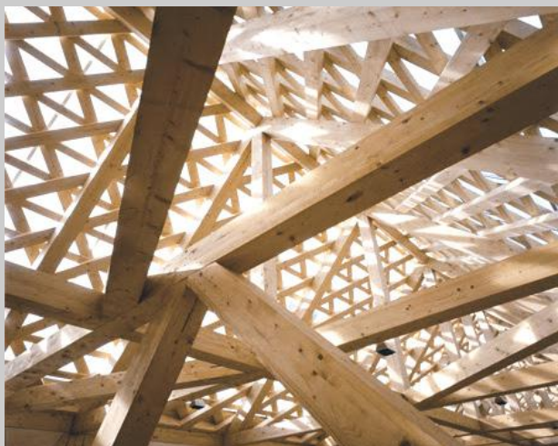
Fig 248. Vista interior 1 . Detalle entramado de madera
