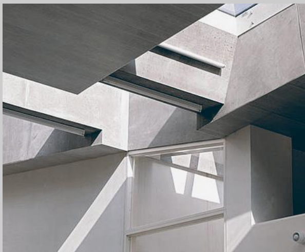
Fig 51. Vista interior 1. Detalle lucernario.
