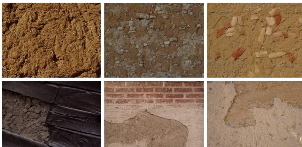
Fig.6 – Acabados de muros en tapia con fibras, gravilla, tejoletas, madera, cal y yeso (Vegas- Mileto- Cristini)
