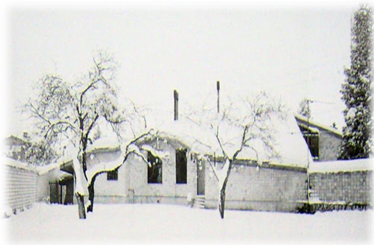
Imagen 5: Vista exterior de la casa Durana
