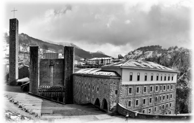
Imagen 3: Vista exterior del Santuario de Aránzazu
