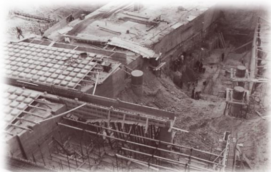
Imagen 41: Preparación de forjado
