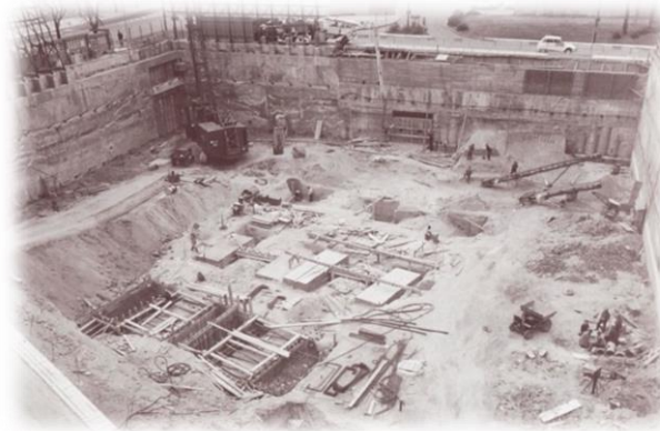
Imagen 29: Vista de la excavación
