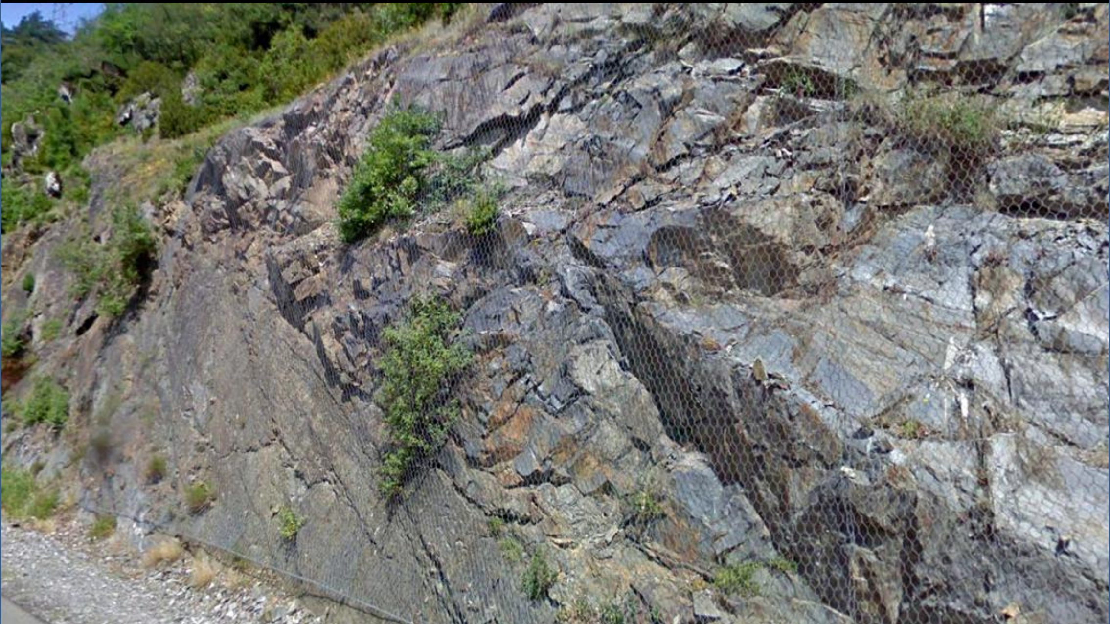
Mallazo en el talud de cuarcitas y pizarras negras del Frasnense, Devónico. W de Arrós, Lérida. E Hoja de Bosost.
