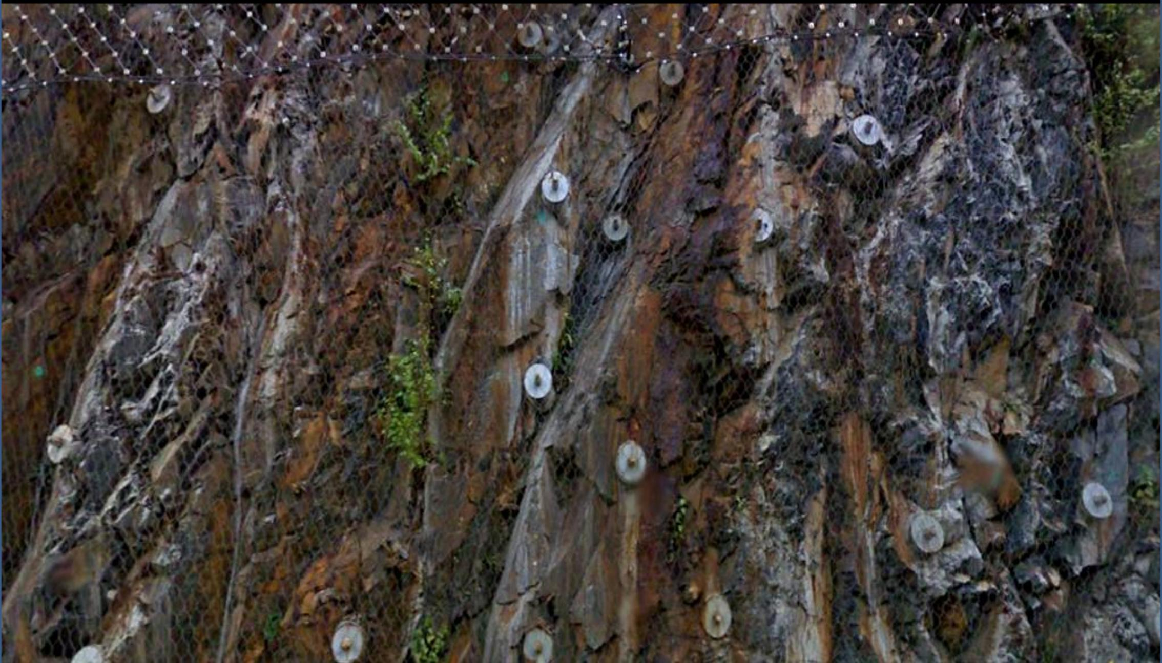
Talud bulonado y con mallazo, de rocas cuarcíticas del Paleozoico Inf., tectonizadas, y metamorizadas. N de Andorra La Vella. SW Hoja.
