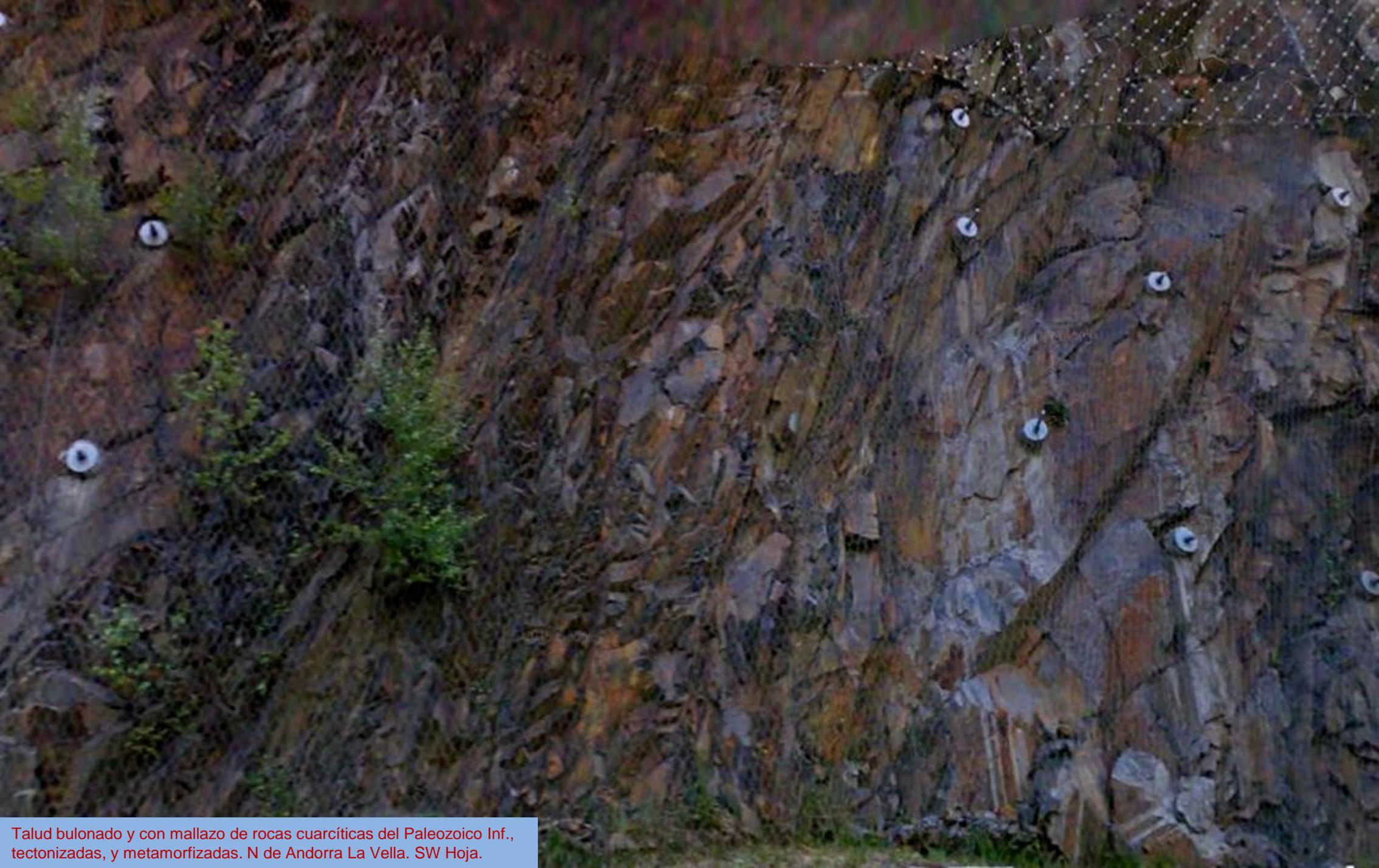
Talud bulonado y con mallazo de rocas cuarcíticas del Paleozoico Inf., tectonizadas, y metamorfizadas. N de Andorra La Vella. SW Hoja.
