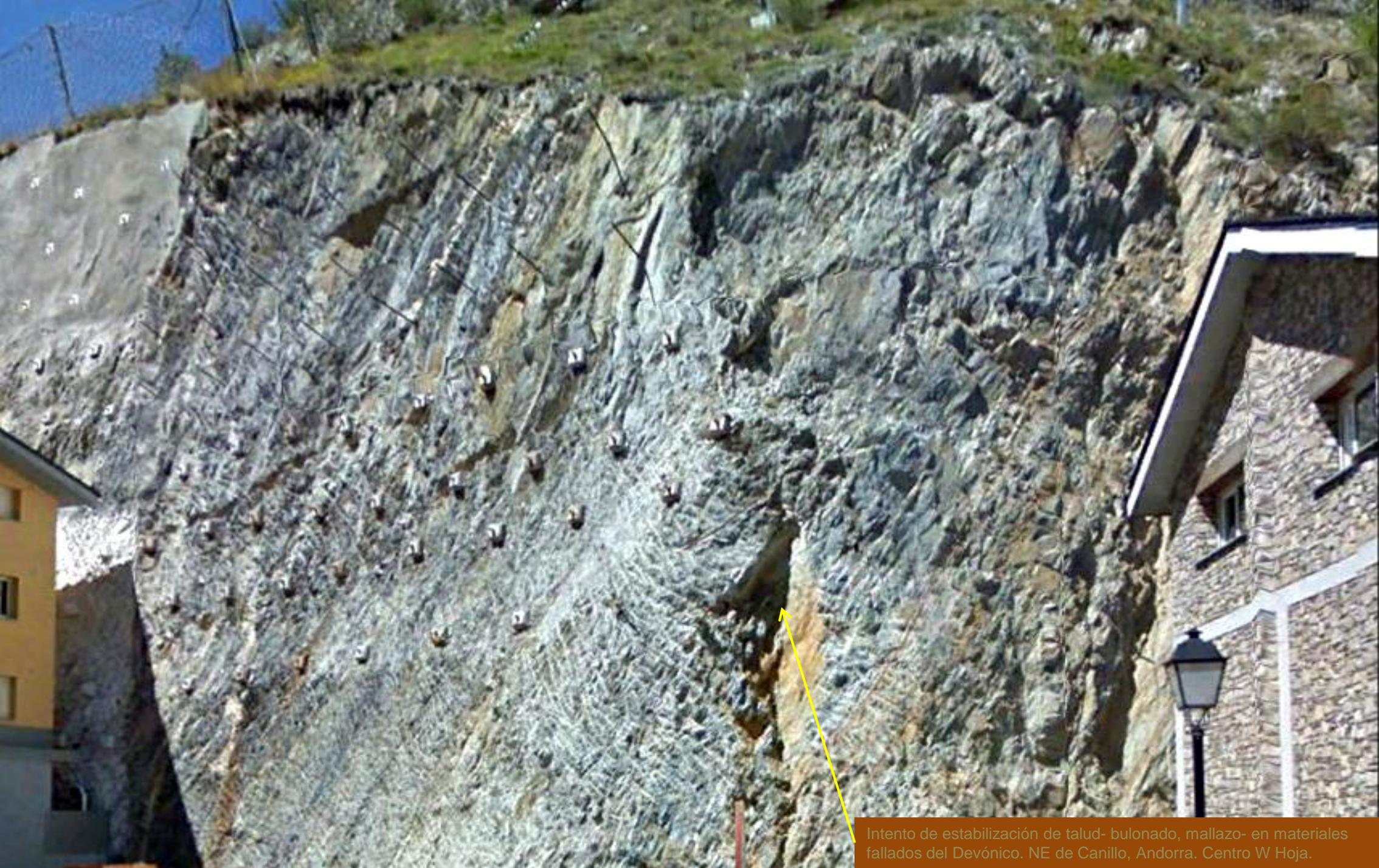
Intento de estabilización de talud- bulonado, mallazo- en materiales fallados del Devónico. NE de Canillo, Andorra. Centro W Hoja.
