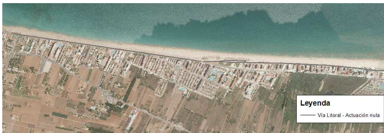
Vía Litoral - Subtramos 1 y 2
