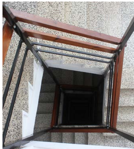
15. izda. Edificio “Don Pedro”. Juan Guardiola Gaya (Playa de San Juan, Alicante; 1964). Tramo de finalización de la barandilla.
