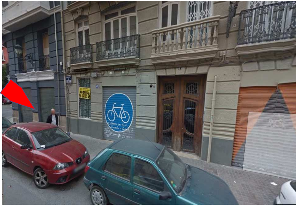
Imagen 3: Situación de la puerta del local desde la calle Denia.
