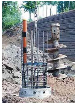
Figura 3.6: Captación vertical Fuente (Argadi Ingenieros)
