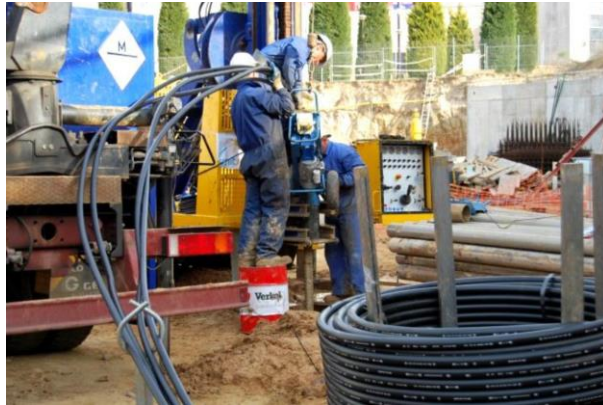
Figura 3.10: Introducción de una sonda geotérmica doble con un slangman.
