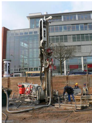
Figura 3.7: Perforadora con doble unidad de rotación y manguera para descarga de detritos en un contenedor. (Fuente: Comacchio).
