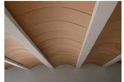
f.40 - forjado de vigueta de hormigón enalado y vigueta cerámica curva
