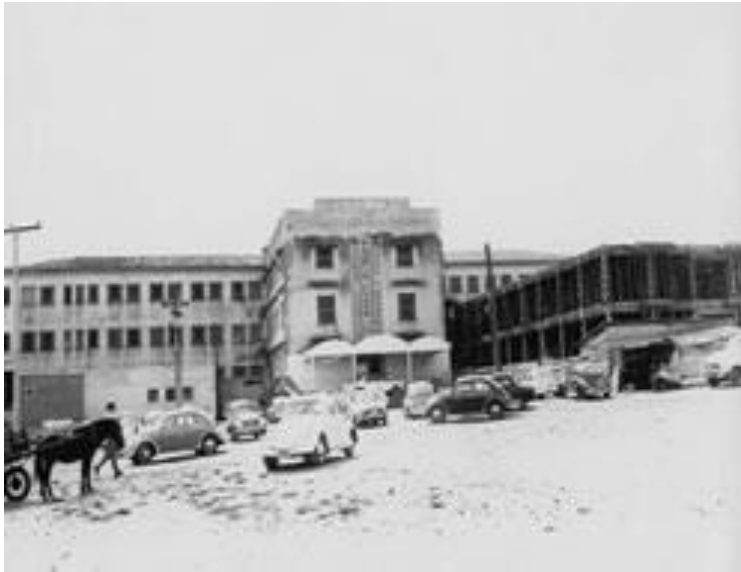
FIGURA: 172 HOTEL SENDO TRANSFORMADO EM HC FONTE: www.ufg.org/hc
