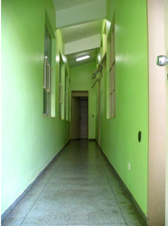
FIGURA 297. CIRCULAÇÃO DE ENTRADA DO CENTRO CIRÚRGICO DO HPM. FOTO DA AUTORA.
