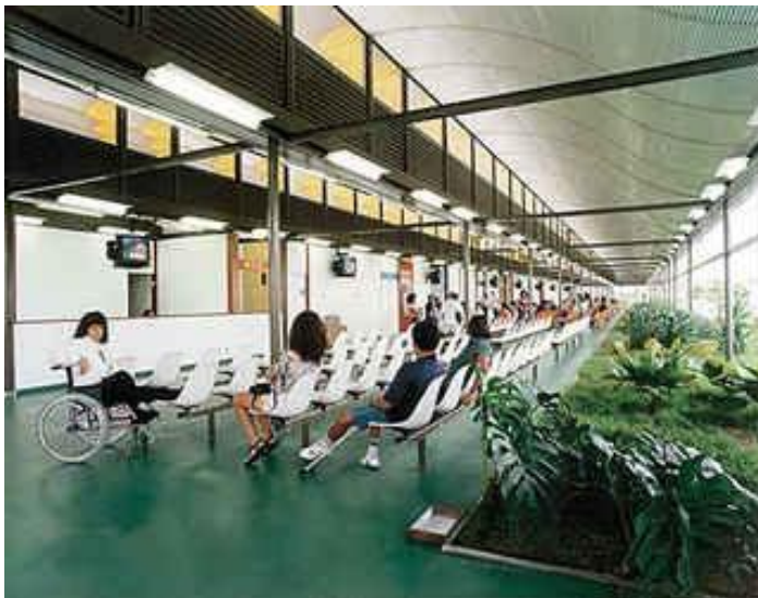
FIGURA 145 – HOSPITAL DO APARELHO LOCOMOTOR, SALVADOR-BA, DE JOÃO FILGUEIRAS LIMA, O LELÉ: NA FOTO, A ÁREA DE ESPERA PARA ATENDIMENTO. FOTO: TEC
