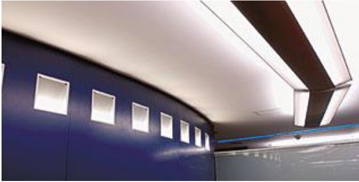
FIGURA 107 DETALHE DO FORRO ENTRE A RECEPÇ3O E A ENTRADA DE EMERGÊNCIA FONTE: ARCO WEB, FOTO: CARLOS CRUZ, 2003.
