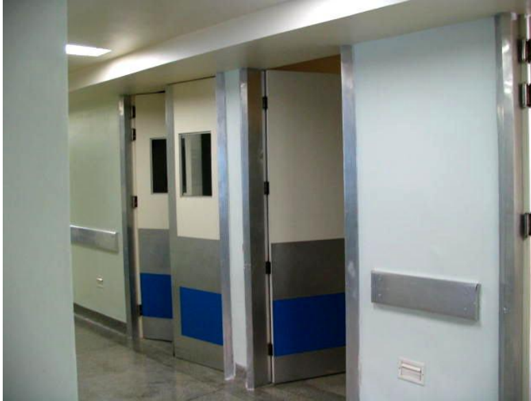
FIGURA 312. CIRCULAÇÃO DO CENTRO CIRÚRGICO DO HPM EM 2014. FOTO DA AUTORA.
