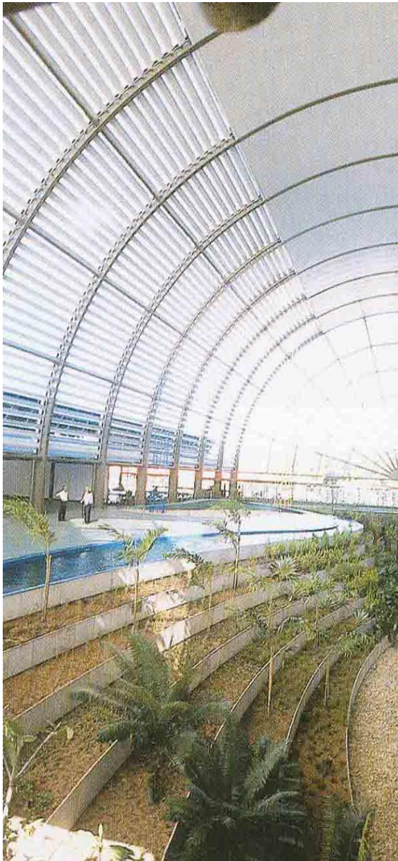
FIGURA 134 – HOSPITAL SARAH DE SALVADOR, BRASIL. CIRCULAÇÃO DOS SEIS NÍVEIS DAS ENFERMIARIAS. A ILUMINAÇÃO CONSTANTE É REGULADA POR ARCOS COM VENEZIANZAS. FONTE: CTRS.
