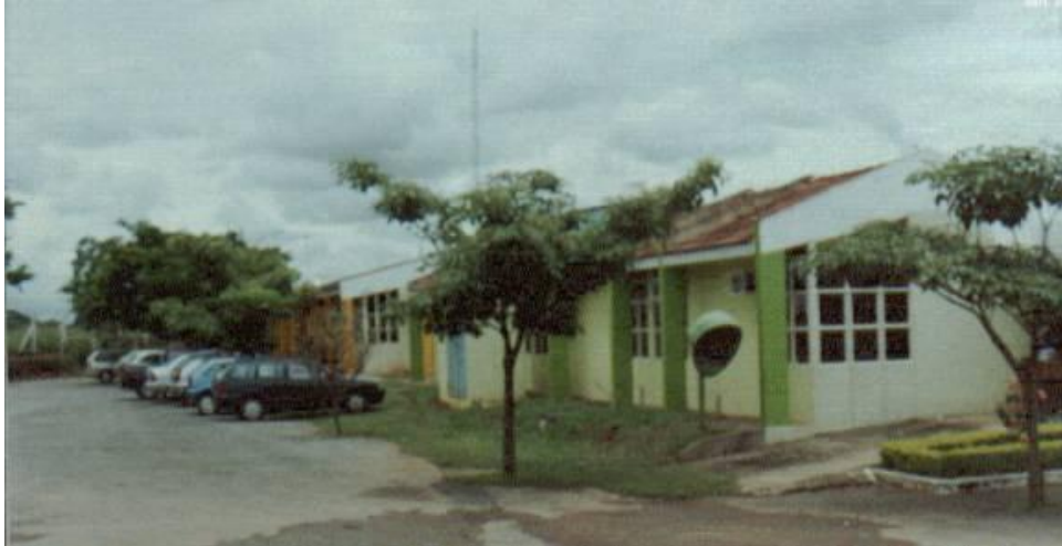
FIGURA 179. FACHADA PRINCIPAL DO HPM. FOTO DA AUTORA.
