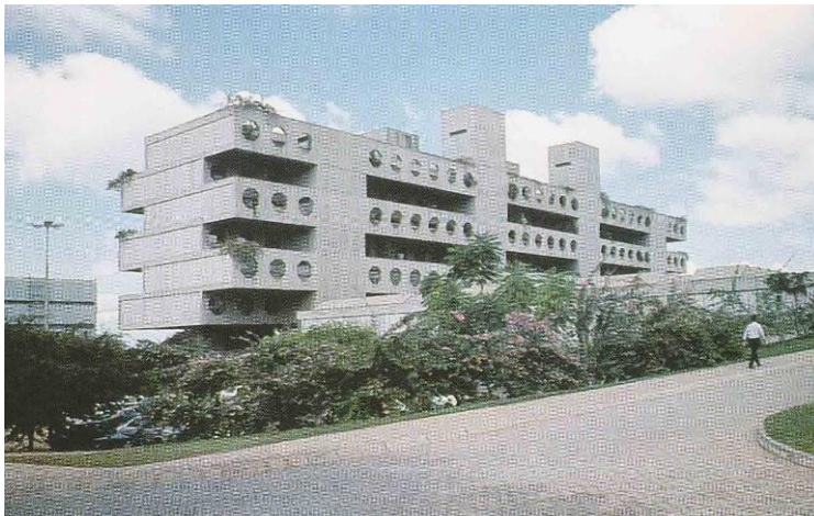
FIGURA 143 – HOSPITAL SARAH DE BRASÍLIA, BRASIL. VARANDAS QUE DÃO PARA AS ENFERMARIAS. VISTA INTERNA. FONTE: CTRS.
