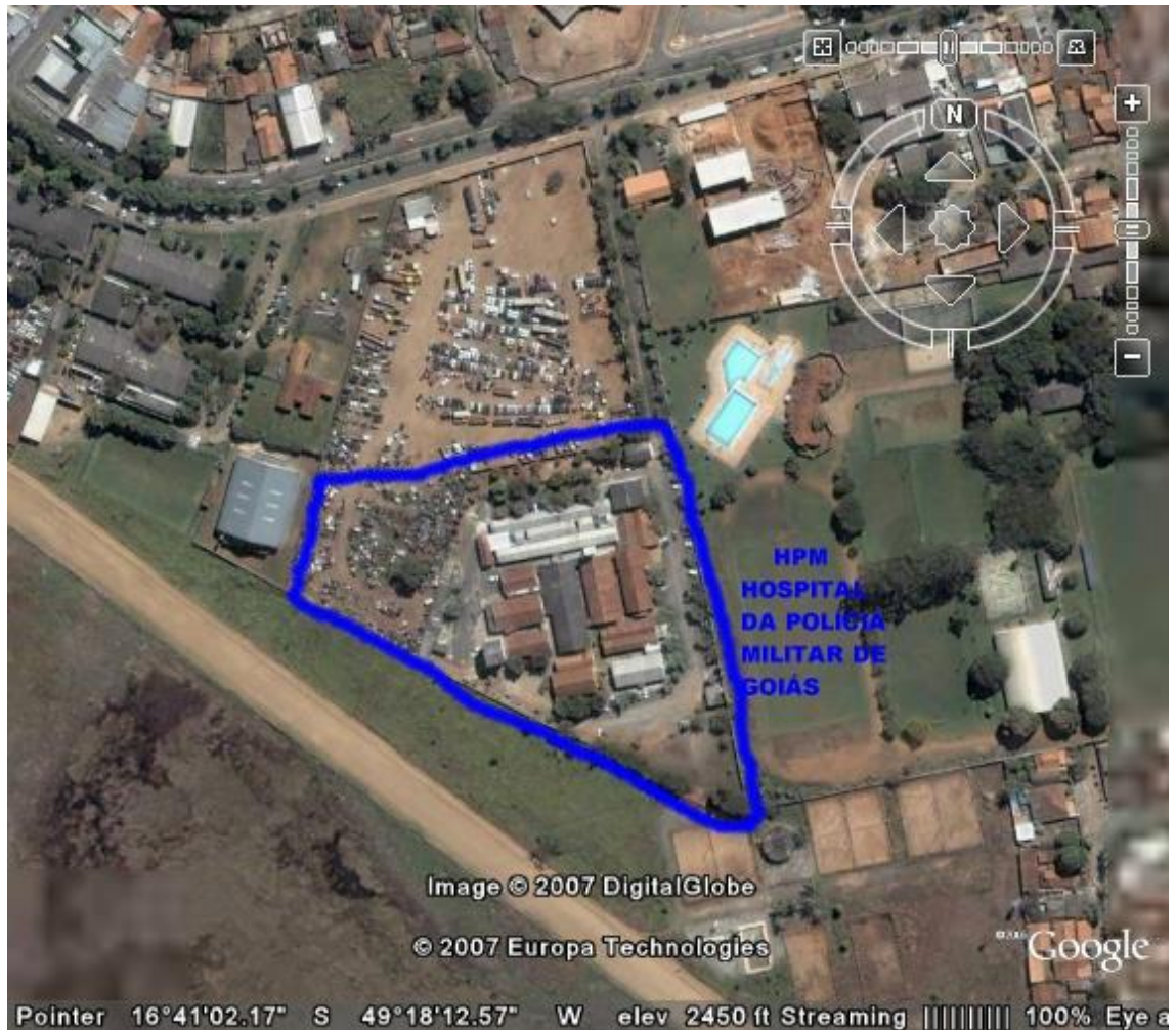
FIGURA: 170 ÁREA DO HOSPITAL DO HOSPITAL DA POLÍCIA MILITAR. TOTALMENTE HORIZONTALIZADO, CONTA COM UMA ESTAÇÃO PRÓPRIA DE ESGOTO. FONTE: GOOGLE.
