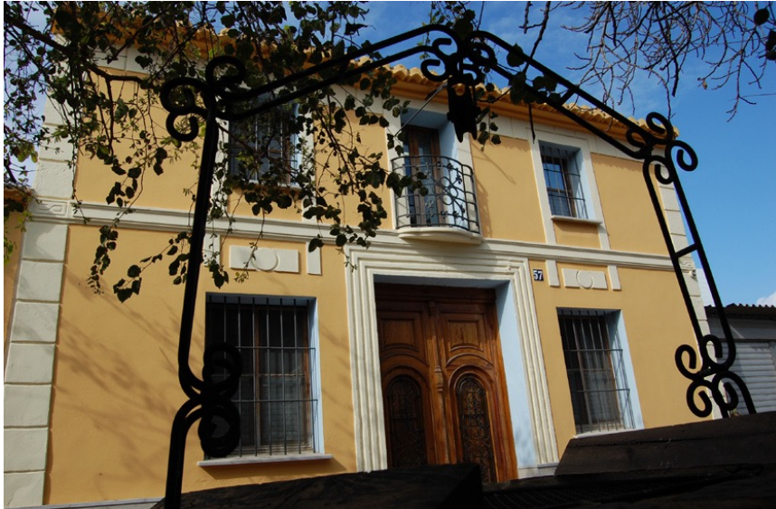
Figura 2.1. Fachada principal de la sede de la Fundación.
