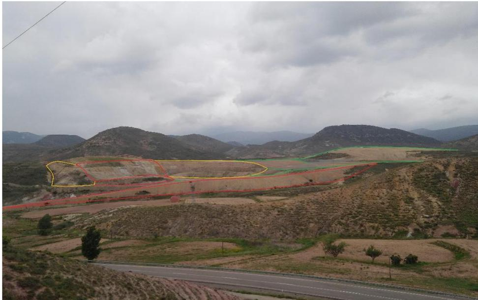
Figura 2. División de zonas en la mina en función del método de revegetación a utilizar.
