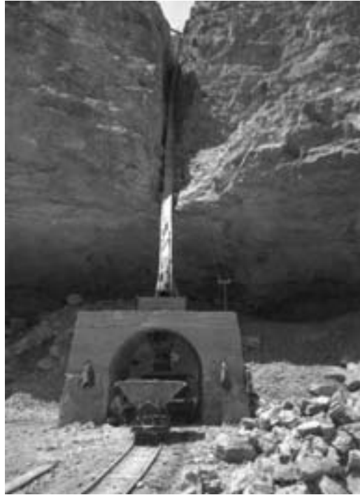
Depósito de recogida de hormigón y vertido con tolva sobre vagoneta. Fuente: CHJ.
