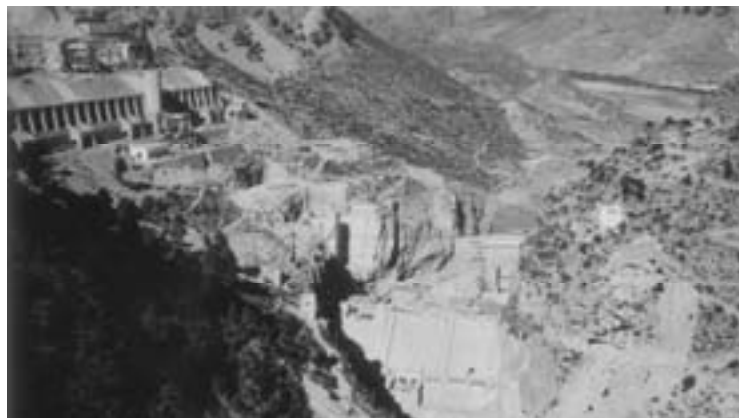
Vista general de la planta de hormigonado. 1947. Fuente CHJ.
