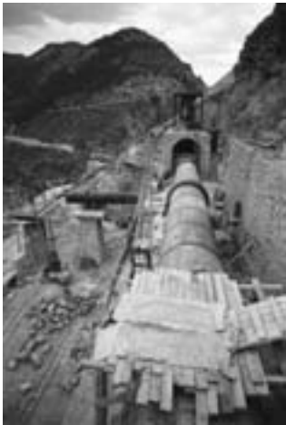
Horno rotatorio, molino Raymond (fondo), enfriadora (nivel inferior). Fuente: CHJ
