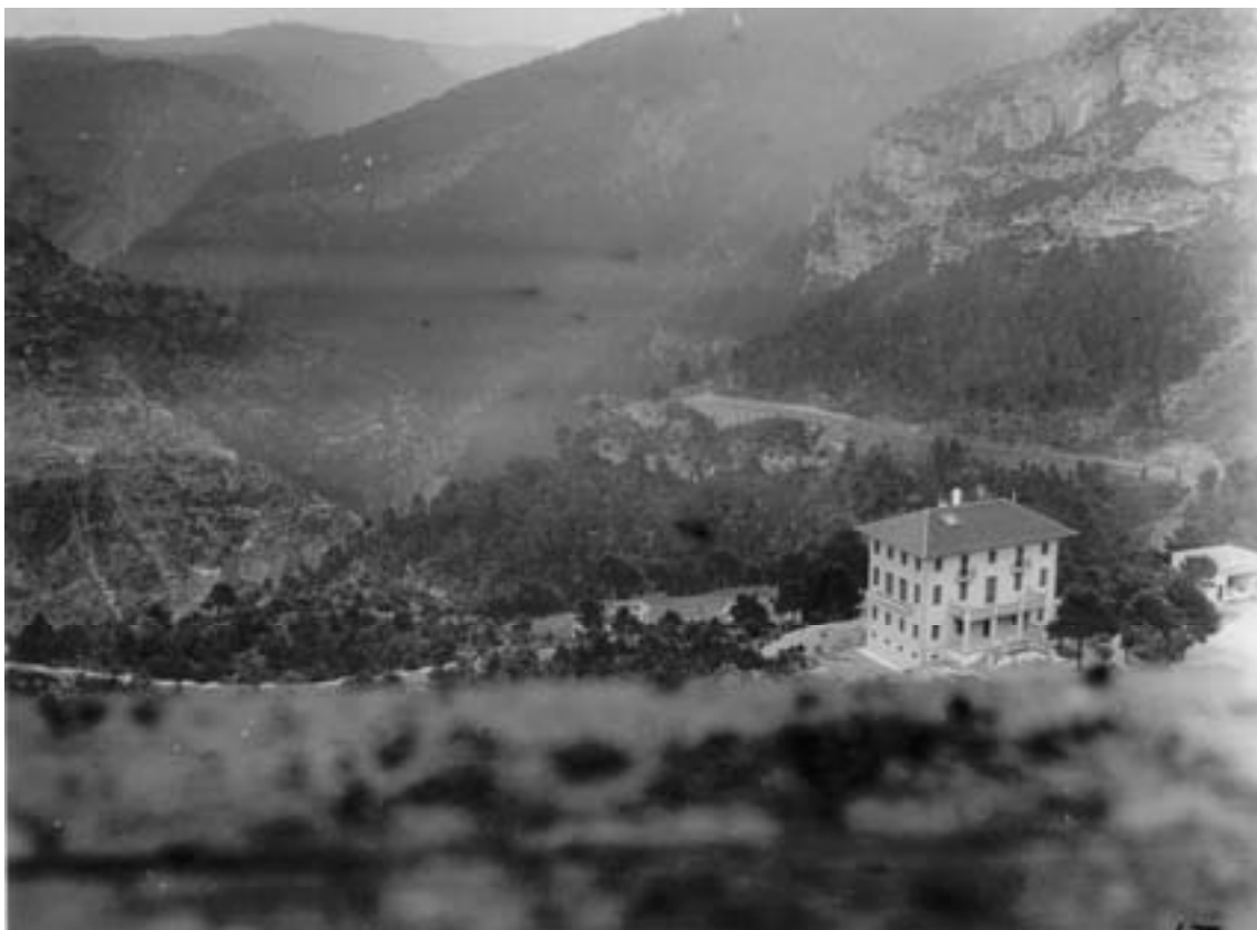
Vista del edificio Casa-Dirección desde el edificio Hospital.
