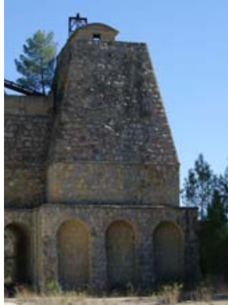
Tolva. Fábrica Benagéber. Fuente: la autora. 2011.
