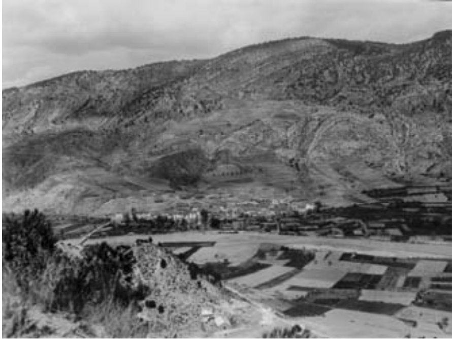
Vista panorámica del paisaje de Benagéber anterior a la construcción del embalse. 1936.
