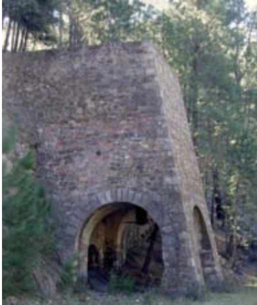
Tolva. Mina Henarejos. Fuente: J.M.Sanchis. 2010
