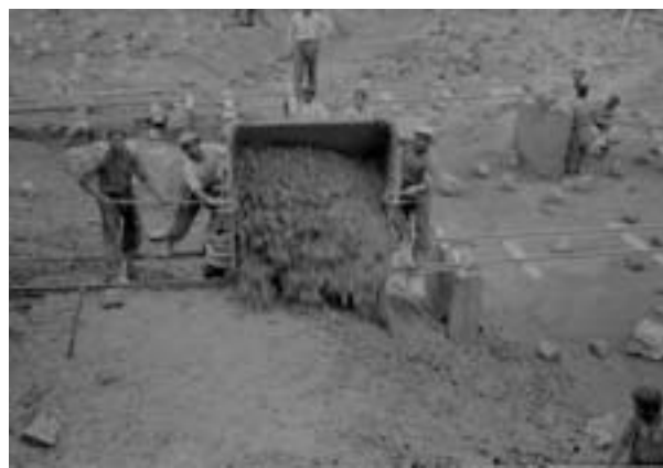
Vertido de hormigón en alzado de presa. Fuente: CHJ.
