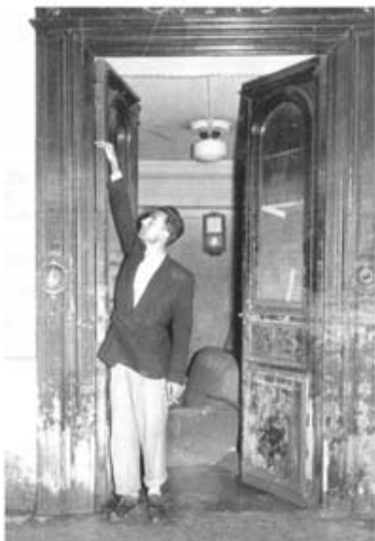
Cota de la riada en la CHJ. Octubre de 1957 La avenida causó desperfectos en la Dependencia Hidráulica
