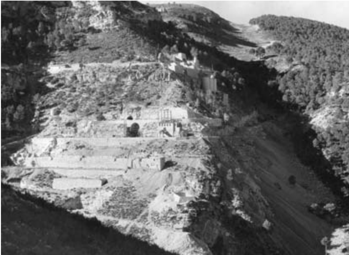
Estado de las obras 1943 (fecha apuntada por la autora). Fuente: CHJ.
