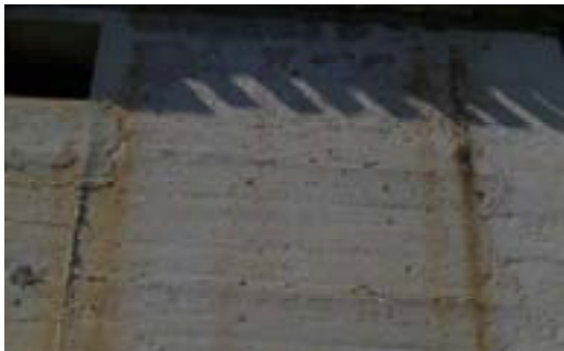
Vista de la huella del molde junto a esquina de mampostería careada. Foto de la autora
