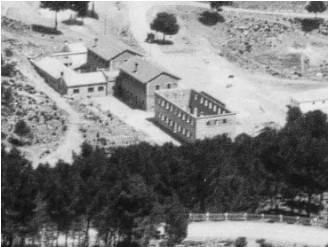
Fotografía datada en fecha 2 de agosto de 1944. Estado de las obras. Fuente: Ayuntamiento de Benagéber.
