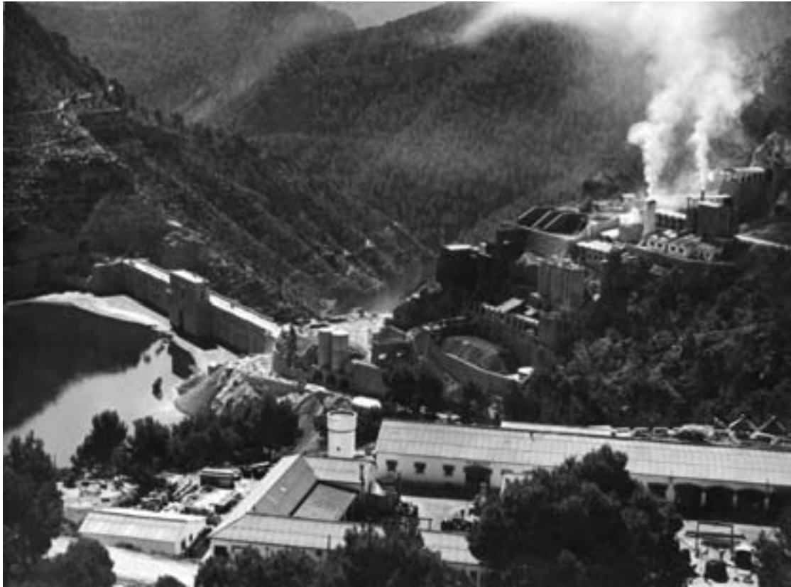
Vista de la fábrica de cementos e instalaciones auxiliares antes del cierre de la actividad. Fuente: CHJ.
