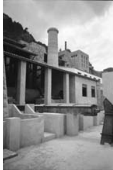
Instalaciones de Refino
