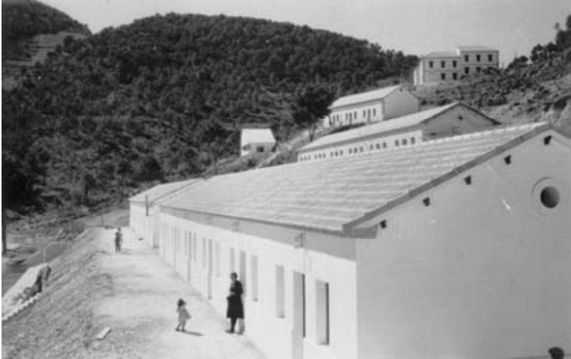
Viviendas ocupadas. Obras de urbanización en construcción. Fuente: Ayuntamiento de Benagéber
