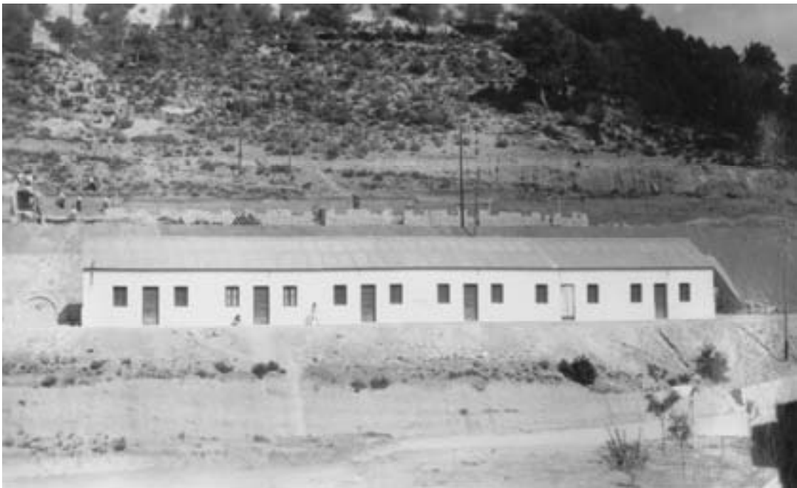
Viviendas acabadas en primer plano y en construcción al fondo.
