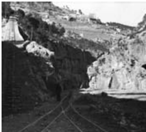
Plano inclinado y vías en fondo presa. Fuente: CHJ.
