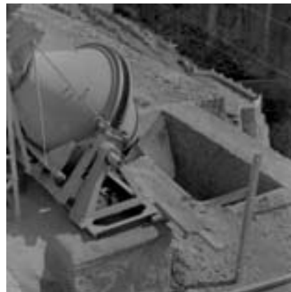
Hormigonera y tolva de descarga. Fuente: CHJ
