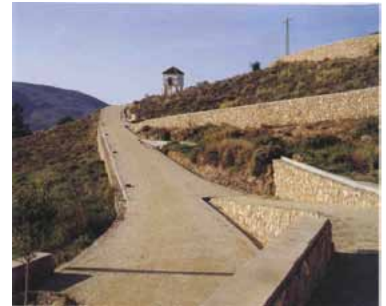
Parque de la Alpujarra, Berja, Almería _M. Centellas y O. Tarrasó Arquitectos
