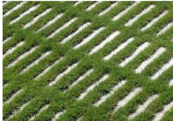
Pavimento de losas coladas de hormigón,
