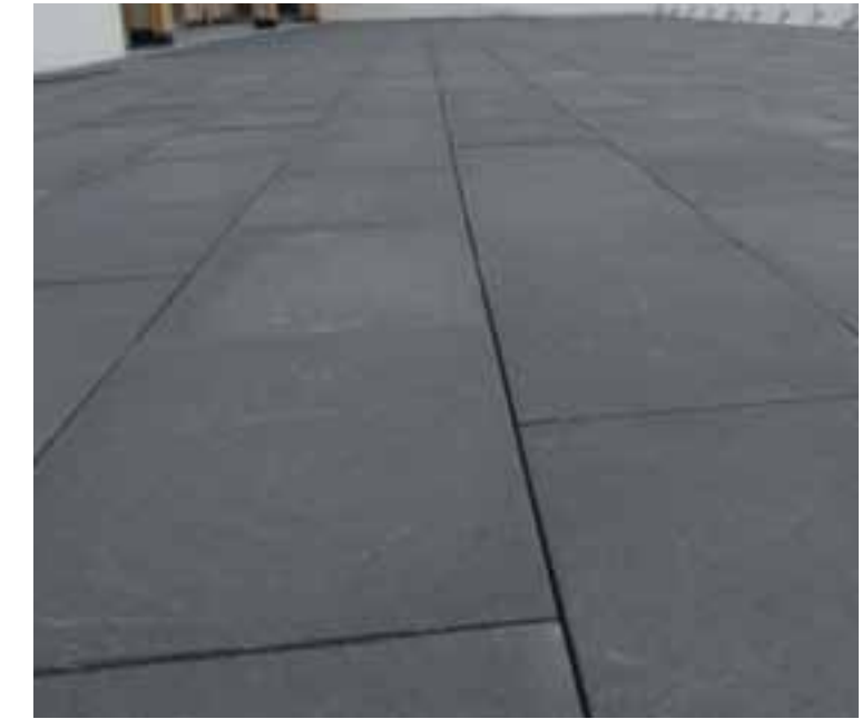
Pavimento de losas de hormigón prefabricado
