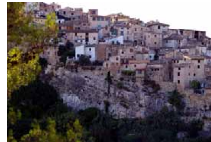
Casas colgadas en Bocairente, Valencia
