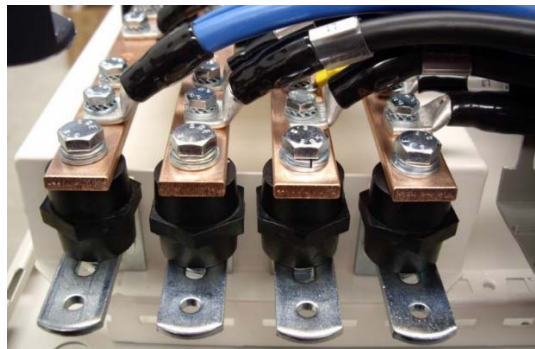
Fig. 2. 8. Agrupación de cables en pletina de cobre
