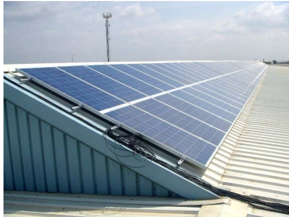
Fig. 2. 4. Ejemplo de estructura coplanar sobre cubierta inclinada
