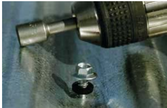
Fig. 2. 2. Detalle de tornillería autoperforante sobre cubierta
