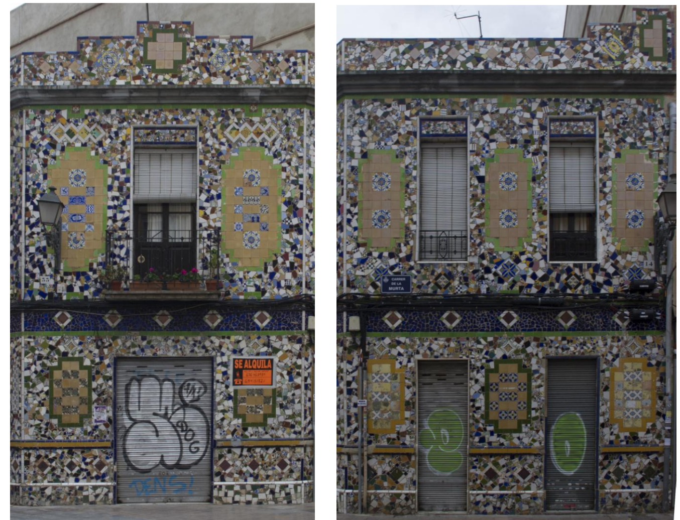
Figura 60. Cerramiento de fachada revestido mediante la técnica del trencadis. Elaboración propia
