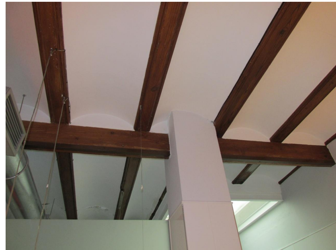
Figura 55. Fotografía de la estructura de vigas y viguetas de madera en el encuentro con el pilar. Elaboración propia
