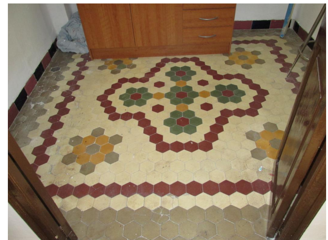
Foto 14 - 17. Diferentes suelo hidráulicos de las viviendas de planta primera
