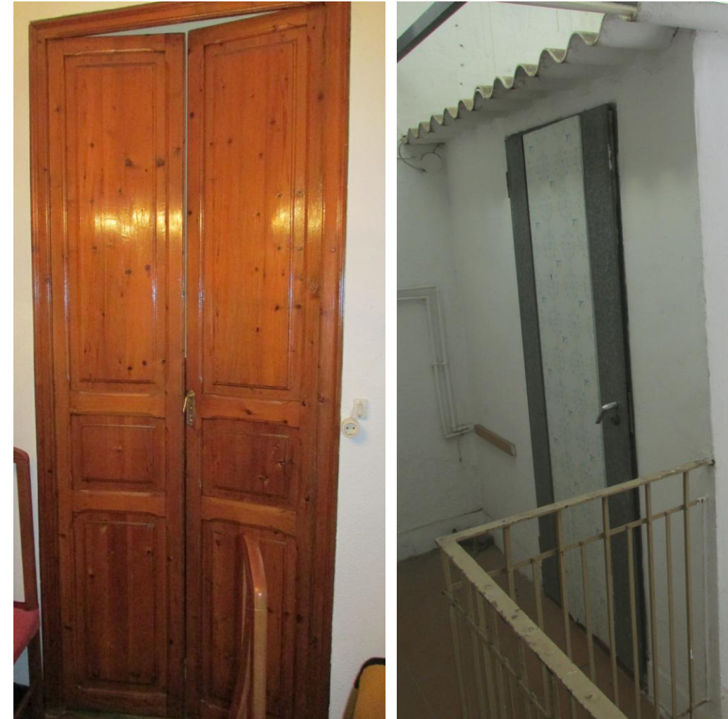
Figura 69. A la izquierda puerta de madera de doble, a la derecha puerta de baño de acero. Elaboración propia.
