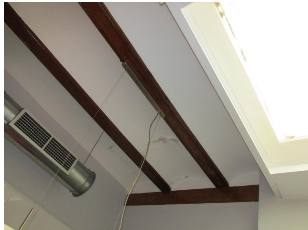
Fotos 18 - 19. Techo de revoltón en planta baja
