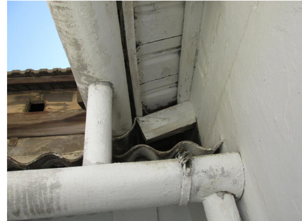
Fotos 24. Detalle encuentro canalones y bajantes
