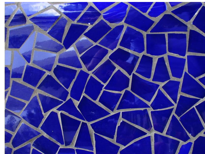
Figura 38. Trencadís del Park Güell (arriba) y de la Ciudad de las Artes y las Ciencias (abajo)
