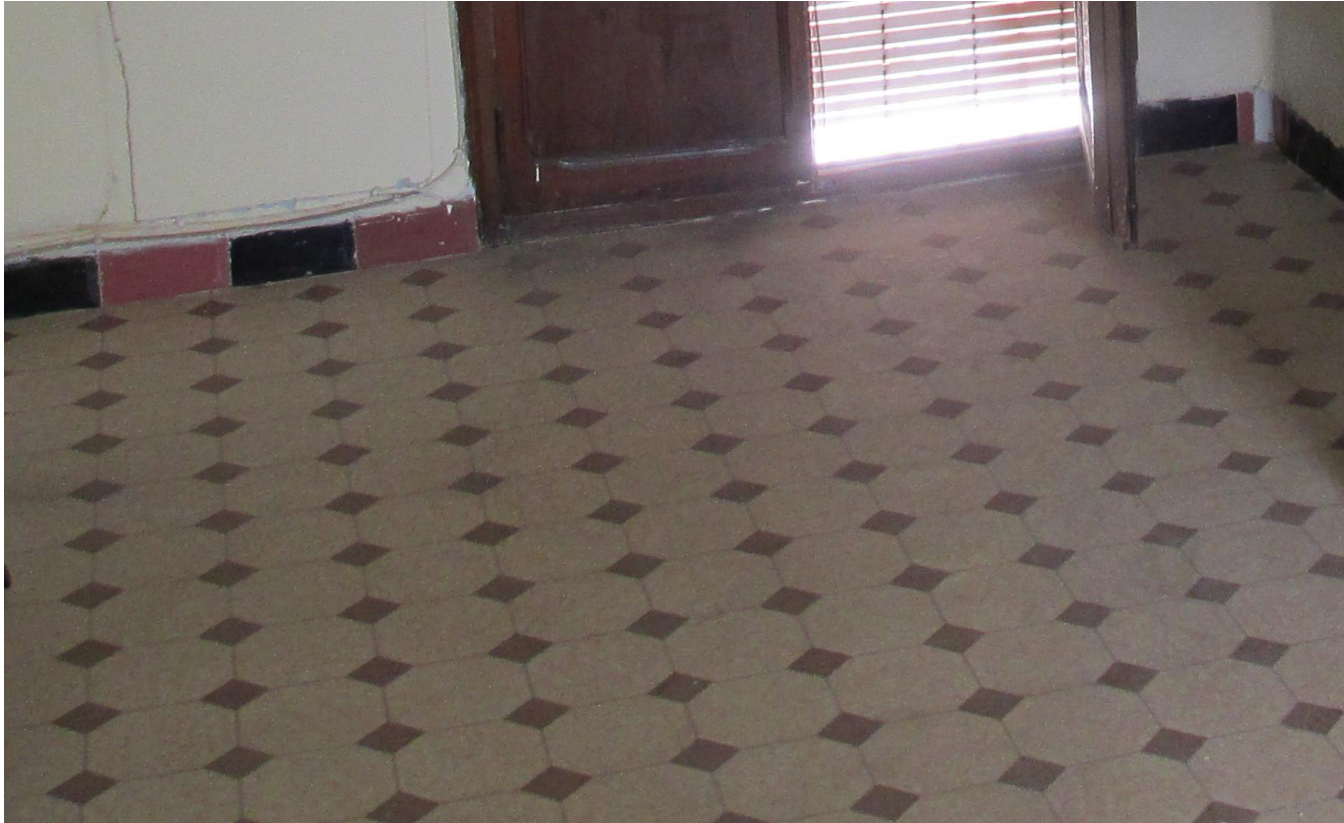
Figura 65. Suelo vinílico adhesivo simulando pavimento hidráulico. Elaboración propia
