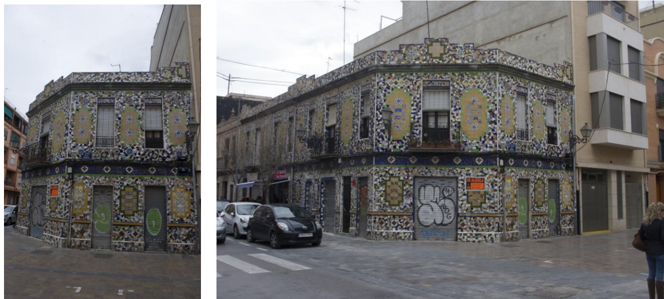
Foto 3 - 4. Calle Murta y visión general edificio.
