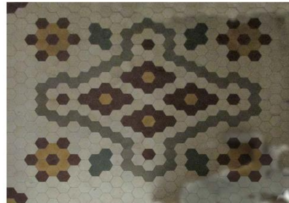
FOTOGRAFÍA DEL PAVIMENTO
