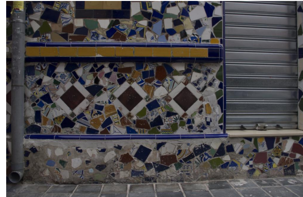
Foto 5. Detalle 'trencadís' en acceso local de planta baja
