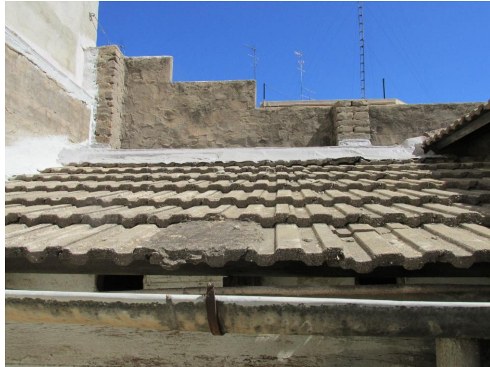
Fotos 22. Cubierta de teja plana de hormigón
