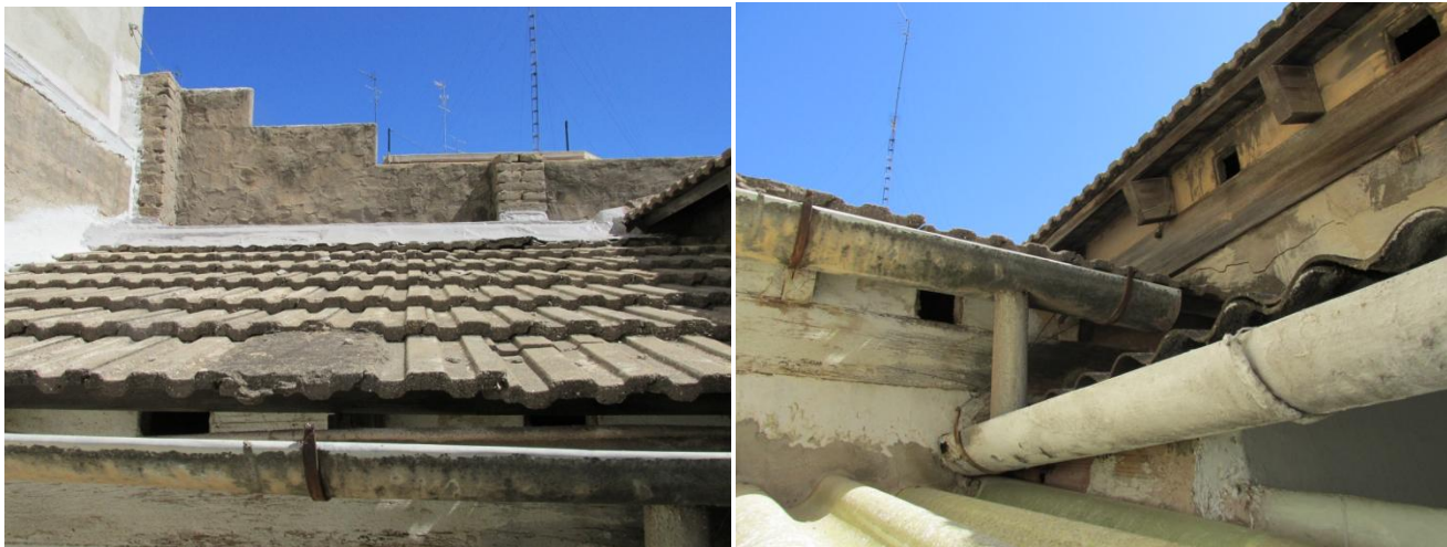
Figura 58. A la izquierda cubierta pequeña de teja de hormigón. A la derecha cubierta principal y otros tipos de cubierta de la vivienda del chaflán. Elaboración propia
