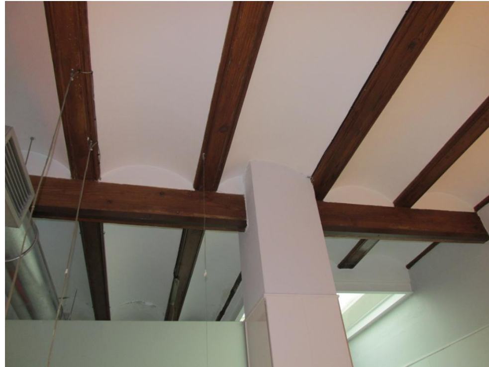
Fotos 18 - 19. Techo de revoltón en planta baja
