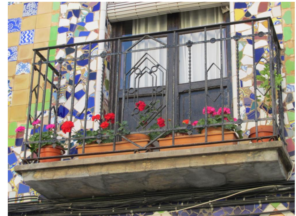
Foto 6. Detalle 'trencadís' en planta pisos y balcón
