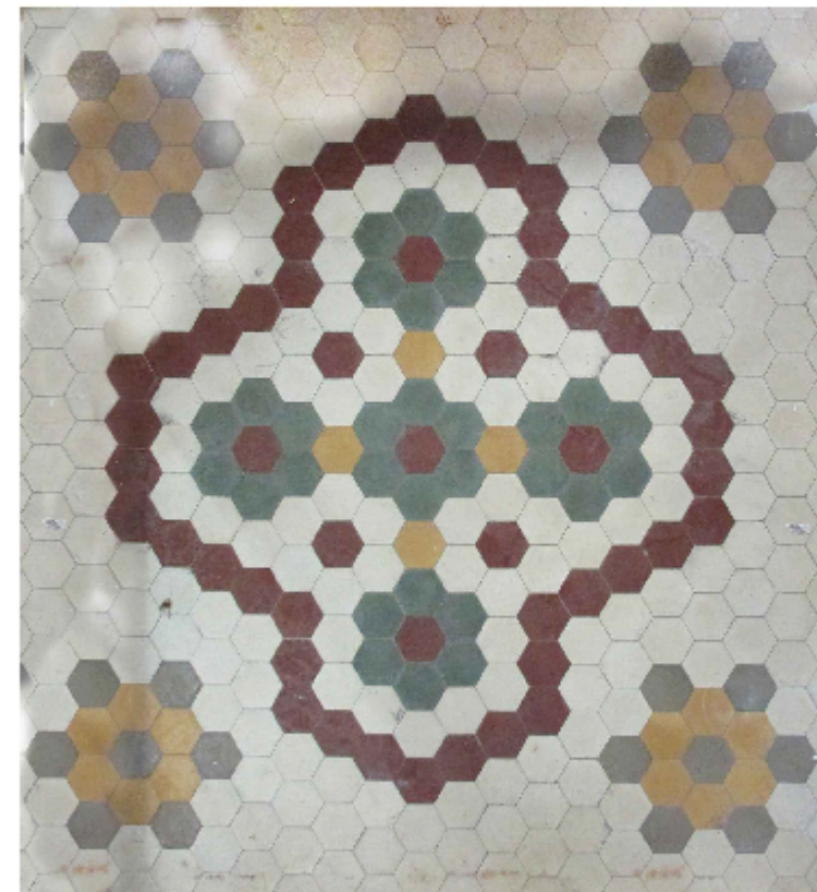
FOTOGRAFÍA DEL PAVIMENTO
