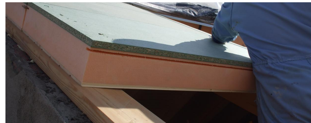
Figura 75. Fase de colocación de paneles Ondutherm yeso. (Web Ondutherm)
