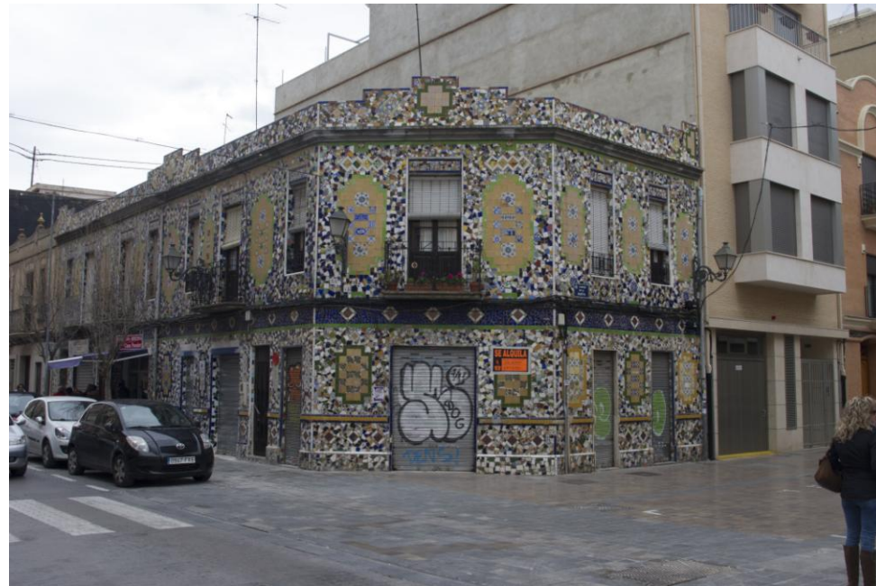
Figura 37. Foto del edificio donde podemos observar el trencadís. Elaboración propia.
