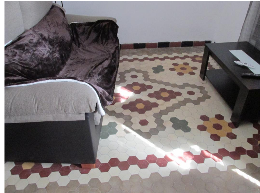
Foto 14 - 17. Diferentes suelo hidráulicos de las viviendas de planta primera
