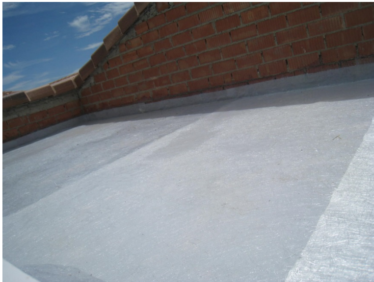
Figura 18: Cubierta Plana, recrecido, con impermeabilización vista protegida
