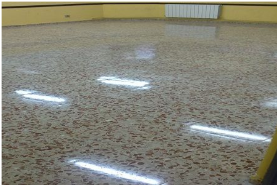
Figura 17: Terrazo sobre mortero, 50 mm de espesor
