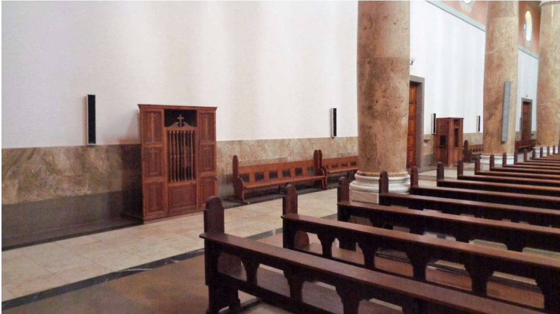
Fig. 44. Detalle de colocación de las cajas acústicas de columna en la iglesia.
