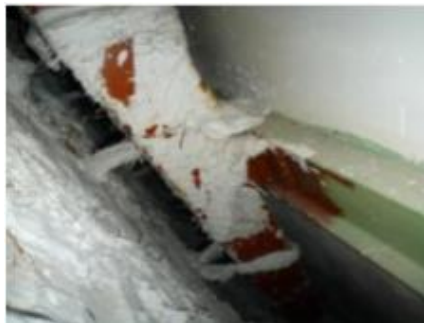
Ilustración 16 Cata Cubierta.2010.Grupo Inserman
