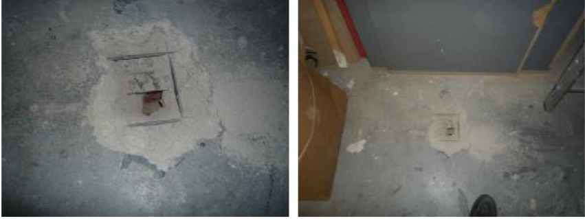
Ilustración 10 Cata Forjado Suelo Planta 1.2010. Grupo INSERMAN
