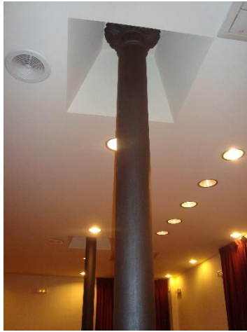
Ilustración 9 Soporte de Acero de fundición en Planta Baja.2012.J, García Valldecabres
