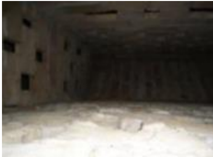
Ilustración 17 Cata Cubierta.2010. Grupo Inserman
