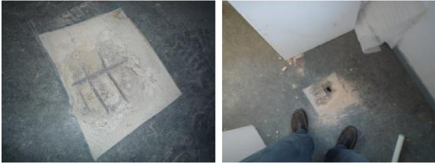
Ilustración 11 Cata Forja Suelo Planta 2.2010. Grupo INSERMAN
