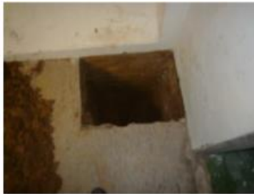
Ilustración 7 Cata Cimentación.2010.Grupo Inserman
