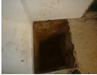
Ilustración 8 Cata Cimentación 2.2010.Grupo Inserman
