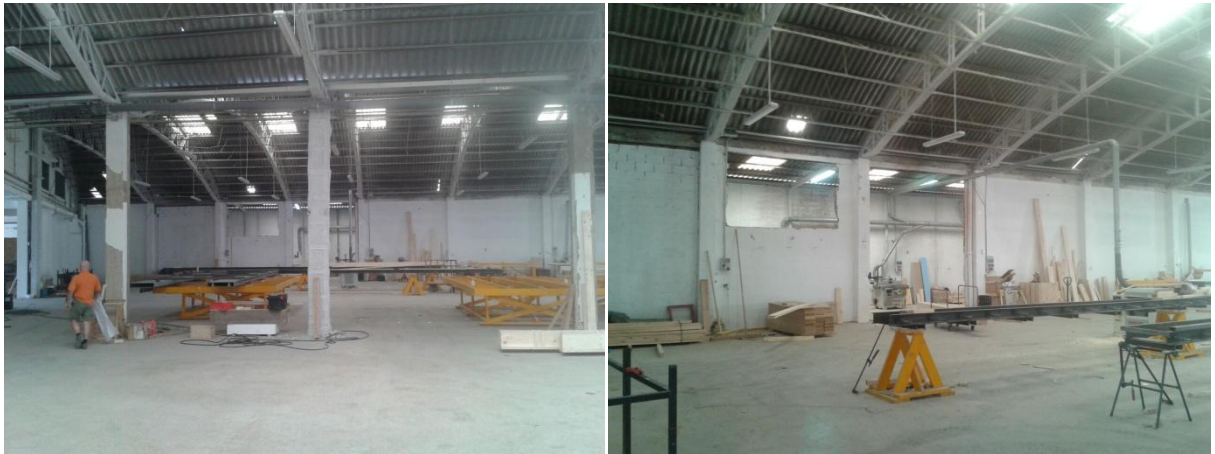
Figura 1 Fotografías de la nave industrial objeto del proyecto. 2015. Fuente propia
