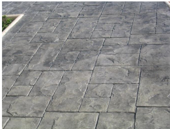
Imagen 24. Aspecto hormigón impreso adoptado
