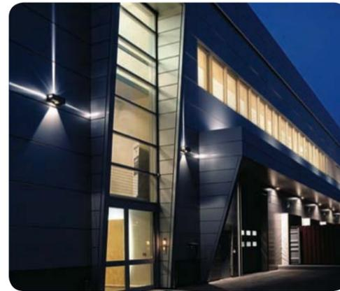
Luminaria de pared, modelo YOTA de la casa Iguzzini, realizada en aluminio de fundición a presión. Está formado por un sistema óptico basado en lentes plano-convexas y cristales de protección. Las luminarias de esta serie se caracterizan por la capacidad de realizar dibujos de luz sobre las fachadas de los edificios. El cuerpo está realizado en aluminio fundido a presión con lentes laterales de tecnopolímero de elevada transparencia y alta resistencia a los rayos UV.
