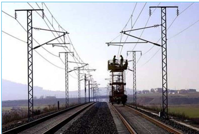
Trabajos de Electrificación de una vía.
