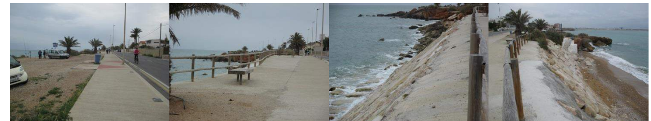
En la cala Les Roques, tiene bloques calizos de protección litoral cerca de la carretera y posee barandillas de madera. Como medida de seguridad frente al retroceso y erosión marina su talud sur ha sido completamente restaurado con bloques calizos.
