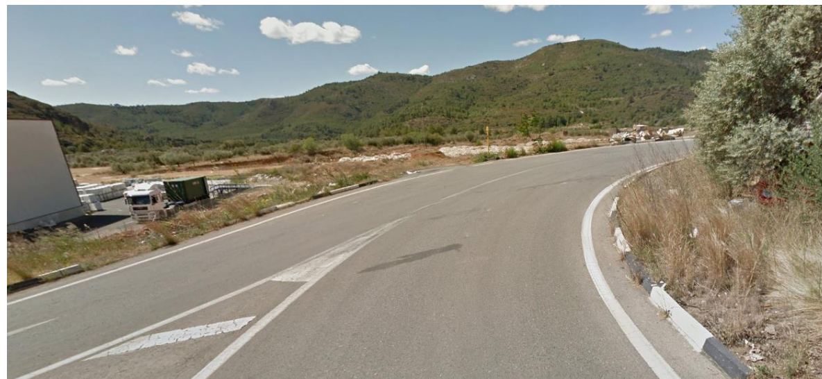
Fig. 18 Vista al sur de la glorieta. Posible zona entronque
