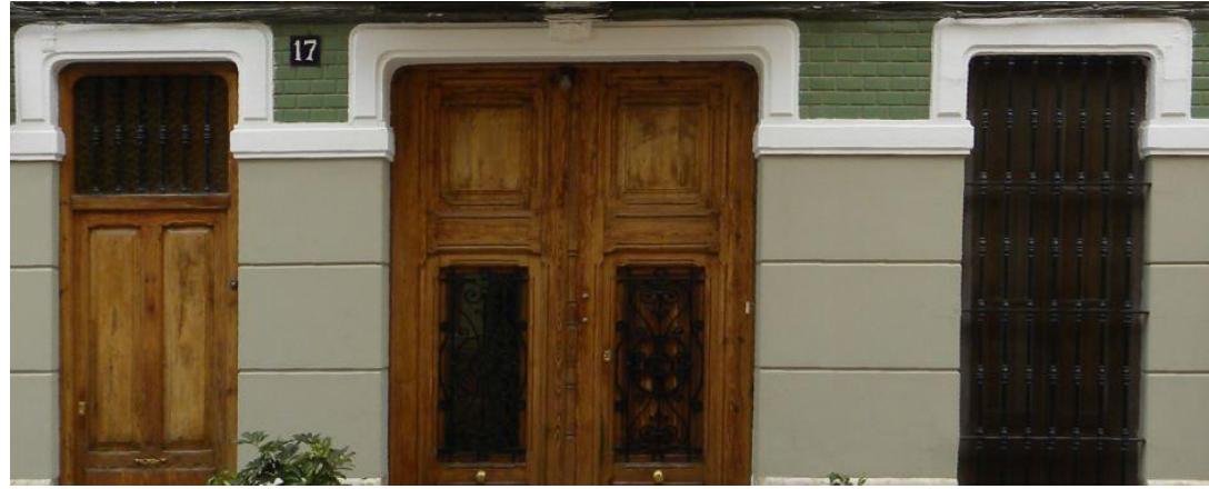
Ilustración 29. Cerrajería en puertas y ventana fachada
