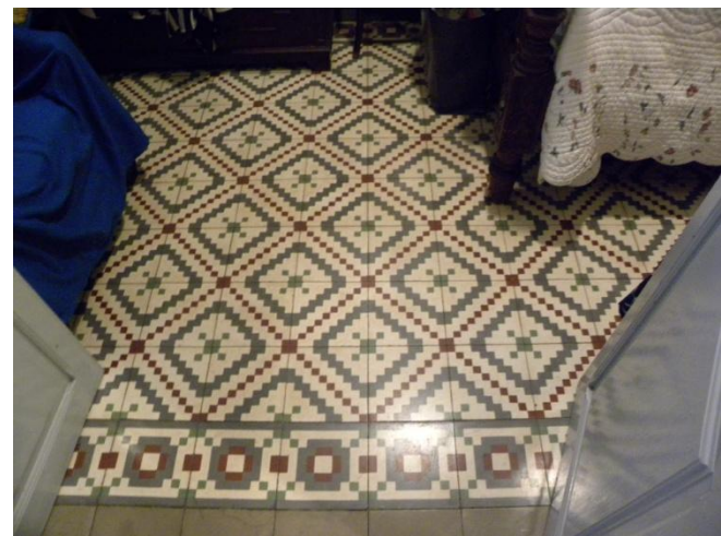
Ilustración 42. Pavimento habitación secundaria
