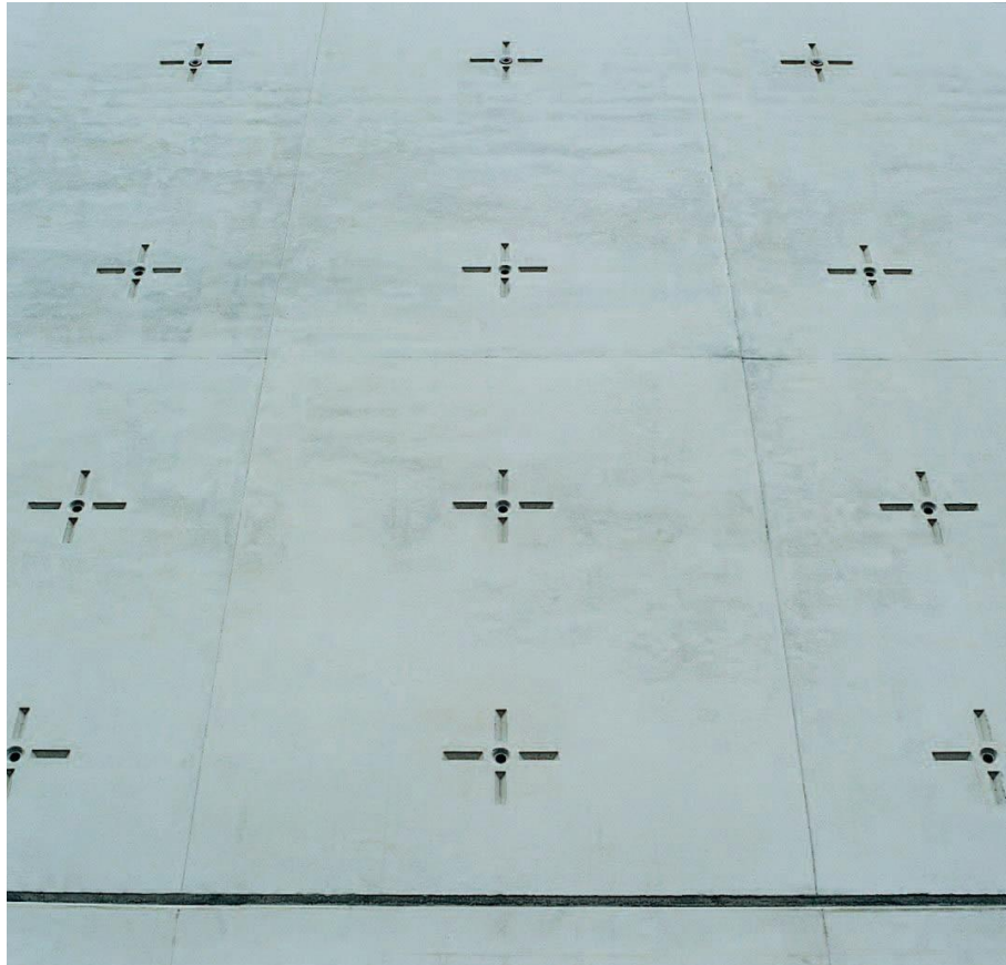
Resaltado de orificios de anclaje a dos caras. Iglesia San Casínio, Berlin. Dr. Ing. Diethelm Bosold.
