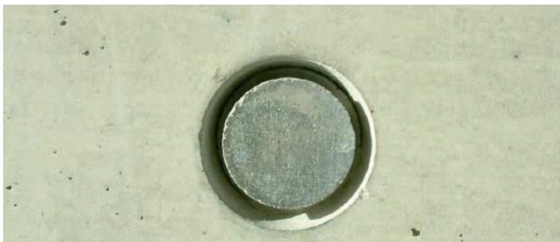
Tapón prefabricado. Dr. Ing. Diethelm Bosold.
