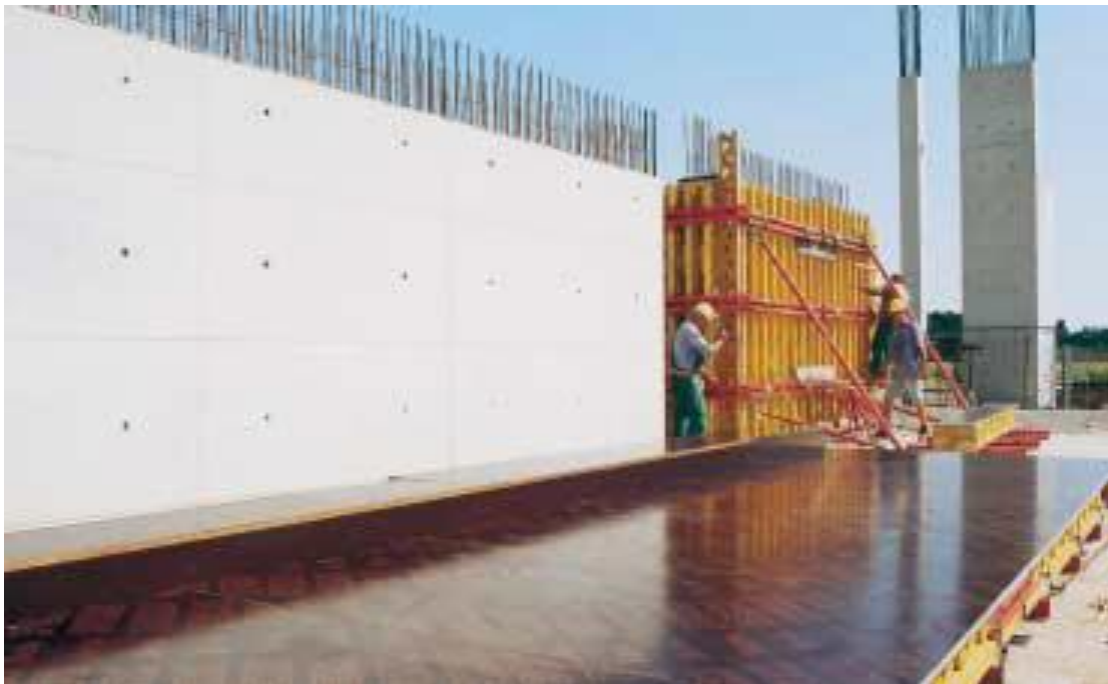
Encofrado de vigas con forro contrachapado con recubrimiento de resinas (PERI)
