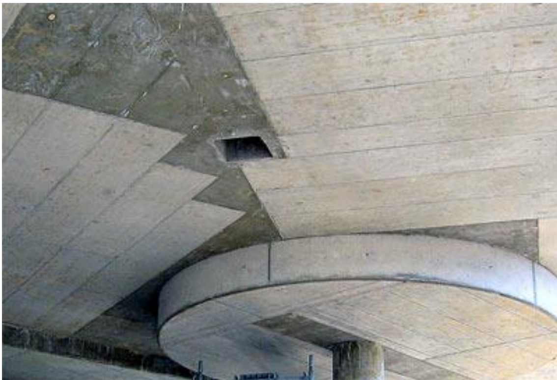
Losa encofrada con tableros nuevos y usados. (DOKA)
