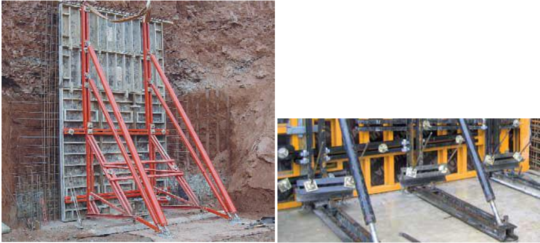
Conjunto de escuadras y detalle de perfiles de reparto en anclajes (Alsina, ULMA)
