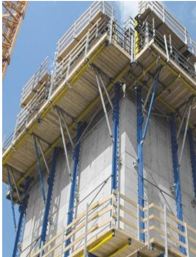
Configuración de elementos y ejemplo de aplicación (ULMA, DOKA)
