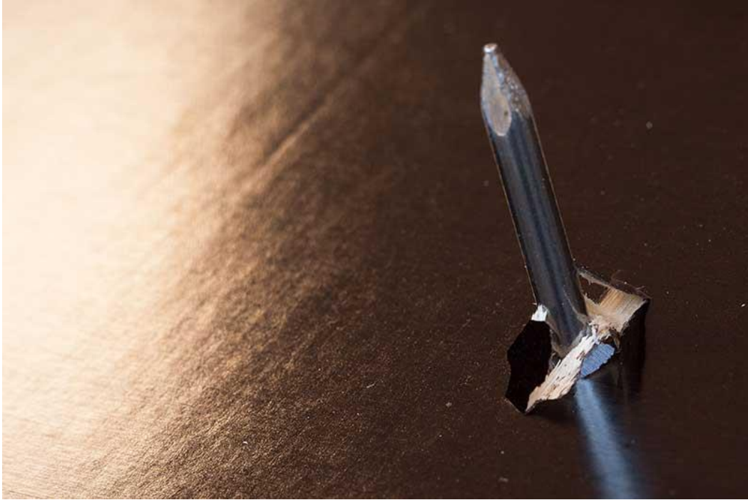
Descascarillado del recubrimiento de resinas de un forro contrachapado.
