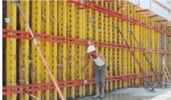
Encofrado de vigas con vigas de tipo celosía (PERI)
