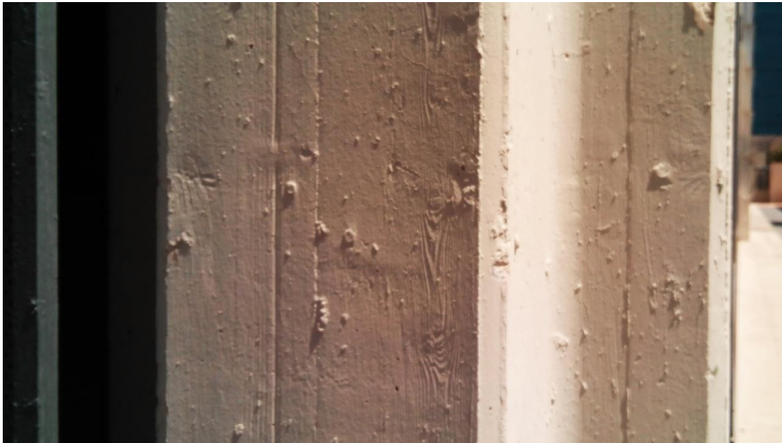
Pilar pintado. Biblioteca general, fachada oeste. UPV.
