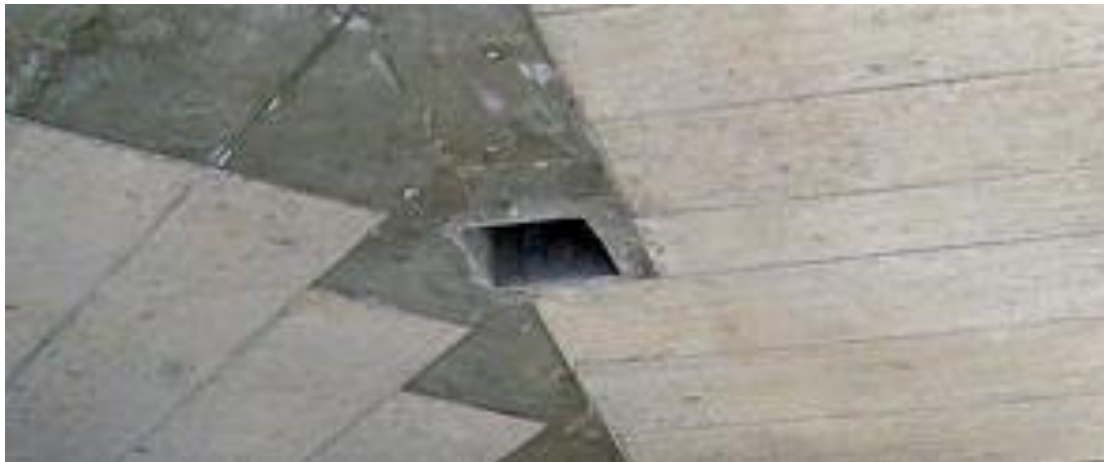
Huella de tablero tricapa de diferentes edades (DOKA)
