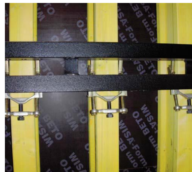
Detalle de rieles y elementos de unión de vigas y rieles (ULMA)
