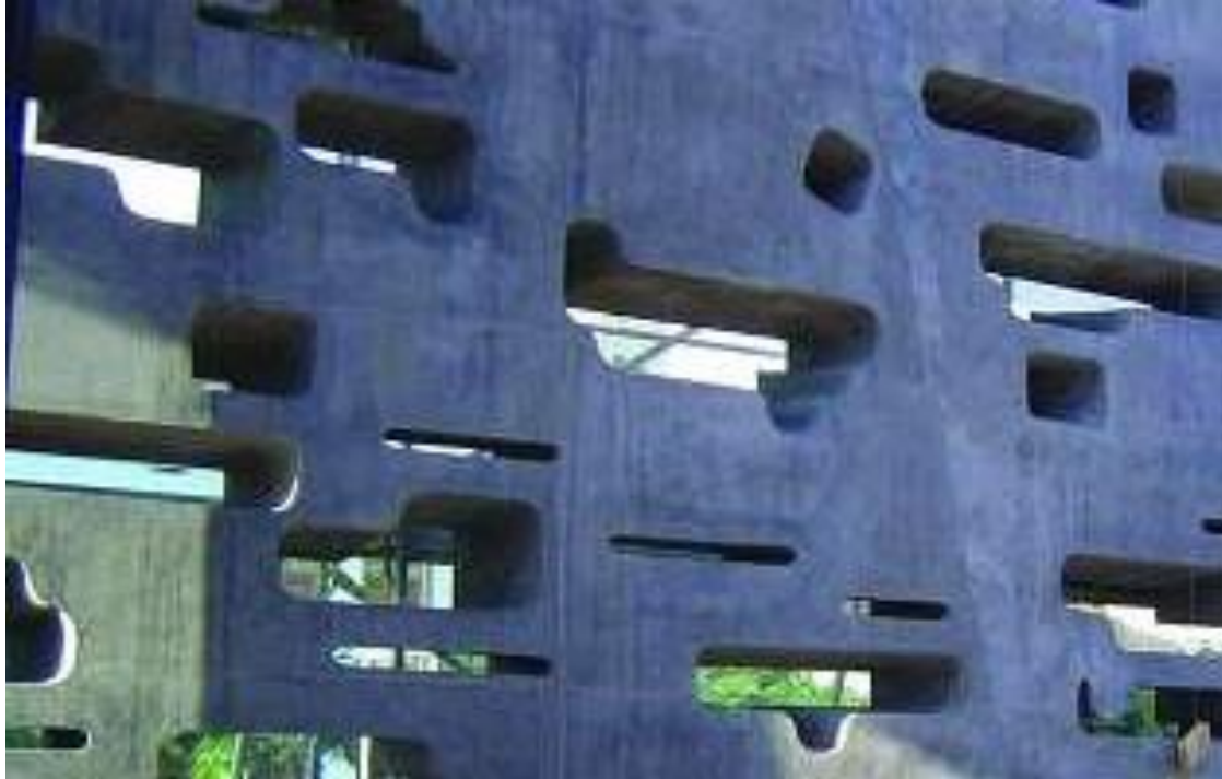
Muro con huecos pasantes hormigonado con HAC. Enrique Alario.
