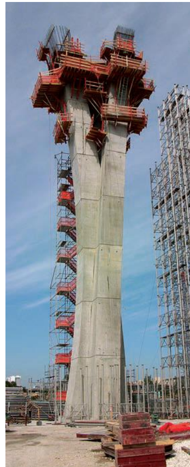
Aplicación de plataformas de trepa (ULMA, Alsina)
