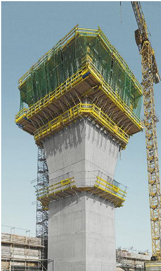
Aplicación de plataformas de trepa (ULMA, Alsina)
