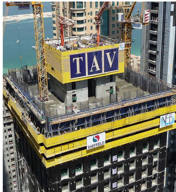
Sección del sistema y aplicación en núcleo de edificio alto (PERI, DOKA)
