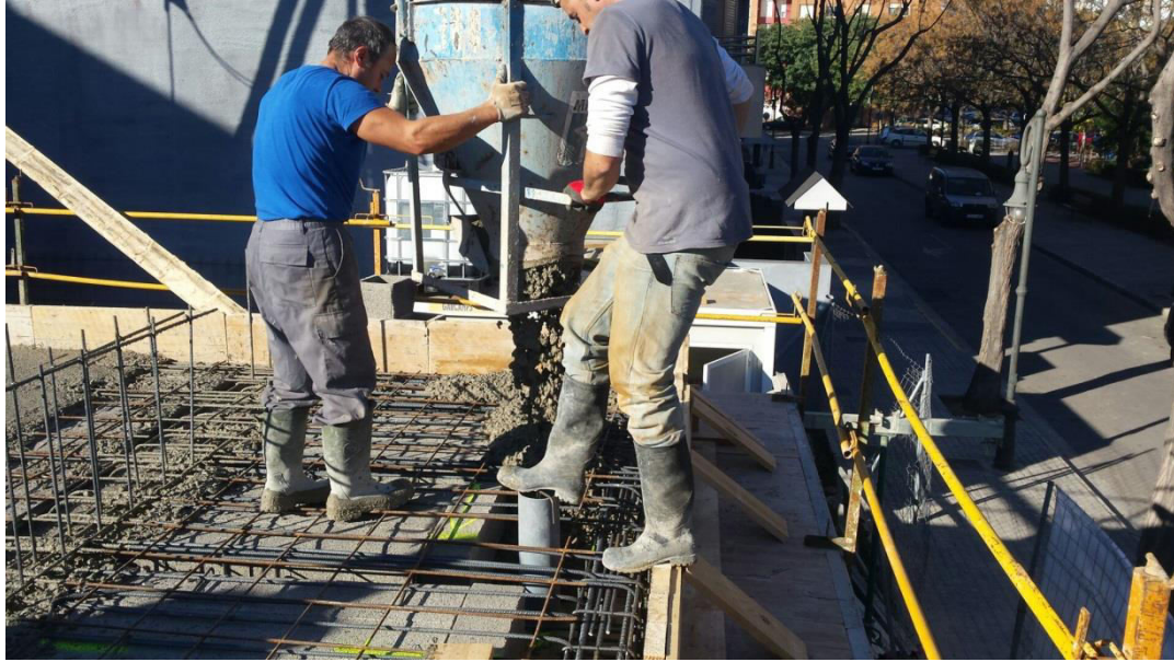
Imagen 3.5. Hormigonado del forjado de planta primera con cubilote
