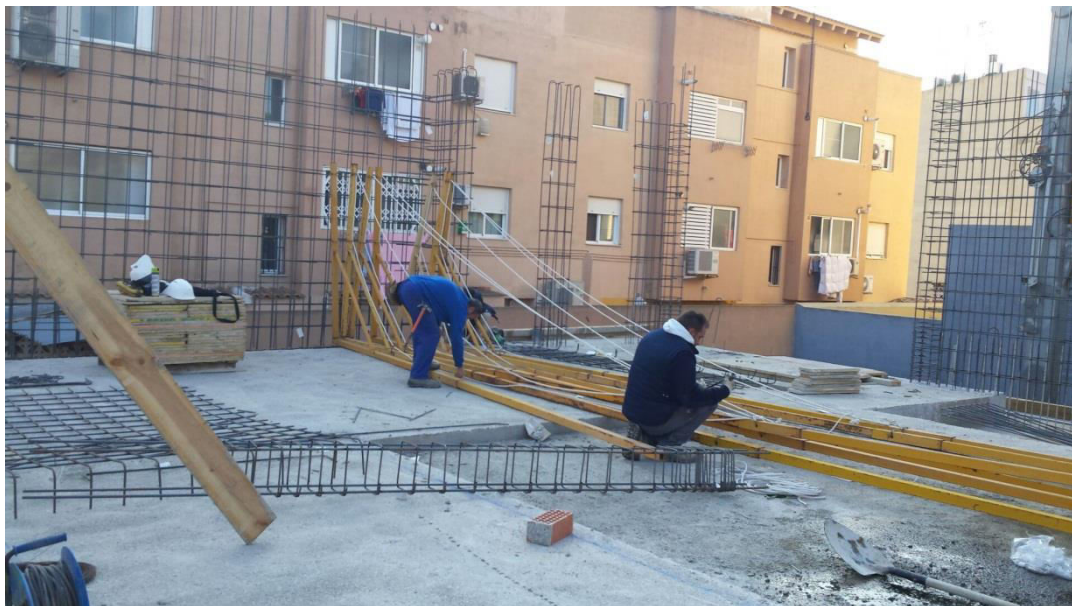
Imagen 3.10. Preparación de la red de seguridad
