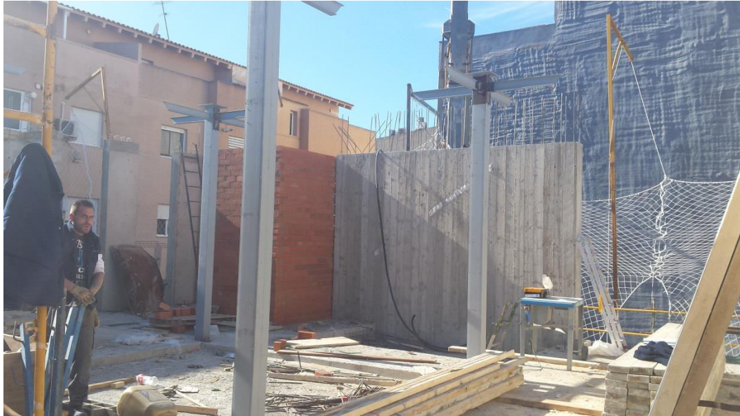
Imagen 3.17. Disposición de pilares metálicos
