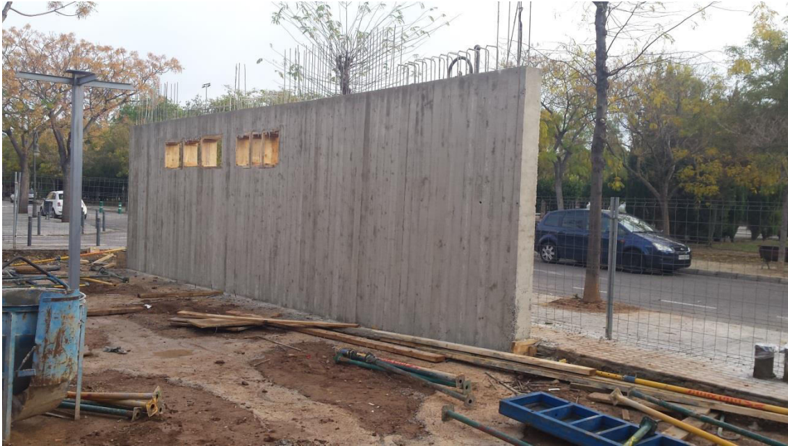
Imagen 1.15. Desencofrado de muros con esperas para planta superior
