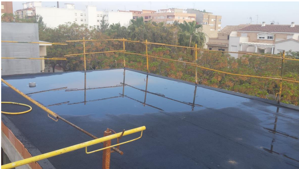
Imagen 3.62. Prueba de estanquidad de cubierta
