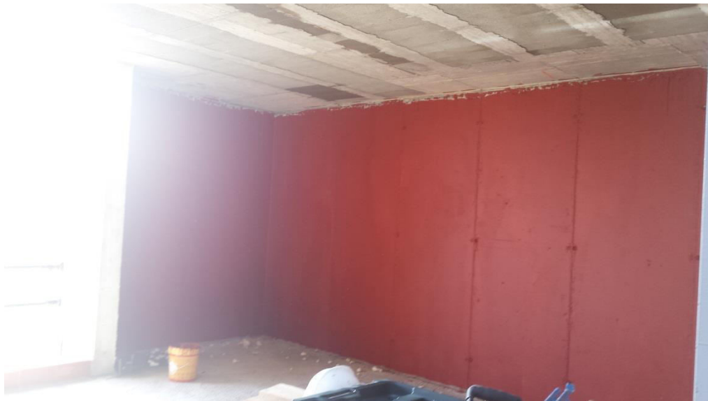
Imagen 3.46. Pintado por la parte interior de los cerramientos con pintura impermeable, se ha de pintar parte del forjado superior e inferior
