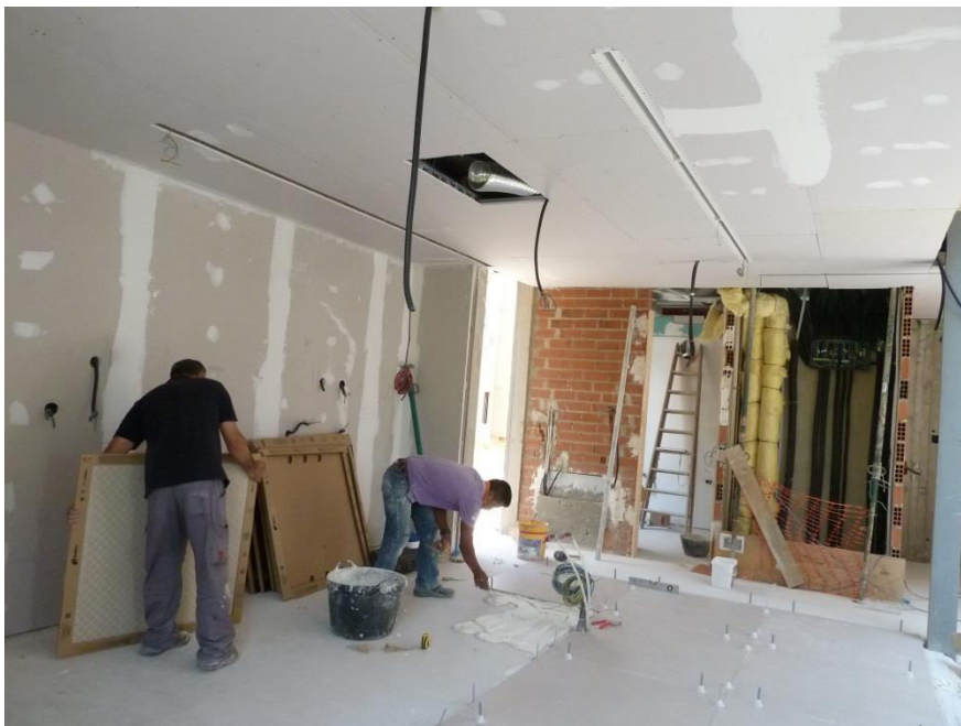
Imagen 3.78. Proceso de ejecución del solado, colocando el adhesivo
