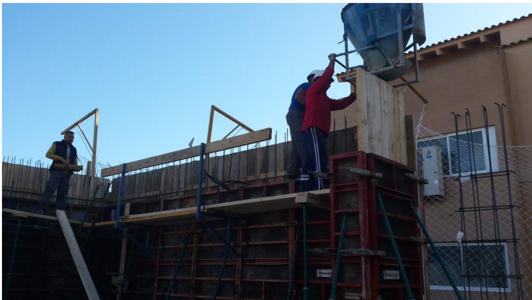
Imagen 3.14. Hormigonado del muro con el cubilote
