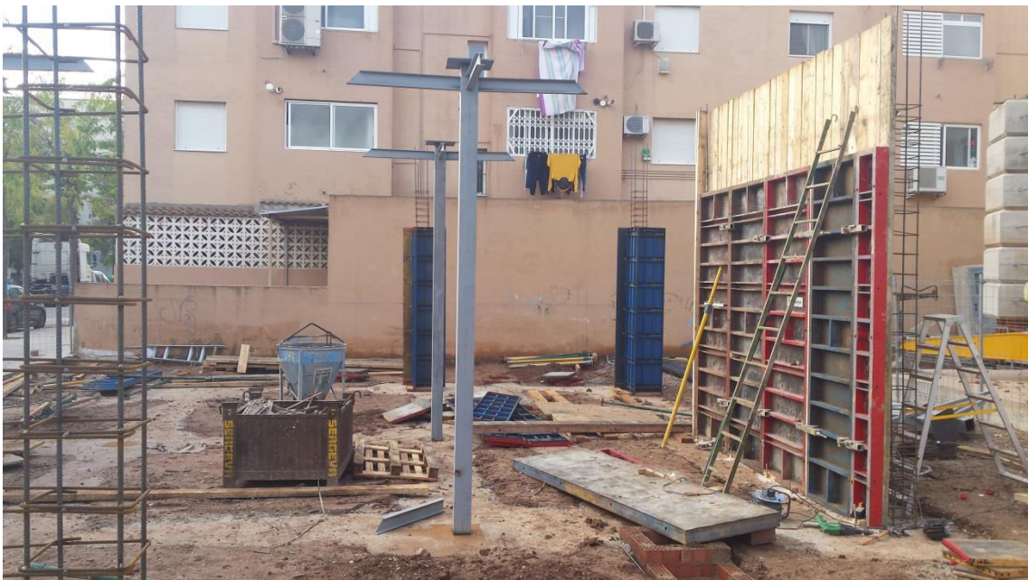
Imagen 1.14. Inicio de colocación de pilares metálicos
