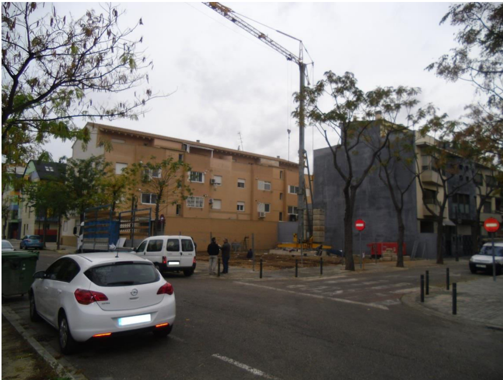
Imagen 1.12. Colocación de grúa torre con contrapeso sobre zapata de apoyo
