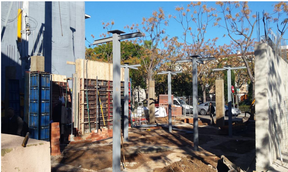
Imagen 1.16. Colocación pilares metálicos
