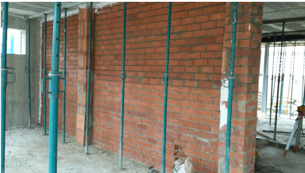
Imagen 3.26. Ejecución muro de fábrica que separa el garaje
