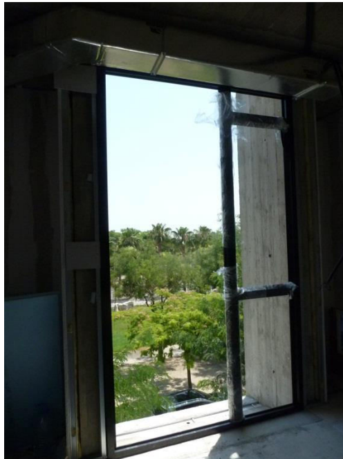
Imagen 3.75. Colocación de carpintería metálica exterior
