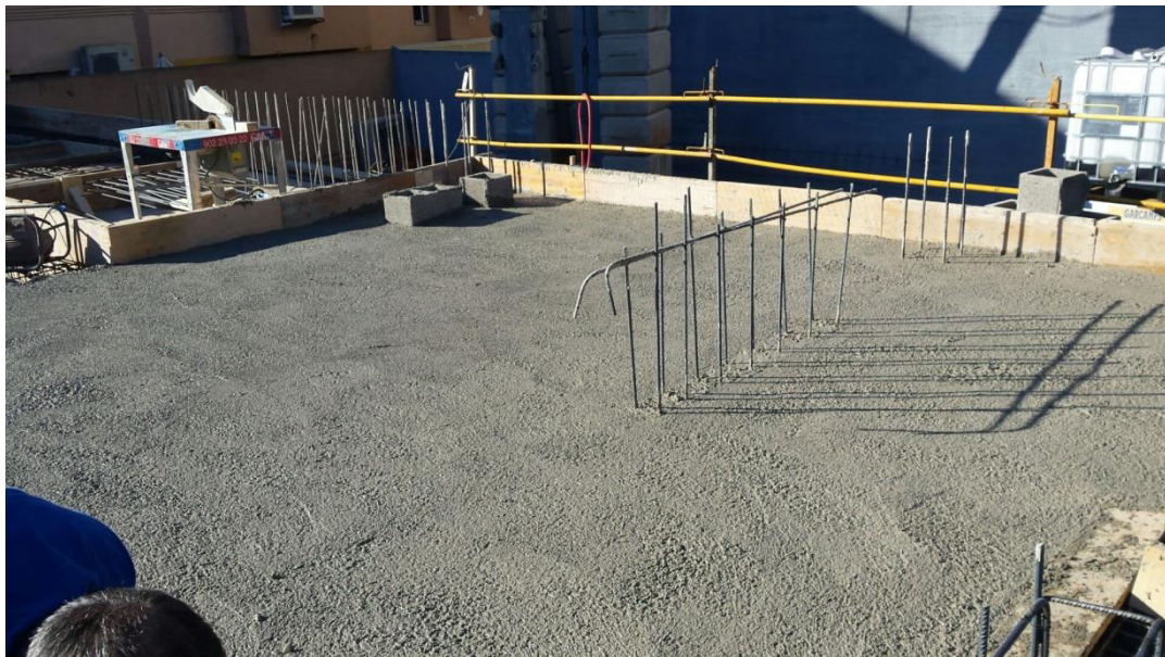
Imagen 3.6. Continuación del hormigonado, se observan esperas de muros y soportes.
