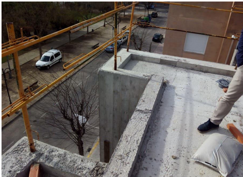
Imagen 3.50. Mala resolución de las medidas de seguridad dejando ese hueco sin protección
