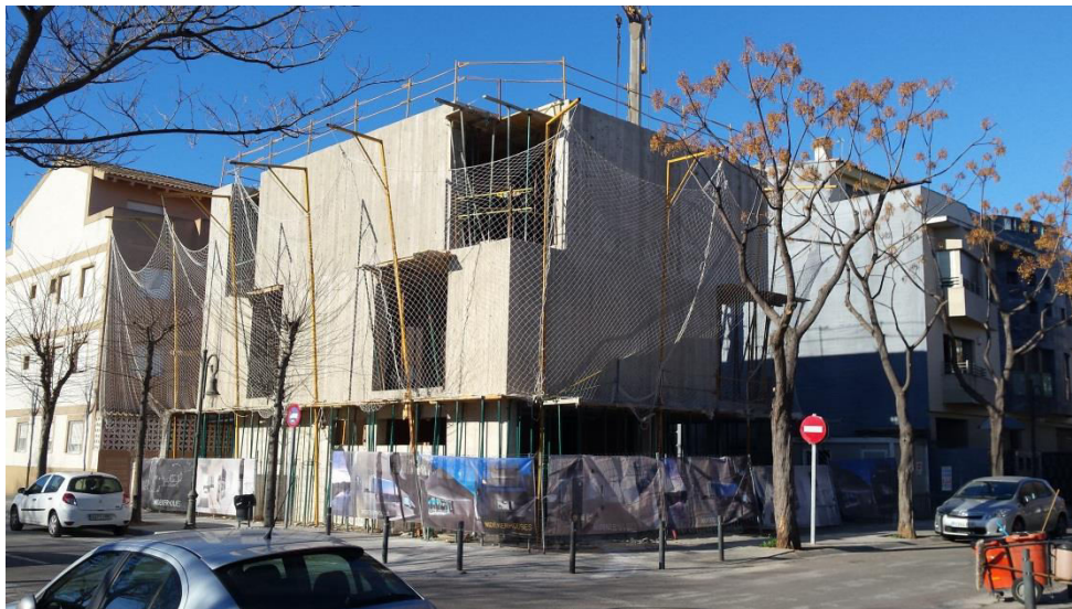
Imagen 3.42. Mantenimiento de encofrado y puntales en puntos singulares
