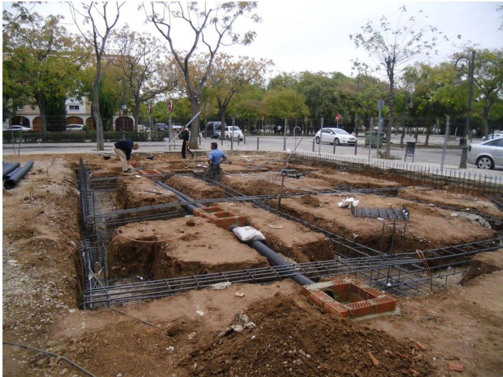
Imagen 1.9. Armado de zapatas y vigas de atado
