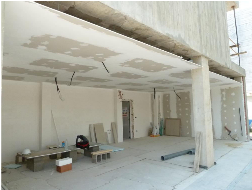
Imagen 3.71. Falsos techos de planta baja
