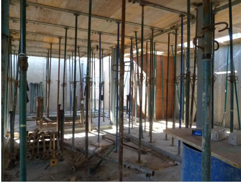
Imagen 3.19 Puntales y colocación del encofrado.
