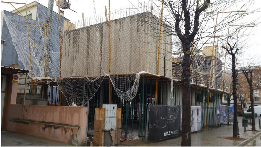
Imagen 3.15. Desencofrado de esta parte del muro
