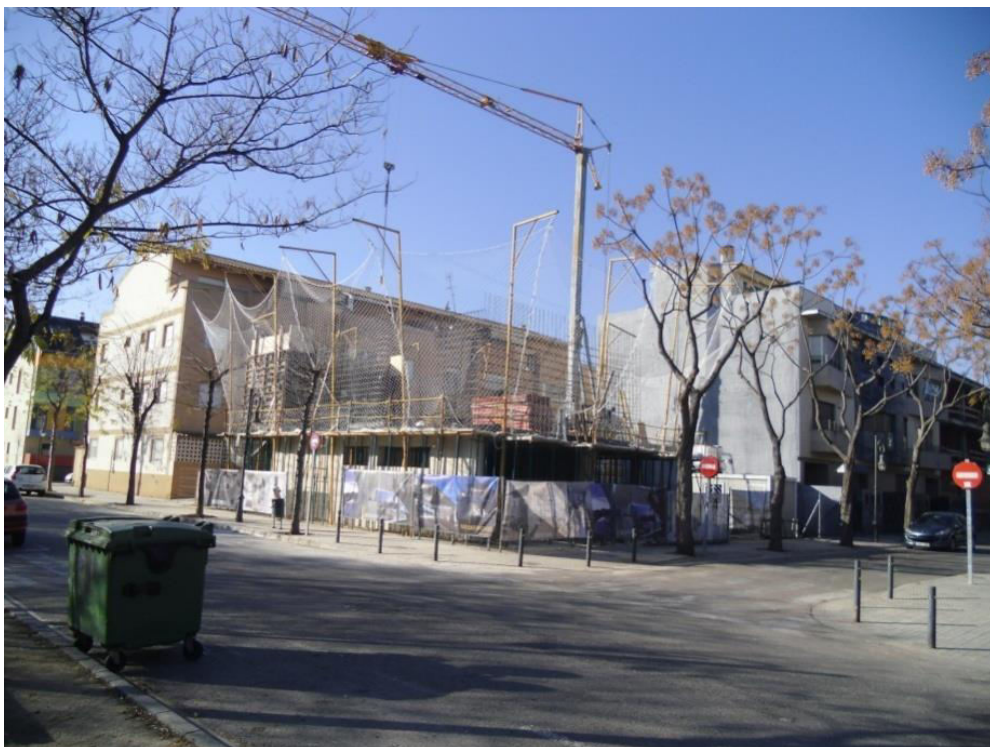
Imagen 3.12. Colocación de red de seguridad
