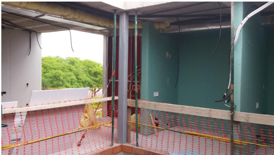
Imagen 3.70. Colocación del laminado de yeso hidrófugo en tabiquería de zonas humedad
