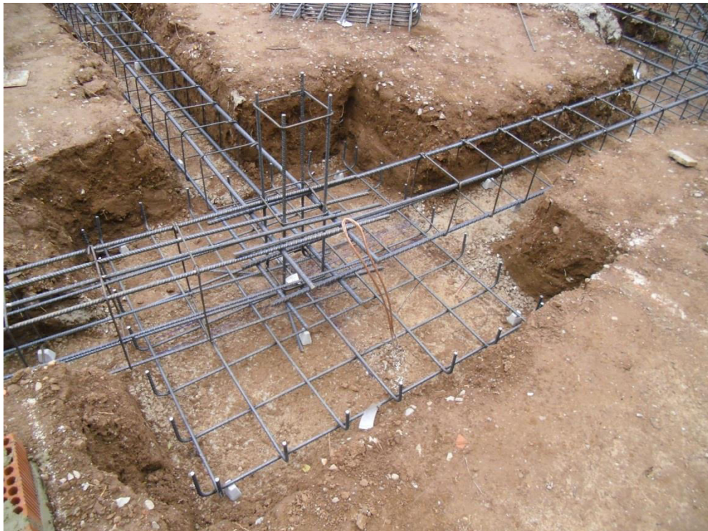
Imagen 1.10. Armado de zapata centrada con vigas de atado y esperas de pilar
