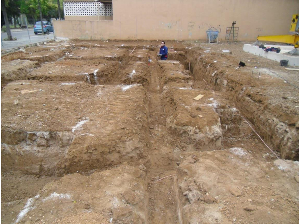
Imagen 1.7. Excavado de zapatas y vigas de atado
