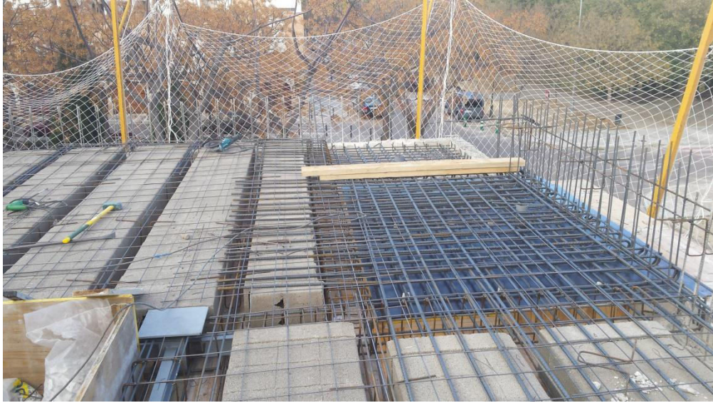
Imagen 3.21. Disposición de armaduras de losa
