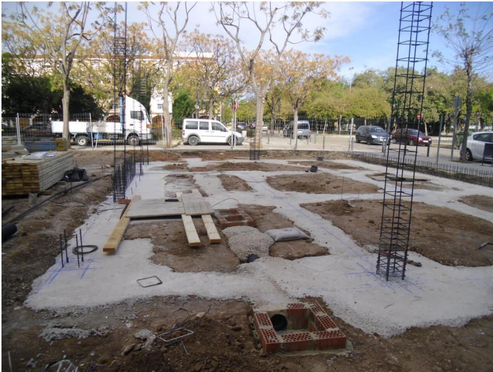
Imagen 1.11. Vertido de hormigón en zapatas y vigas de atado
