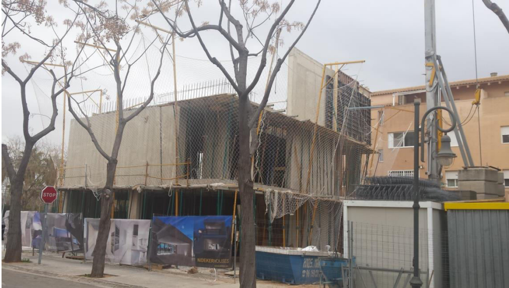
Imagen 3.27. Ejecución de muros, desencofrado
