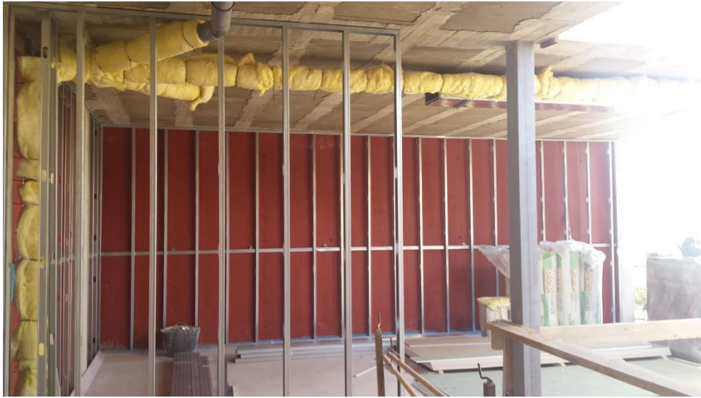
Imagen 3.65. Estructura portante del yeso laminado
