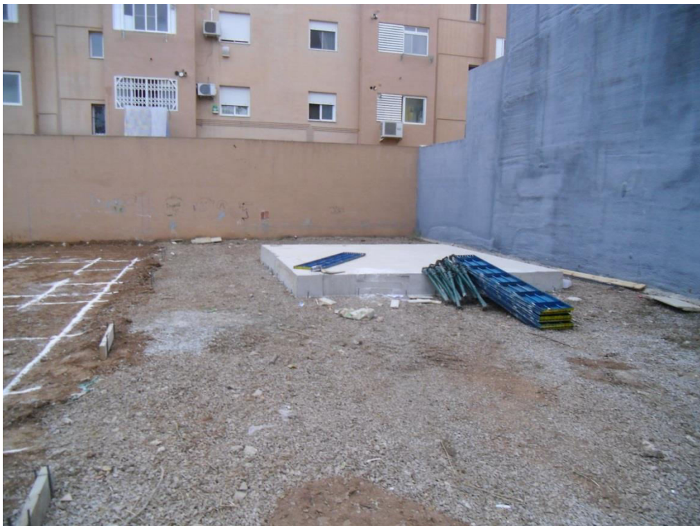
Imagen 1.6. Zapata de apoyo de grúa auto desplegable
