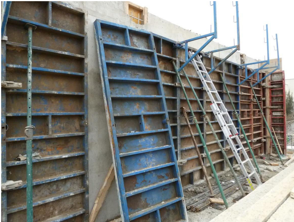
Imagen 3.32. Eliminación de planchas de encofrado
