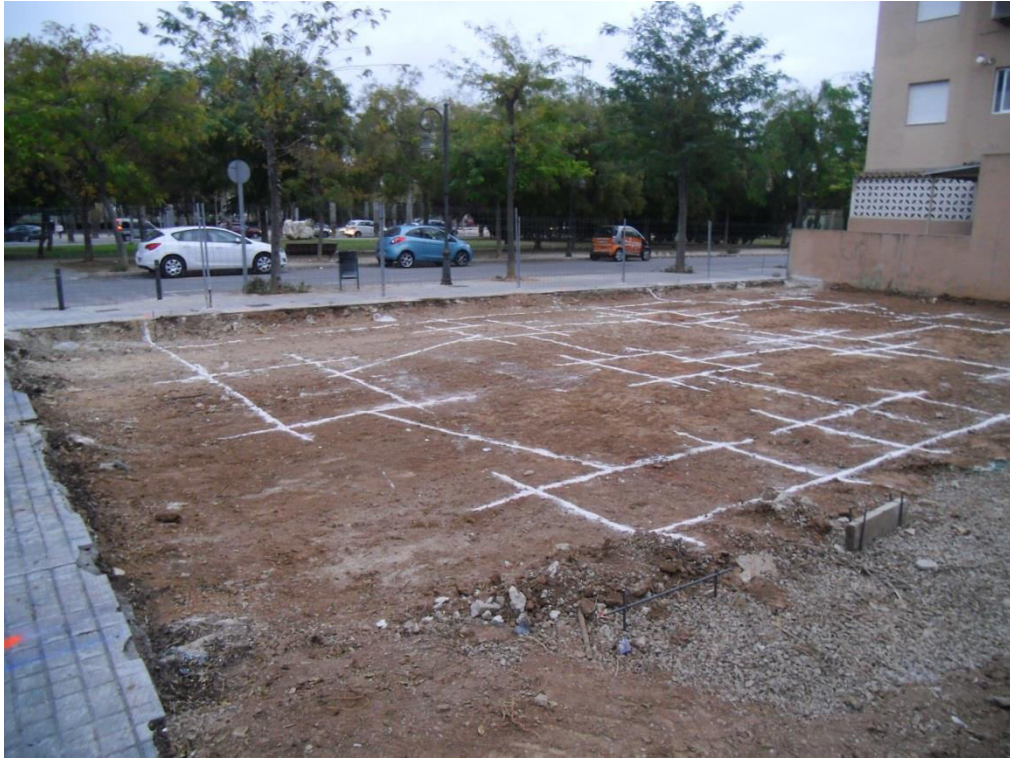
Imagen 1.5. Replanteo de la cimentación, zapatas y ejes de vigas de atado
