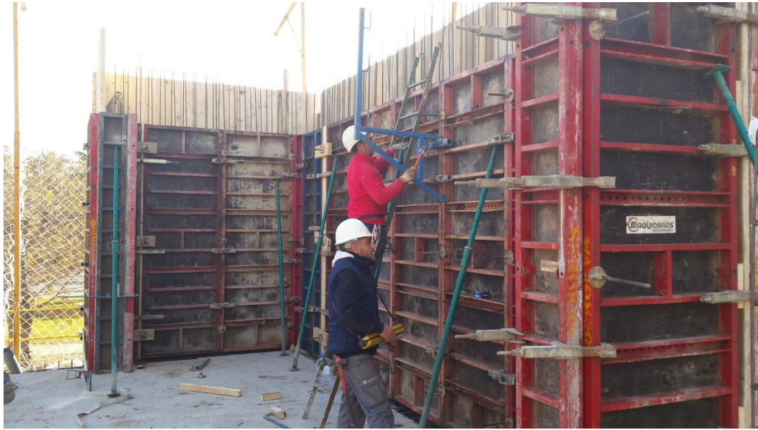
Imagen 3.13. Colocado el encofrado se coloca la pasarela para hormigonar.
