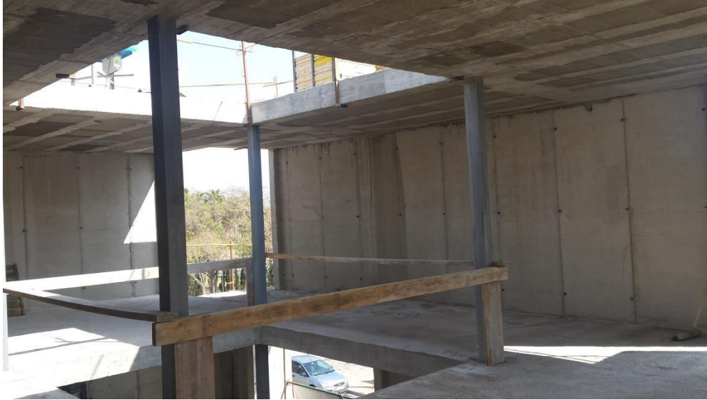
Imagen 3.45. Planta segunda limpia y la barandilla mal hecha
