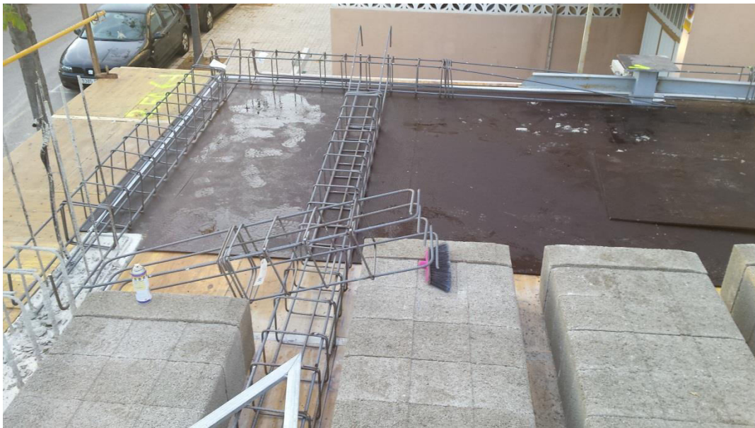
Imagen 3.2. Uniones de vigas con zuncho de borde
