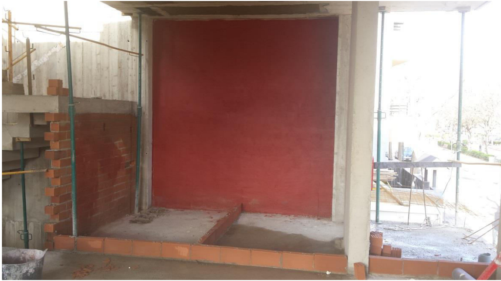
Imagen 3.41. Replanteo de estancias e inicio de impermeabilización de muros
