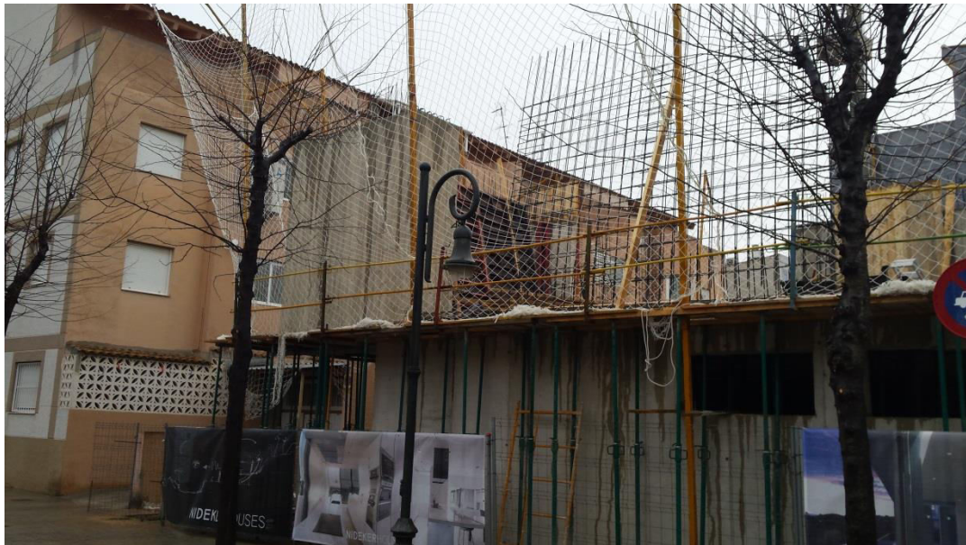
Imagen 3.16. Comprobación de todo lo ejecutado por si la lluvia había ocasionado algún desperfecto
