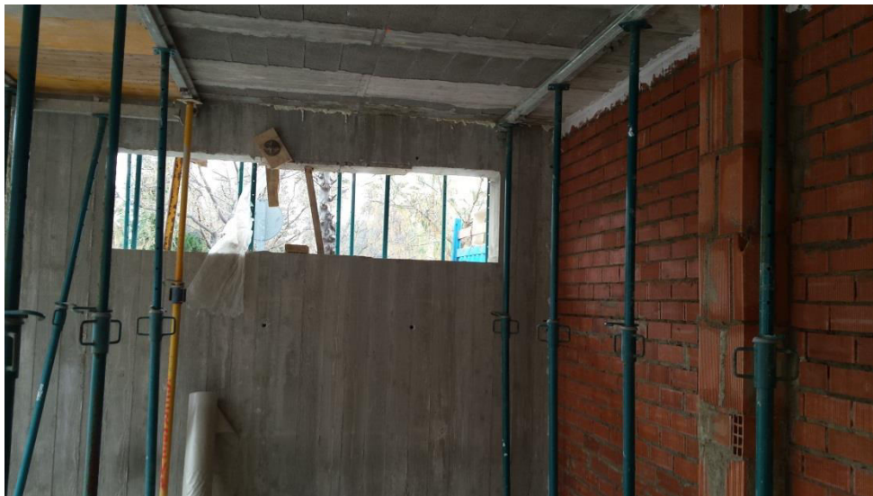
Imagen 3.44. Visualización de zonas donde retirar definitivamente el apuntalamiento
