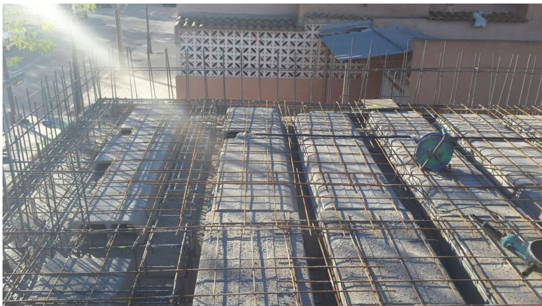
Imagen 3.4. Acabado del armado con la colocación de la armadura de reparto
