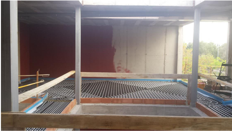
Imagen 3.61. Acabado del suelo radiante de planta segunda
