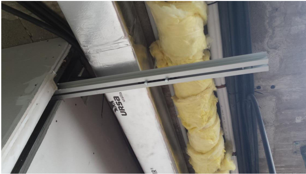
Imagen 3.67. Anclajes de paso instalaciones
