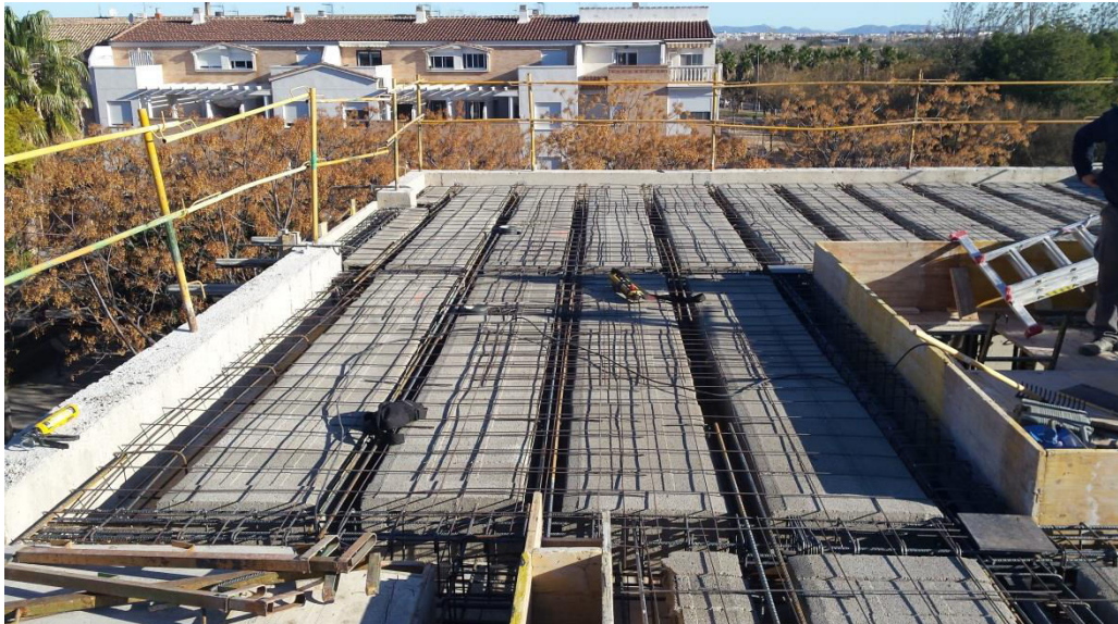
Imagen 3.39. Comprobación de las armaduras colocadas en el forjado, dimensión de vigas y zonas de acceso
