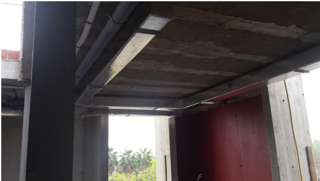
Imagen 3.58. Colocación de instalaciones en planta segunda
