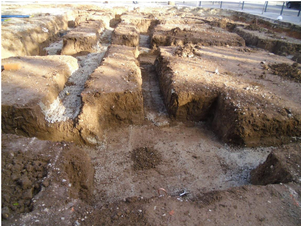
Imagen 1.8. Vertido de hormigón de limpieza
