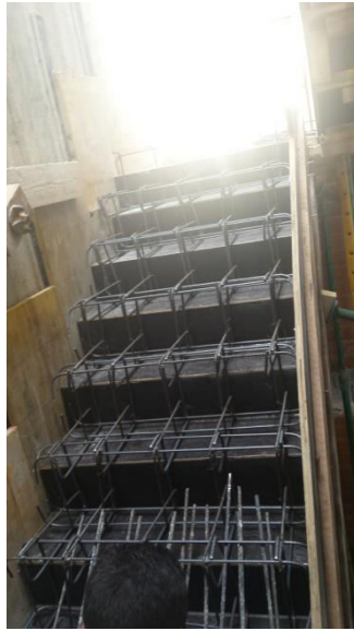
Imagen 3.35. Disposición de armaduras en escalera.
