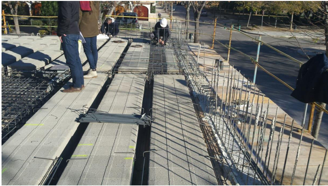
Imagen 3.3. Revisión de la dirección facultativa de la ejecución del forjado
