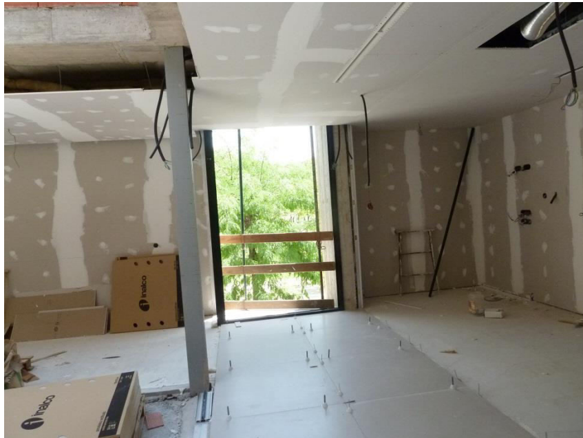
Imagen 3.77. Colocación del solado cerámico en cocina
