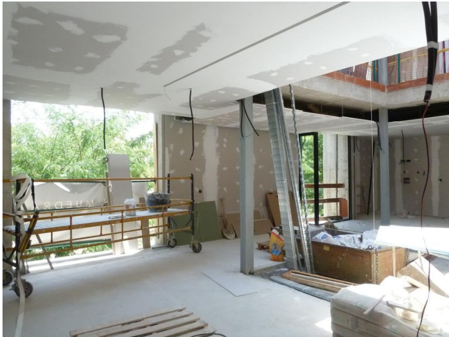
Imagen 3.73. Vista general de la colocación de falso techo en planta primera
