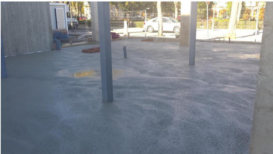
Imagen 1.18. Ejecución de solera
