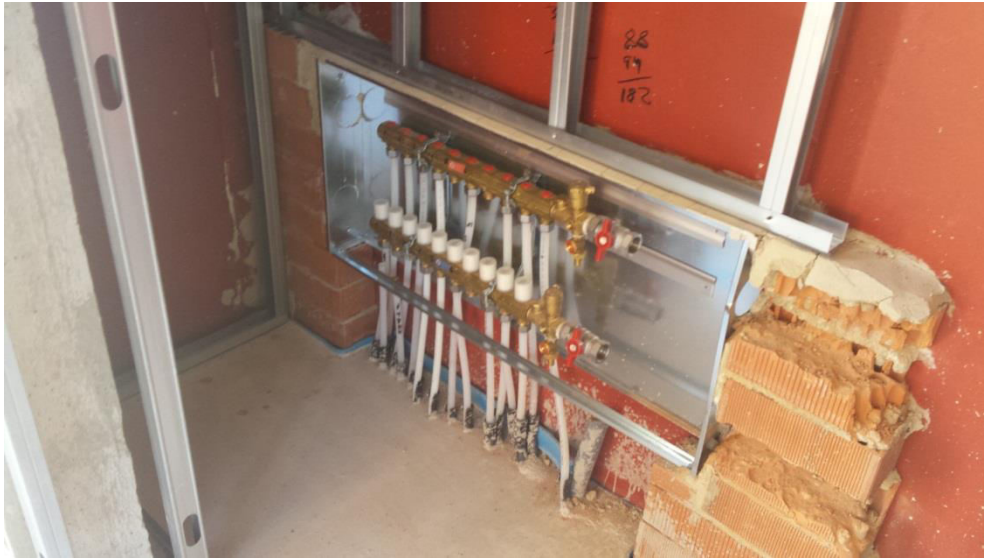
Imagen 3.63. Una vez endurecido el mortero encima del suelo radiante y conexiones acabadas
