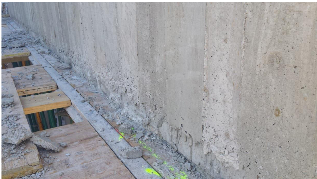
Imagen 3.18. Comprobaciones del correcto desencofrado
