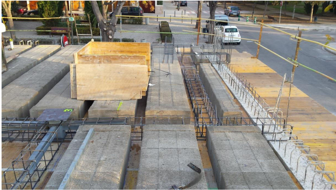
Imagen 3.1 Colocación de bovedillas
