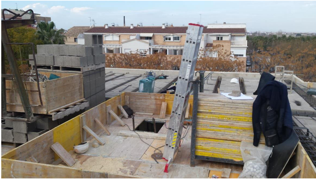
Imagen 3.37. Colocación de las bovedillas en forjado de cubierta
