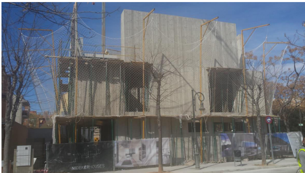
Imagen 3.34. Cosido de redes de seguridad
