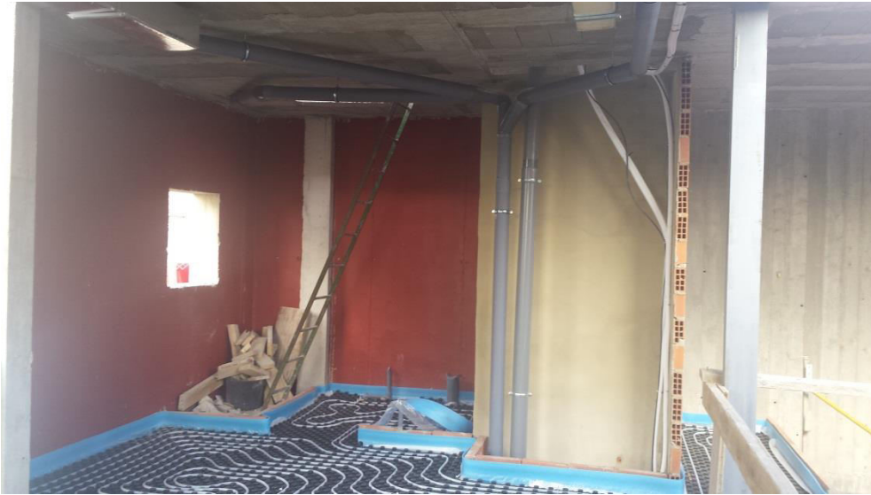
Imagen 3.59. Colocación del suelo radiante
