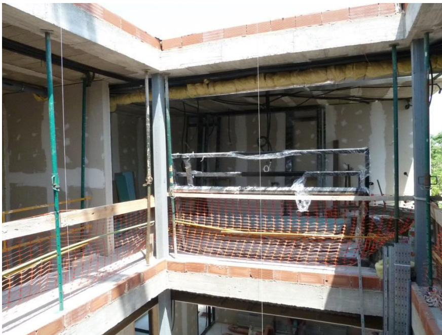
Imagen 3.74. Solución en planta segunda de la barandilla del patio de luces
