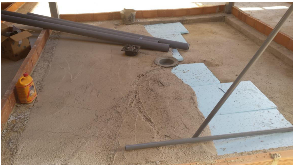
Imagen 3.56. Ejecución de la terraza del patio de luces en planta primera
