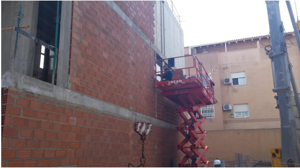
Imagen 3.43. Ejecución de la cara exterior de la medianera
