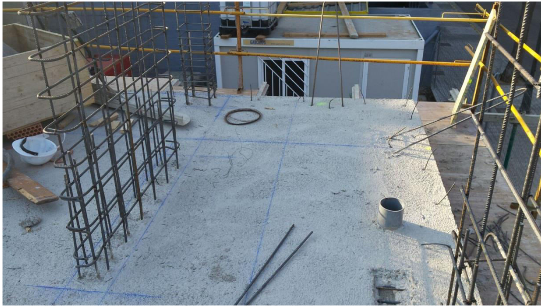
Imagen 3.9. Replanteo de muros y soportes
