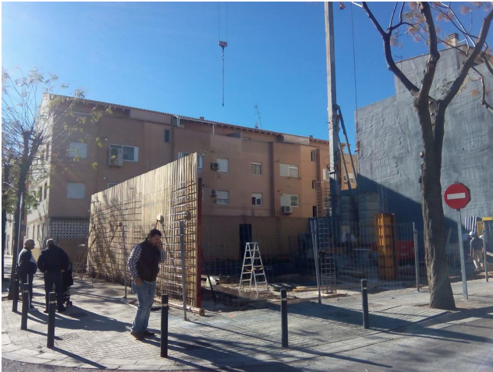
Imagen 1.13. Armado y encofrado de muros y pilares
