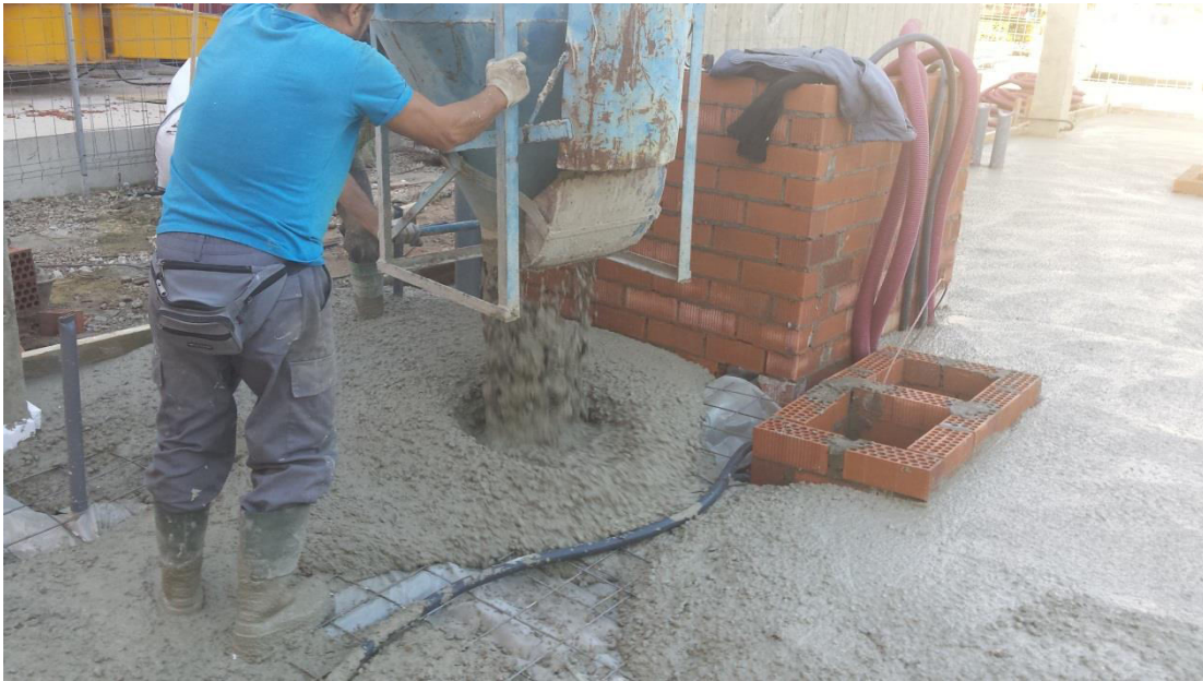
Imagen 1.17. Vertido de hormigón de solera
