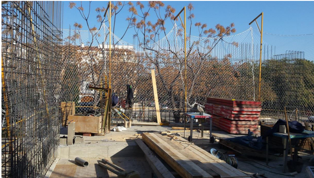
Imagen 3.11. Acabado del armado de los muros y soportes
