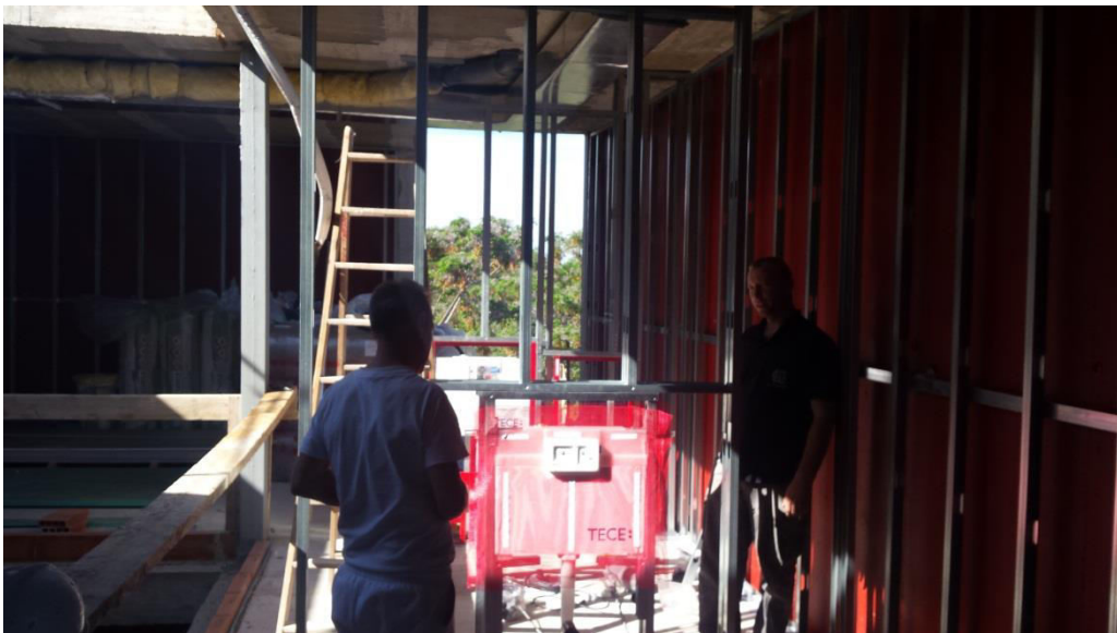
Imagen 3.66. Colocación de omegas en particiones interiores
