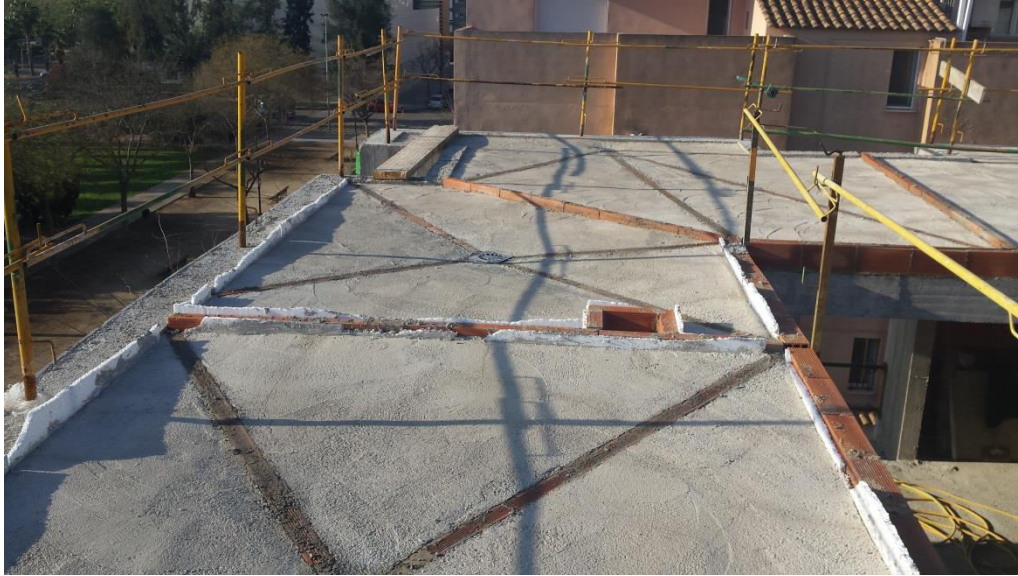
Imagen 3.51. Hormigón aligerado para formación de pendientes con aislante poliestireno expandido
