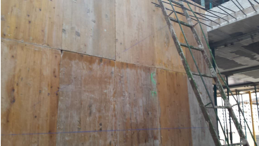
Imagen 3.25. Replanteo de la escalera en el encofrado vertical colocado
