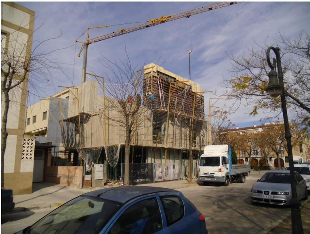
Imagen 3.30. Proceso de desencofrado de muros en planta segunda
