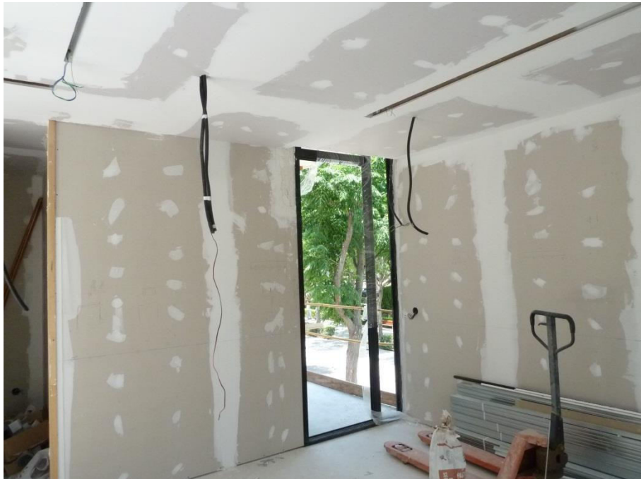
Imagen 3.79. Unión entre carpintería metálica y yeso laminado
