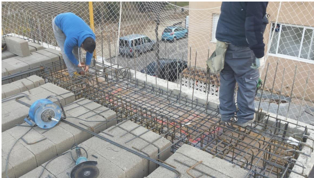
Imagen 3.22. Atado de cercos y comprobación de los refuerzos
