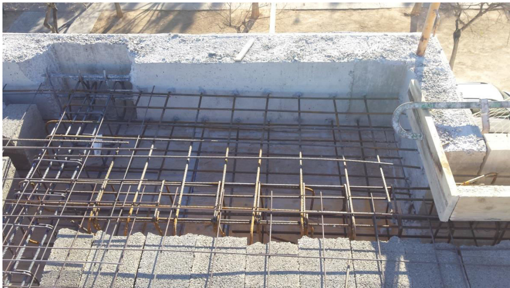
Imagen 3.36. Colocación de las armaduras y anclaje de barandilla en antepecho
