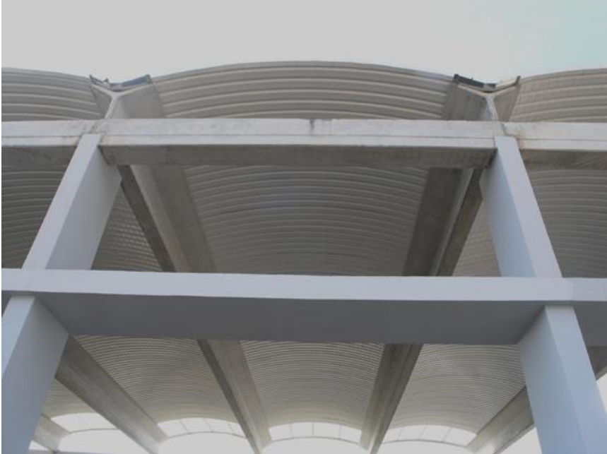
Fig. 5.7. Vigas de Hormigón prefabricado y cubierta membrana (HPM).
