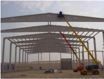
*Ilustración 62. Colocación Viga Delta. 2015. Fuente: [www.lufort.com](http://www.lufort.com)*
