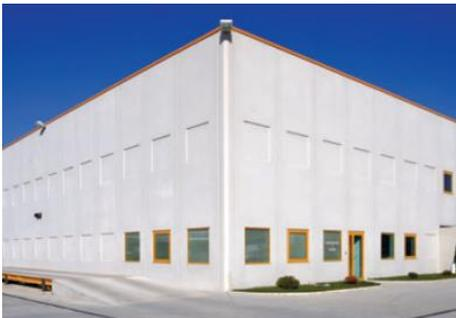
*Ilustración 11. Paneles de Cerramiento Verticales. 2010 Fuente: Catálogo Riphorsa*
