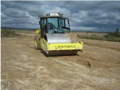
*Ilustración 52. Compactación terreno 2015. Fuente. Excavaciones Calavera*
