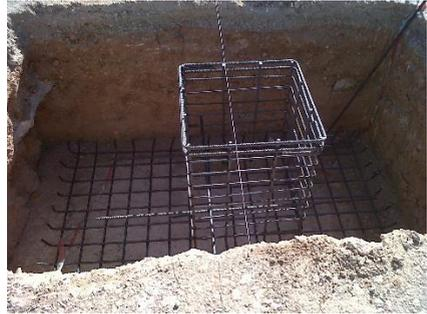
*Ilustración 54. Armadura zapata con cáliz. 2015. Fuente Propia*
