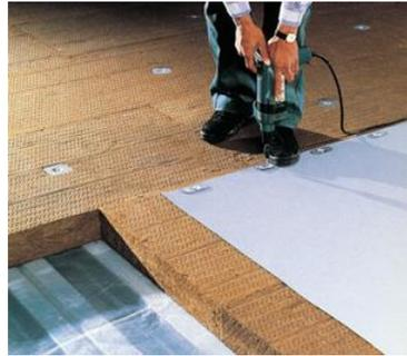
*Ilustración 69. Fijación aislamiento Cubierta Deck. 2015. Fuente: Isover*
