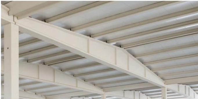
*Ilustración 16. Vigas Peraltadas. 2010. Fuente: Catálogo Riphorsa*
