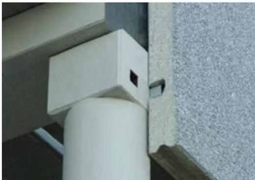
*Ilustración 42. Soportes circulares. Unión con panel de cerramiento. 2015. Fuente: Catálogo Riphorsa*
