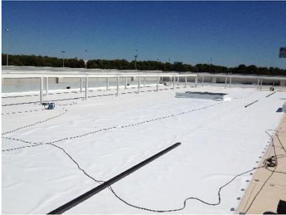
*Ilustración 70. Colocación lamina Impermeabilizante.2015. Fuente. Propia*
