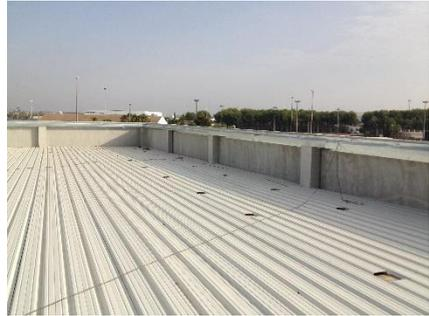
*Ilustración 67. Izado y montaje de la chapa de cubierta. 2015. Fuente: Propia*
