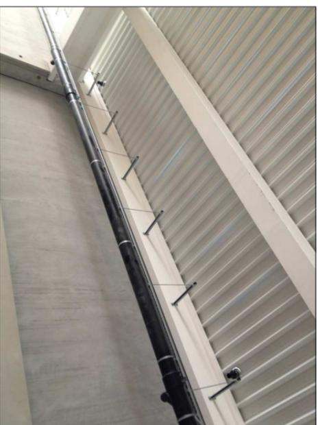
IMÁGENES DEL SISTEMA DE SUECIÓN DE TUBERÍA INTERIOR A UTILIZAR
