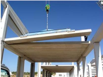
*Ilustración 59. Colocación Placa alveolar*
