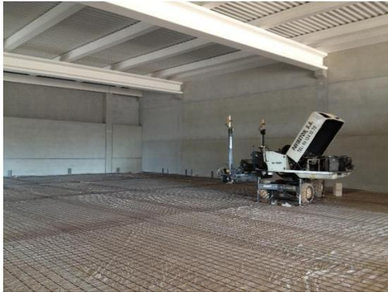
*Ilustración 72. Colocación de la lámina y armadura. 2015. Fuente: Propia*
