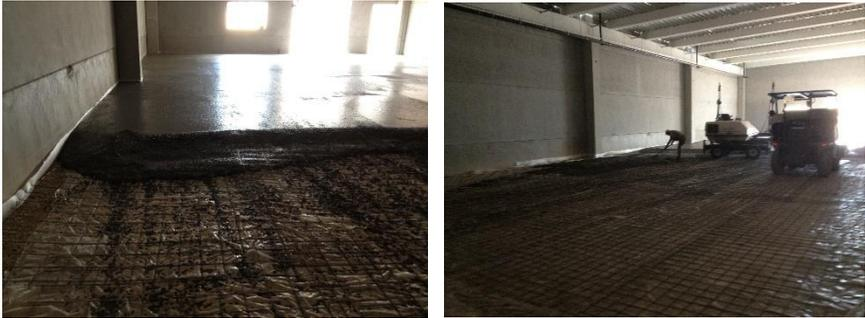
*Ilustración 73. Hormigonado solera. 2015. Fuente: Propia*
