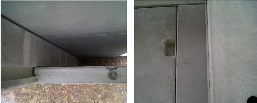
*Ilustración 49. Unión entre Paneles. 2015. Fuente: Propia*
