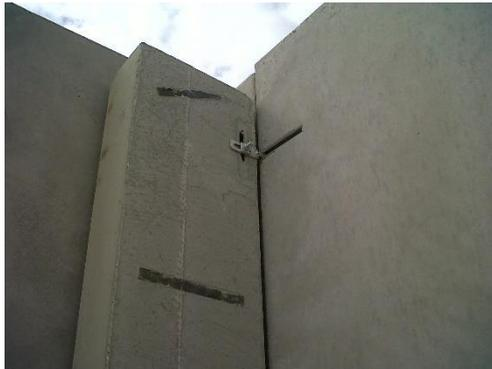
*Ilustración 66. Unión soporte-panel de cerramiento. 2015 Fuente: Propia*
