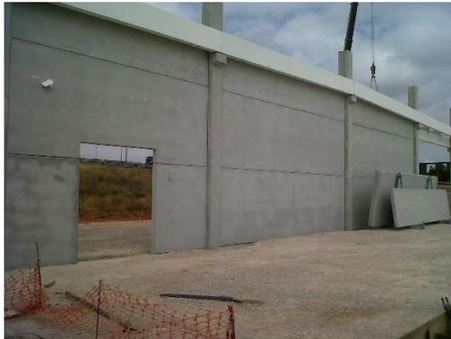
*Ilustración 65. Montaje paneles de cerramiento. 2015. Fuente: Propia*
