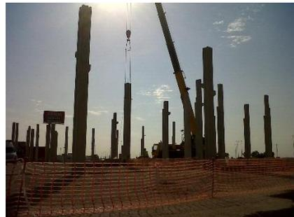
*Ilustración 56. Izado y colocación de soportes. 2015. Fuente Propia*
