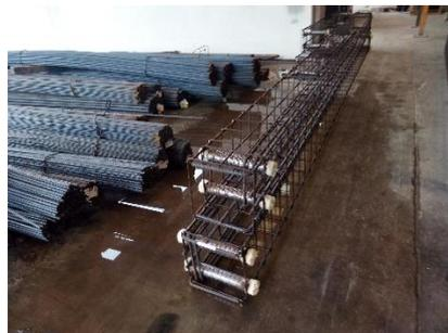
*Ilustración 24. Armado pilar y viga.2015. Fuente: Propia*
