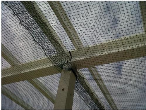
*Ilustración 75. Red horizontal de seguridad. 2015. Fuente Propia*
