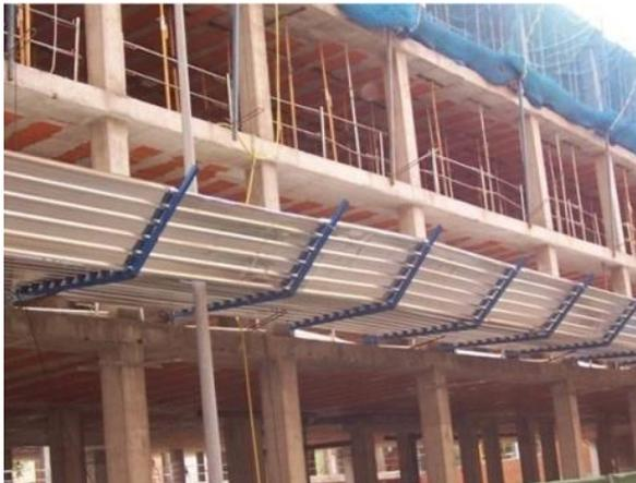
*Ilustración 78. Marquesina de seguridad. 2015. Fuente: [www.lineaprevencion.com](http://www.lineaprevencion.com)*
