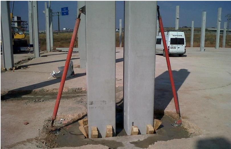
Ilustración 39. Cimentación por cáliz con doble soporte. 2015. Fuente: Propia
