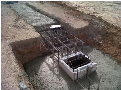
*Ilustración 55. Hormigonado zapatas y vigas riostras.2015.Fuente Propia*
