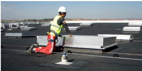
*Ilustración 77. Línea de vida. 2015. Fuente: [www.lineasdevidaparacubiertas.com](http://www.lineasdevidaparacubiertas.com)*
