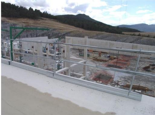
*Ilustración 76. Barandilla de Seguridad. 2015. Fuente: [www.lineaprevencion.com](http://www.lineaprevencion.com)*
