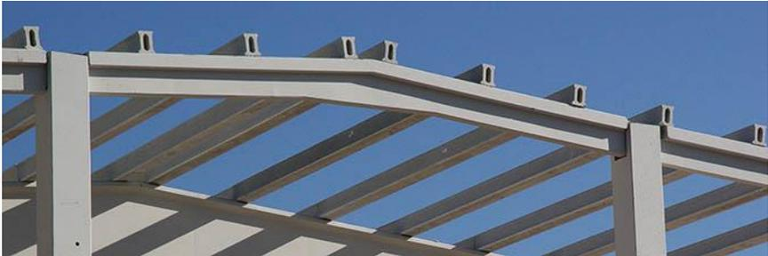
*Ilustración 64. Correas colocadas en Vigas Hastiales y Delta. 2015. Fuente: Prefabricados aljema*
